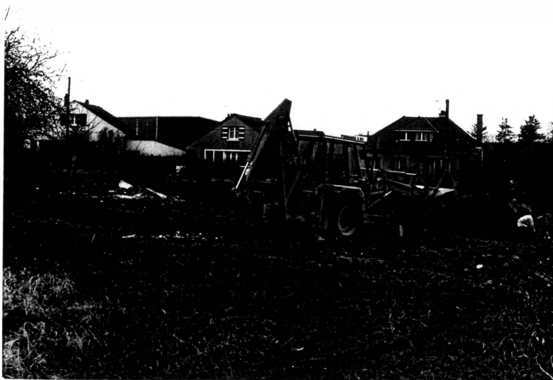
Début des opérations de décapage (partie Est)
