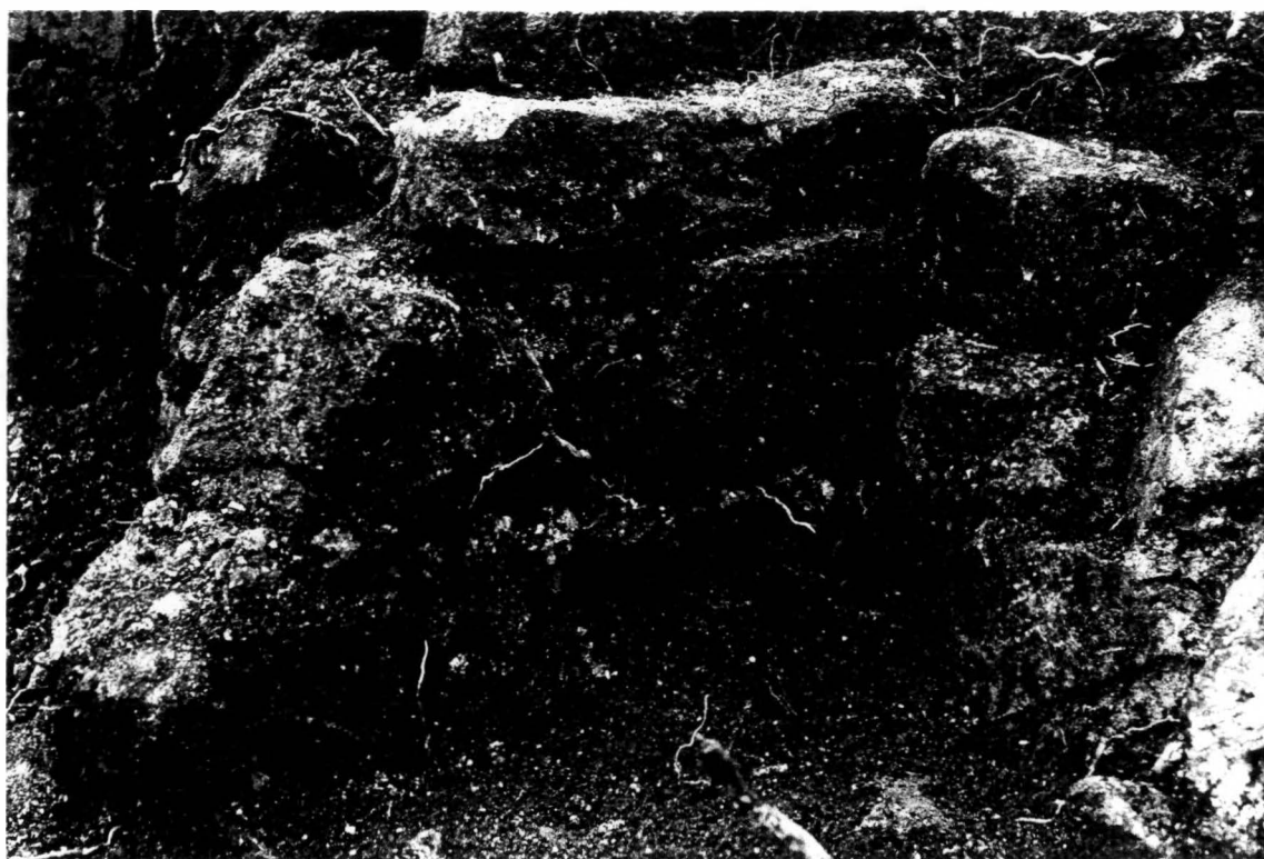
Détail de l'appareil d'un mur apparaissant dans la coupe
