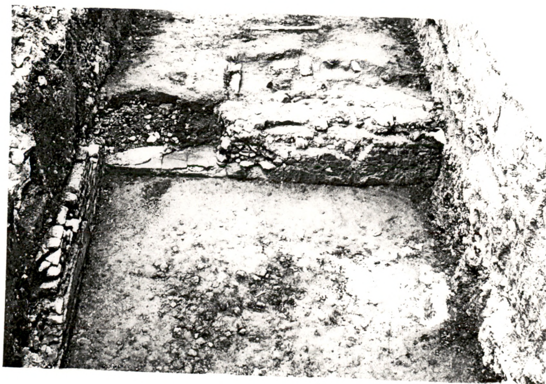
Démolition de la salle à mosaïque dite "des poètes grecs"
