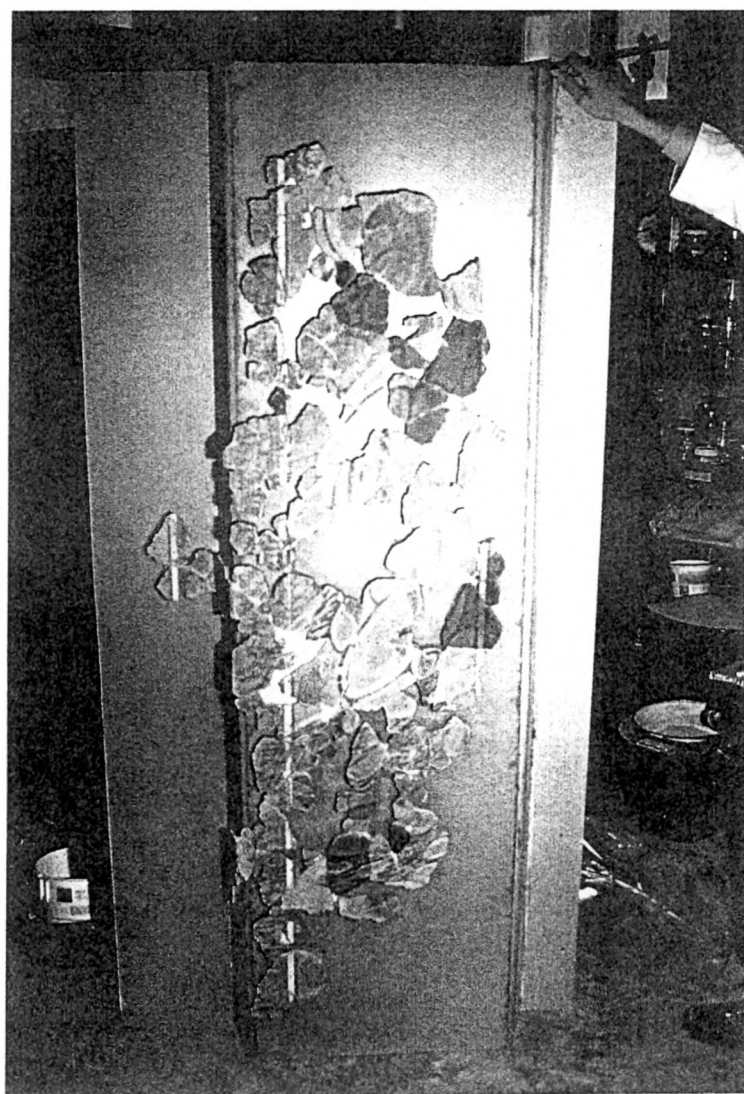
Fig. 7 : Les plaques sont fixées avec un adhésif époxyde sur le support en Aérolam qui restitue le volume du pilastre. (cliché B. Amadei)
