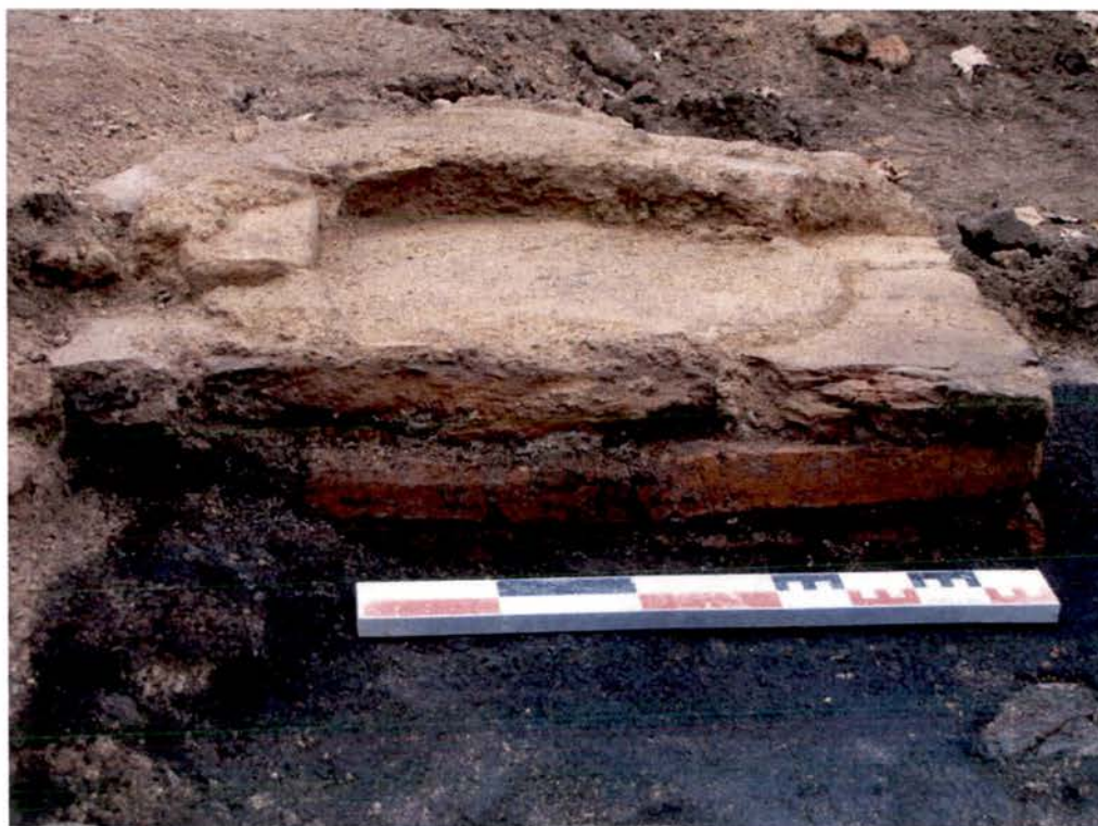
Cl. 56. Horizon 3, pièce 3. Elévation de l'aménagement maçonné A 4043 (briques liées au mortier) à l'angle sud de la pièce (4 assises en briques).
