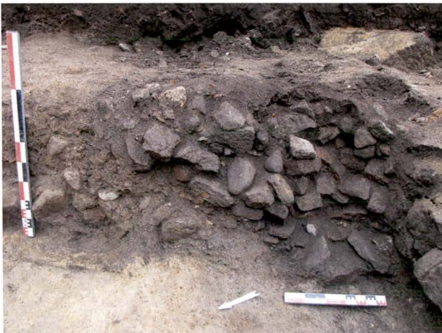
Cl. 14. Structures hydrauliques bordant le cardo C8. Vue de détail du comblement supérieur du caniveau longeant le stylobate occidental M8 (A 2068, A 2004).
