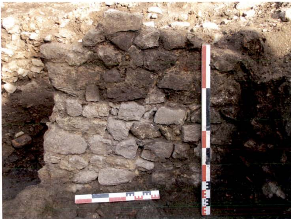
Cl. 66. Horizon 5, sondage 1. Élévation accessible du mur M5 ; la distinction entre fondations et élévation n'est pas claire.
