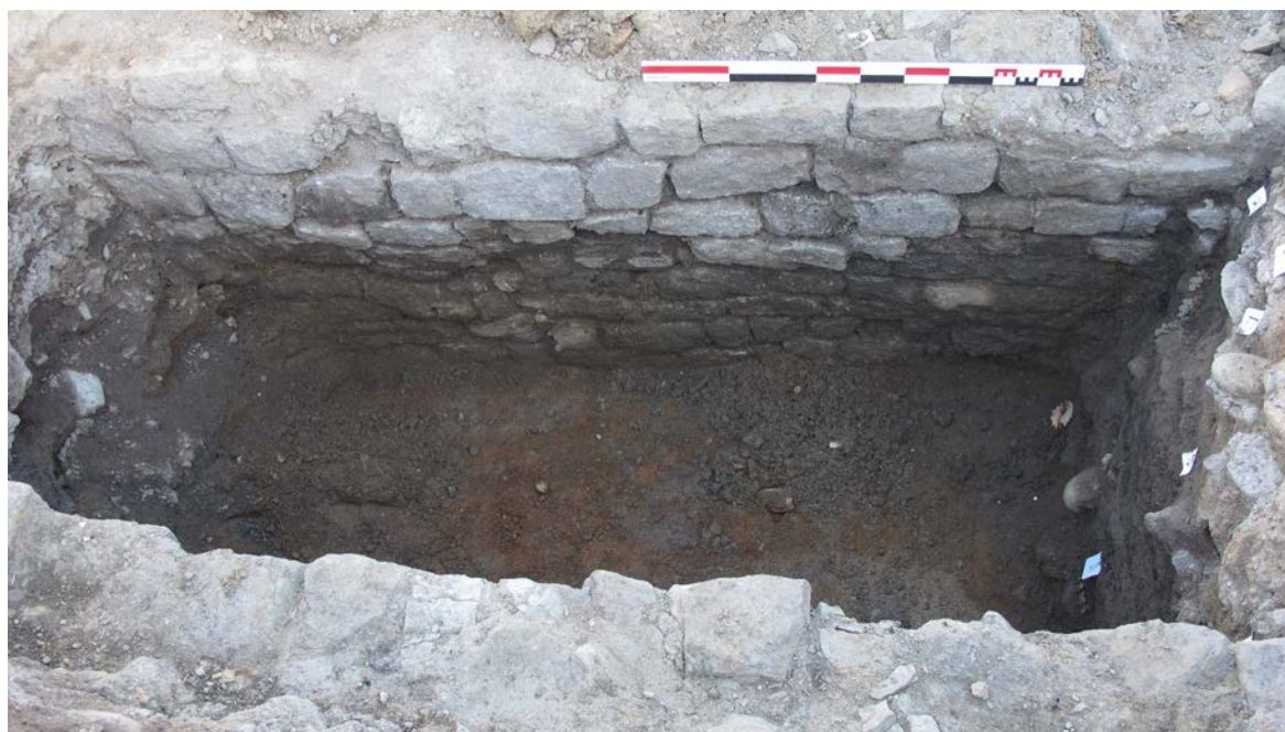
Fig. 24. Phase 1a. Sondage 1, égout maçonné St. 1 : parement du piédroit M2. Cliché Y. Labaune
