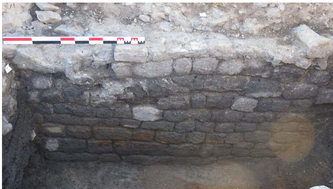
Fig. 23. Phase 1a. Sondage 1, égout maçonné St. 1 : parement du piédroit M1. Cliché Y. Labaune
