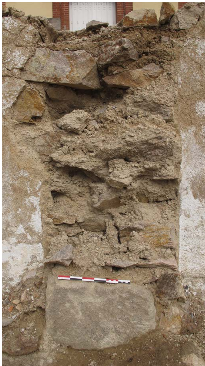
Fig. 103. Bloc parallélépipédique en grès dans les fondations d'un bâtiment industriel : remploi antique ?
