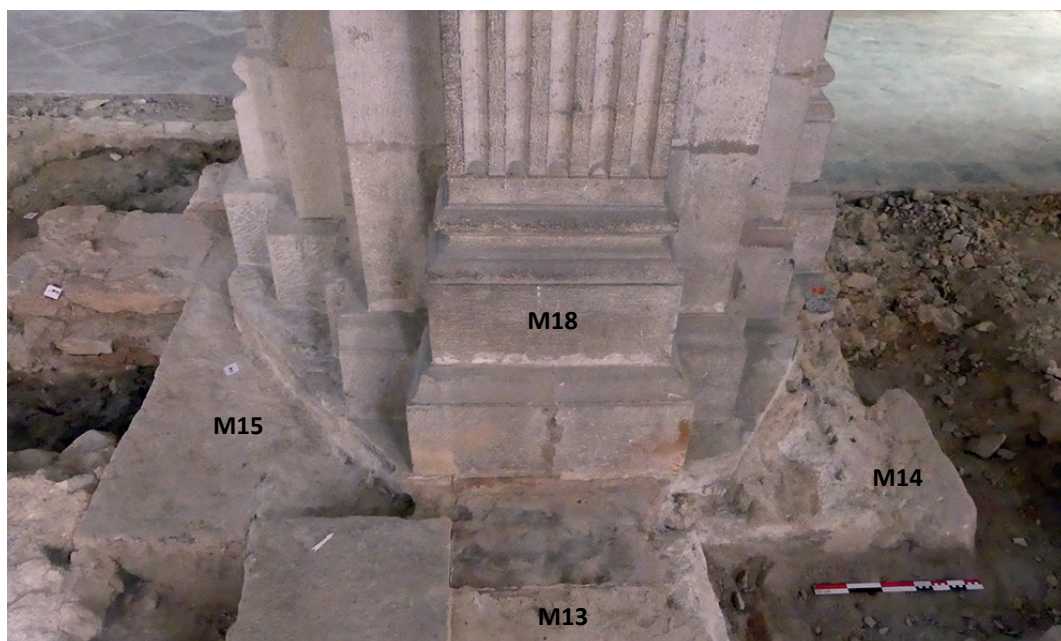
Fig. 64. Sondage 3 : état 3. Massif de fondation M14=M15 d'époque romane de la pile M18 en grand appareil. Cliché T. Dessolin en direction du nord-ouest.
