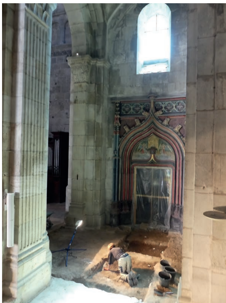
Fig. 20. Collatéral ouest : sondage n° 1 en cours de réalisation. Cliché Y. Labaune pris vers le sud.
