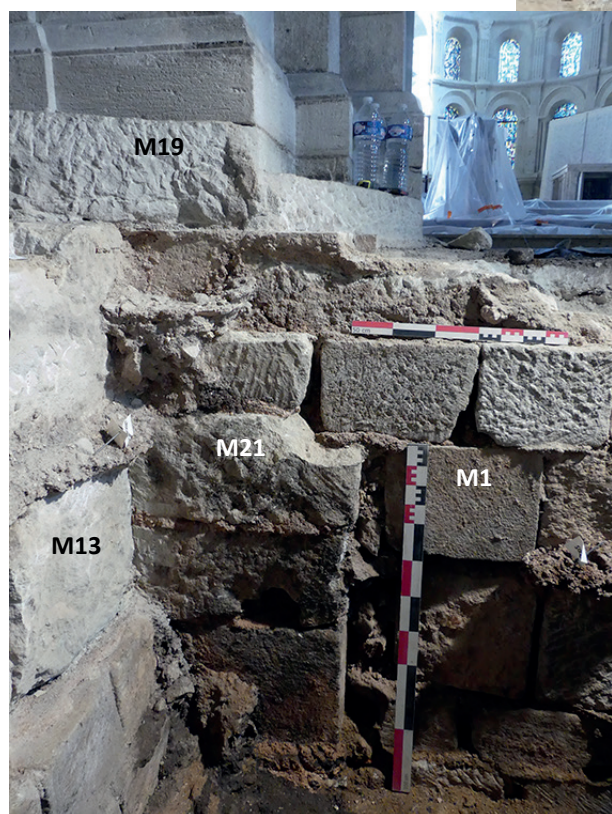
Fig. 66. Sondage 3 : état 3. Massif de fondation M21 d'époque romane de la pile M19 en grand appareil (au moins cinq assises sont superposées) enchâssé dans les massifs du XIX e s. Cliché T. Dessolin en direction du sud-est.
