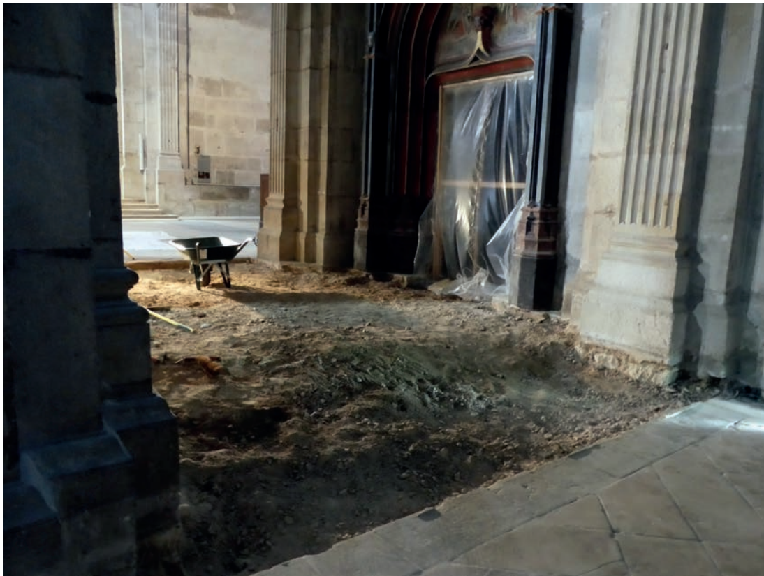
Fig. 17. Vue générale du collatéral ouest après dépose du dallage. Cliché Y. Labaune pris vers le sud.
