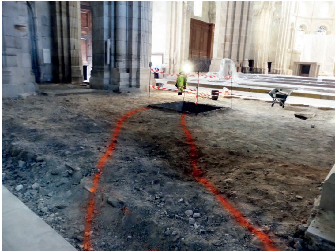
Fig. 18. Vue générale de la 7 ème travée de la nef après dépose du dallage. Cliché Y. Labaune pris vers l'est : au premier plan le tracé à la bombe orange du réseau de chauffage enterré se dirigeant vers une bouche de chaleur.
