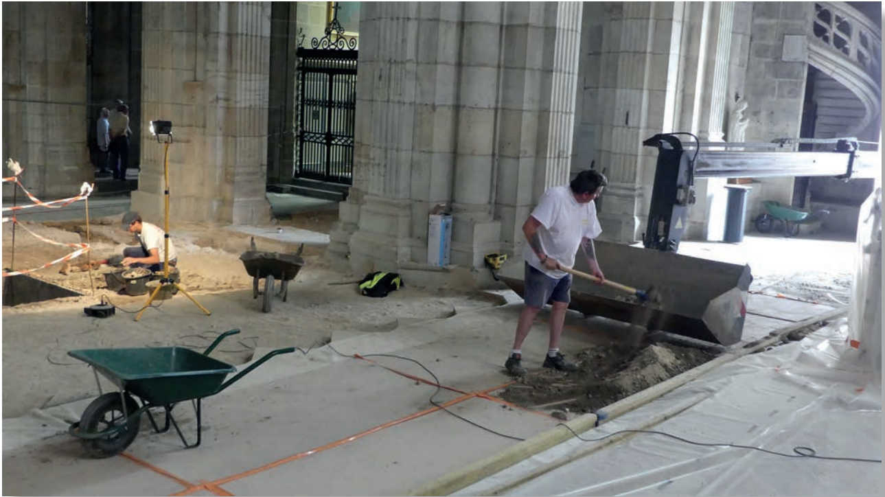
Fig. 23. Principe d'évacuation des déblais par l'entreprise Dufraigne. Cliché Y. Labaune.
