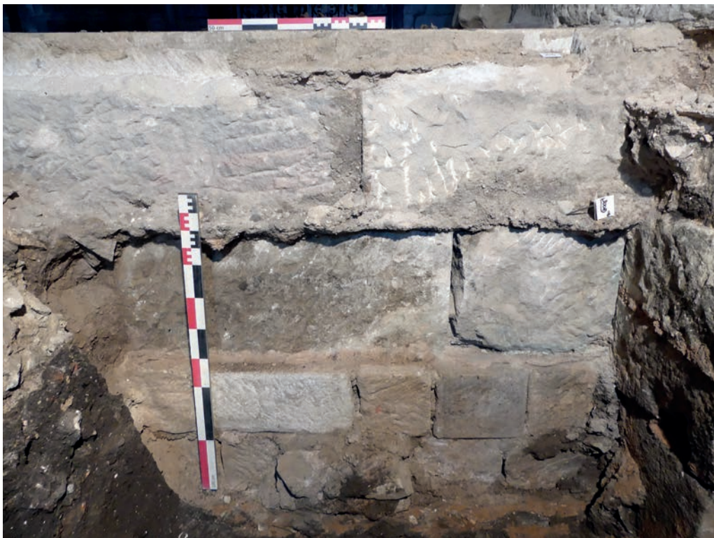
Fig. 108. Sondage 3 : état 6. Elévation de M13. Cliché T. Dessolin pris en direction du nord-est.
