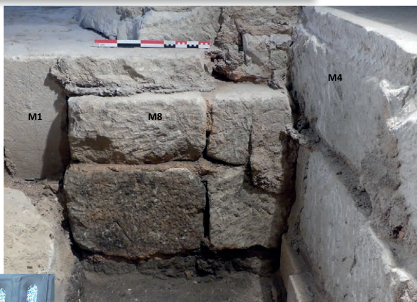
Fig. 65. Sondage 2 : état 3. Massif de fondation M8 d'époque romane de la pile M6 en grand appareil (au moins trois assises sont superposées) enchâssé dans les massifs du XIX e s. Cliché Y. Labaune en direction du sud-est.
