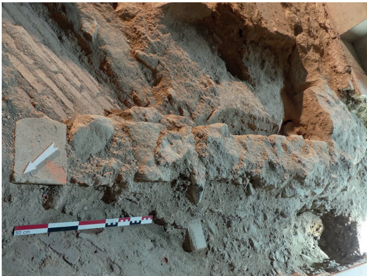
Fig. 113. Sondage 2 : état 7. Vue de détail des fondations M5 de l'embranchement entre les 6 ème et 7 ème travées. Cliché Y. Labaune pris en direction de l'ouest.
