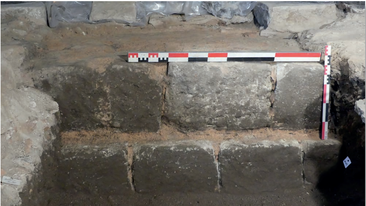
Fig. 59. Sondage 1 : état 3. Apparition des fondations romanes du mur gouttereau occidental de l'église Saint-Lazare réalisées en grand appareil (en partie des remplois antiques ?), un ressaut d'une quinzaine de centimètres de largeur sépare les deux assises.
