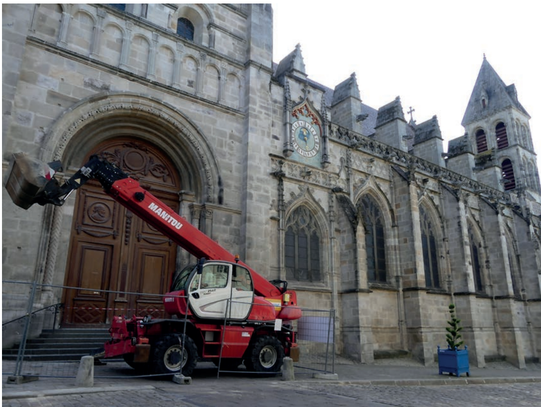
Fig. 22. Chariot télescopique permettant l'évacuation des déblais au fur et à mesure de l'avancée de l'opération (mise à disposition de l'entreprise Dufraigne).
