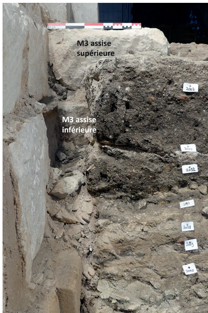
Fig. 63. Sondage 2 : état 3. Massif de fondation M3 d'époque romane de la pile M7 (équivalent M22) : on observe les deux assises de grand appareil superposées au niveau de la tranchée de fondation 2006 de l'état 6.
