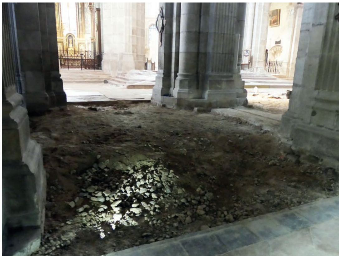
Fig. 19. Vue générale du collatéral est après dépose du dallage. Cliché Y. Labaune pris vers le sud.
