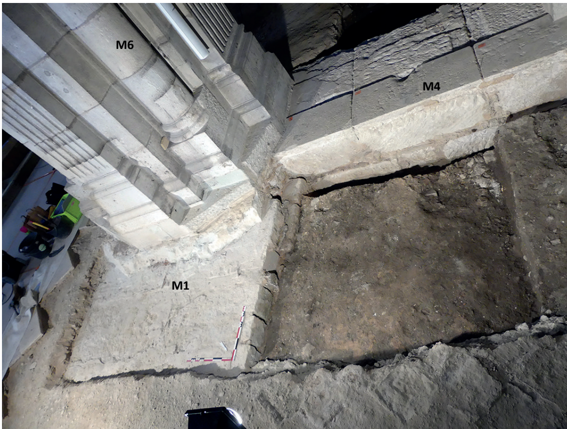
Fig. 104. Sondage 2 : état 6. Vue générale au second plan de M4 qui assure le chainage des fondations des piles M6 et M7, ici au contact de M1.
