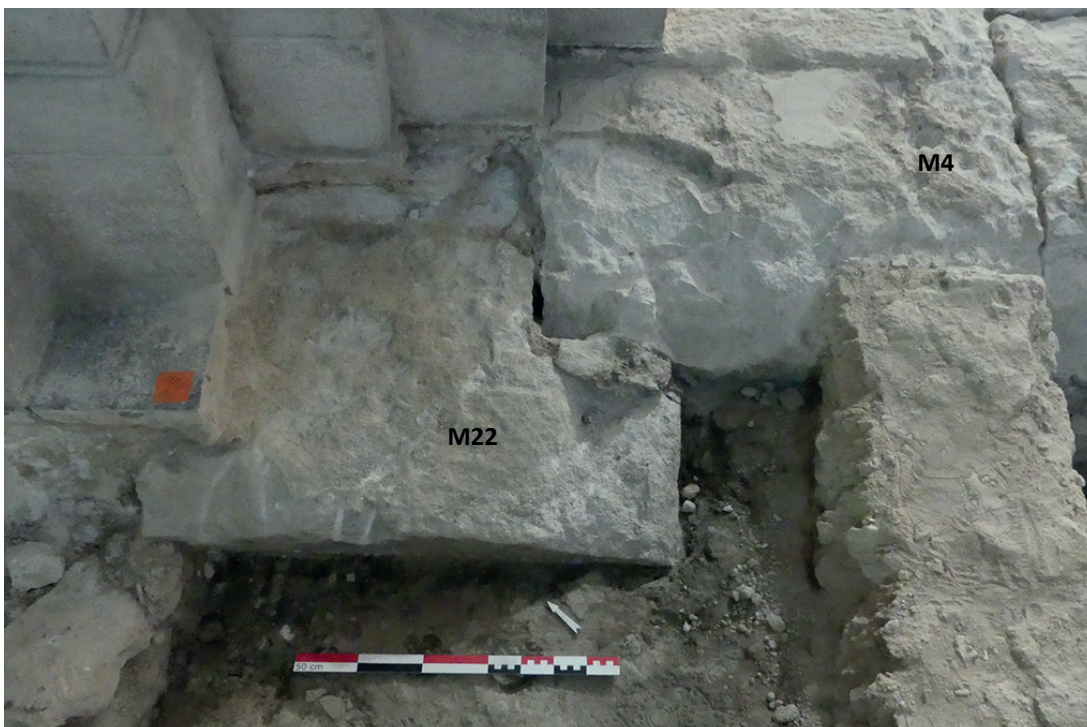
Fig. 62. Sondage 2 : état 3. Massif de fondation M22 d'époque romane de la pile M7 (équivalent M3). Cliché Y. Labaune en direction du nord-est.
