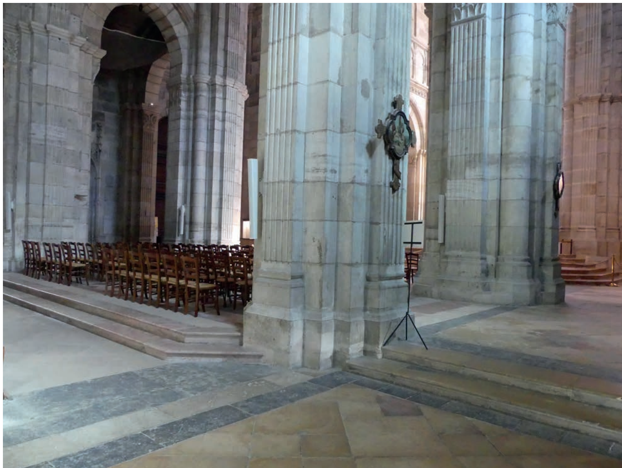
Fig. 112. Etat 7. Emmarchement entre les 6 ème et 7 ème travées : vue générale (avant l'intervention). Cliché Y. Labaune pris en direction de l'ouest.
