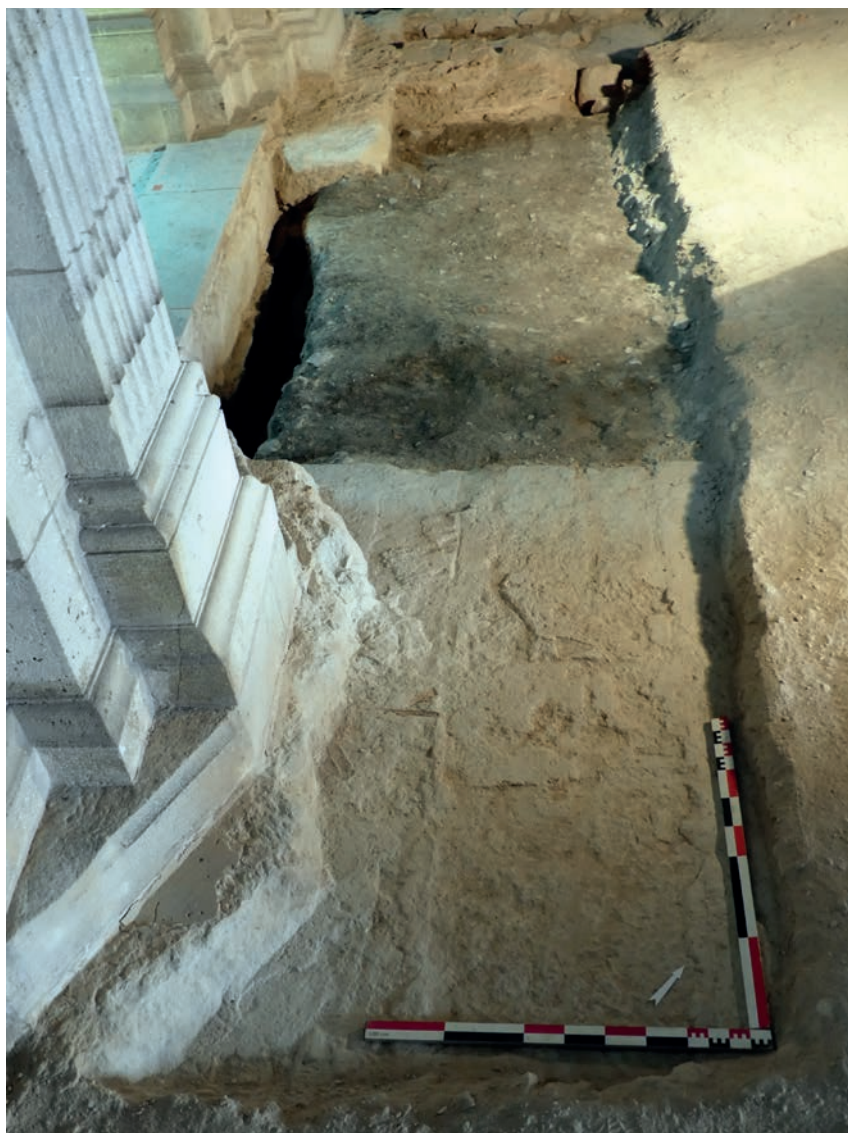
Fig. 100. Sondage 2 : état 6. Maçonnerie M1 permettant de chaîner M6 et M19, deux des quatre piles de la croisée du transept. A gauche du cliché la pile M6 intégralement reconstruite à l'occasion de sa construction.
