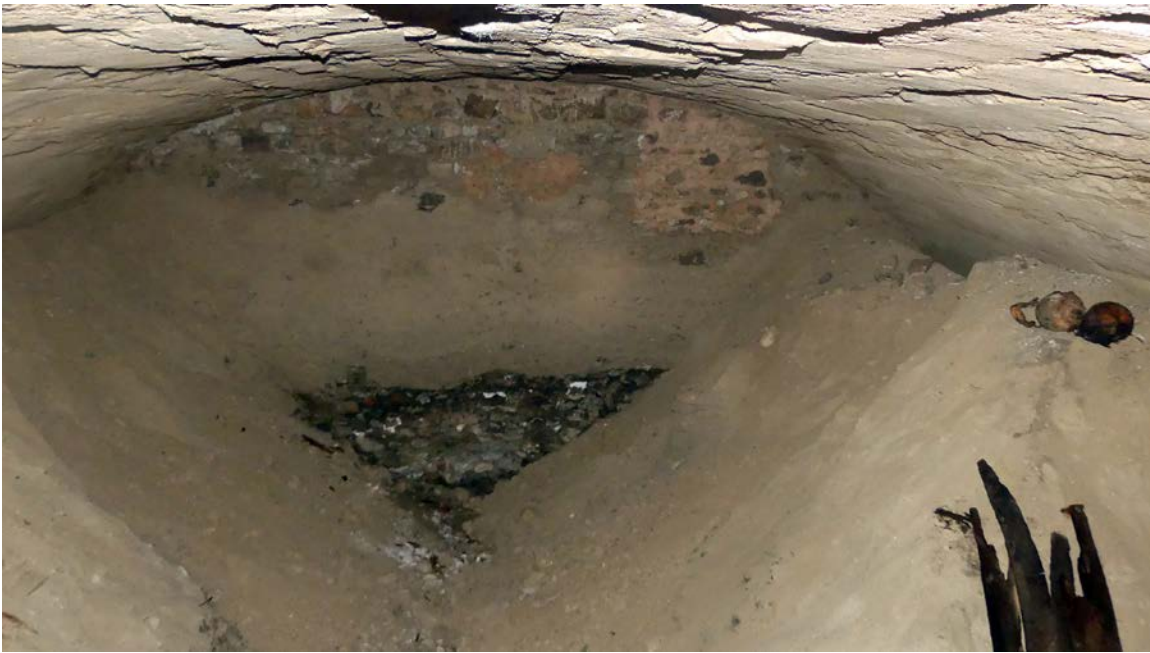
Fig. 37. Vue générale des profonds bouleversements reconnus à l'intérieur du caveau et des cordons de déblais repoussés contre les parois latérales du caveau.
