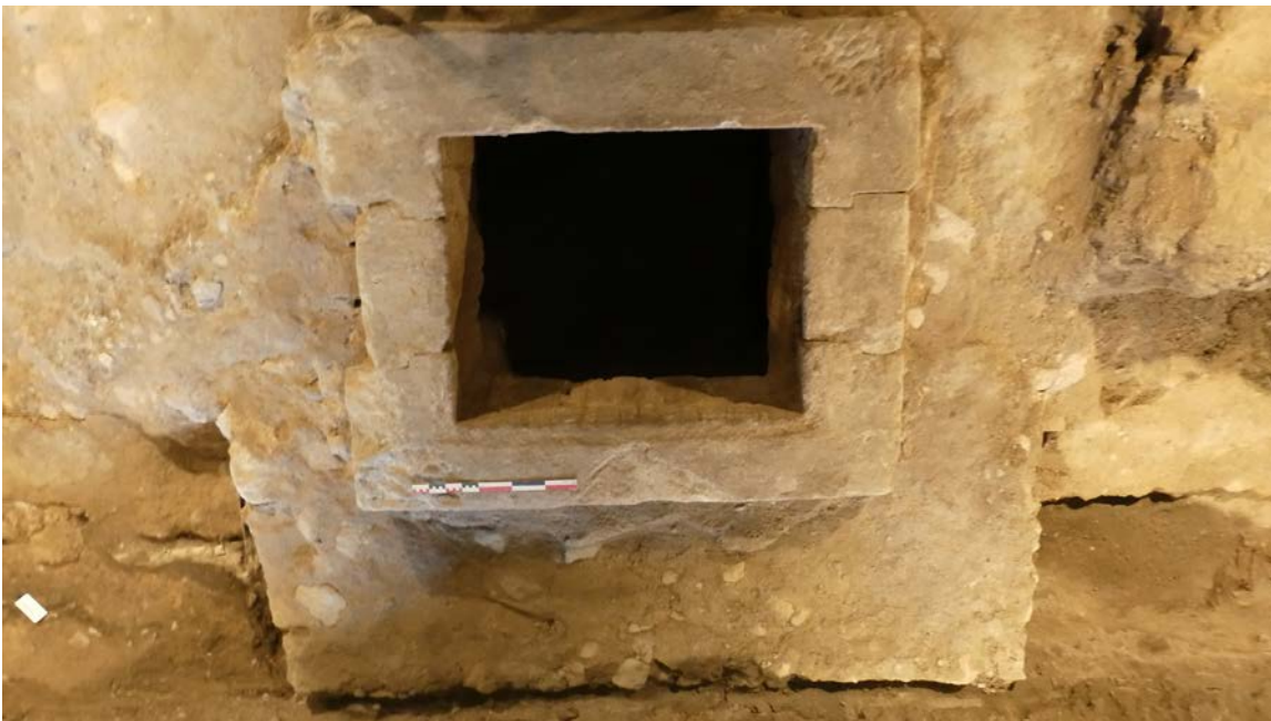
Fig. 34. Vue de détail du dispositif d'accès à l'intérieur du caveau. Cliché Y. Labaune en direction du sud-est.
