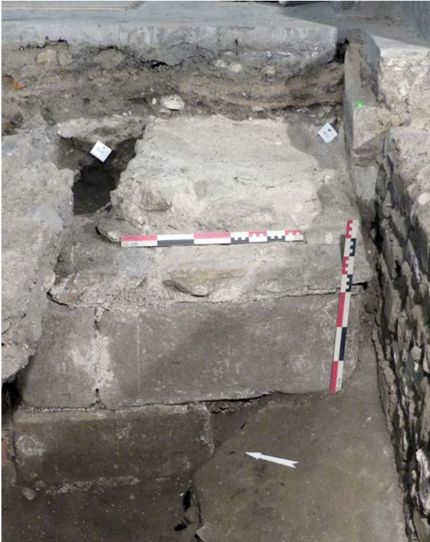
Fig. 28. Vue de détail de la paroi M38.1. Cliché Y. Labaune en direction du nord-est.
