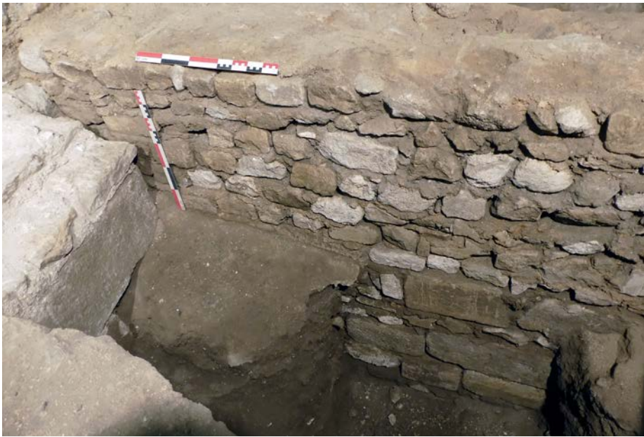
Fig. 19. Vue de détail des fondations parementées de M28.
