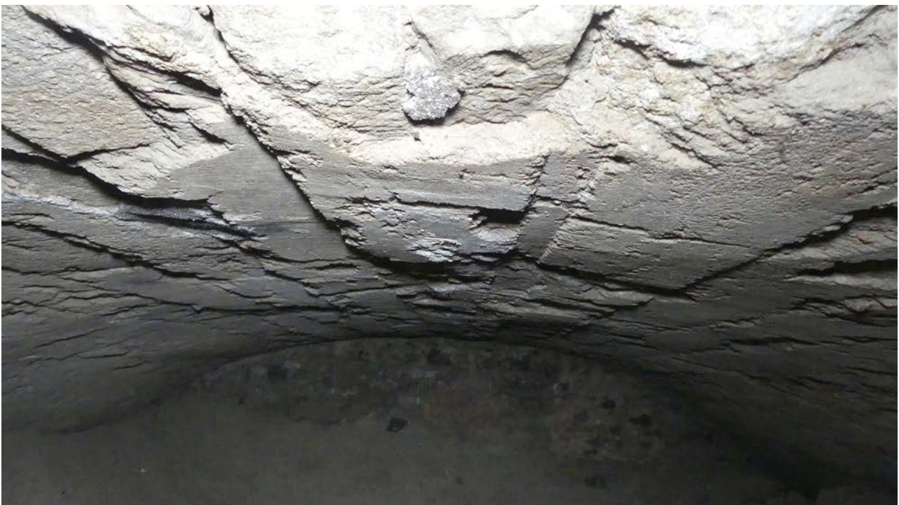
Fig. 32. Vue générale de l'aspect de l'intrados de la voûte du caveau présentant des traces des planches ayant servies à la construction.
