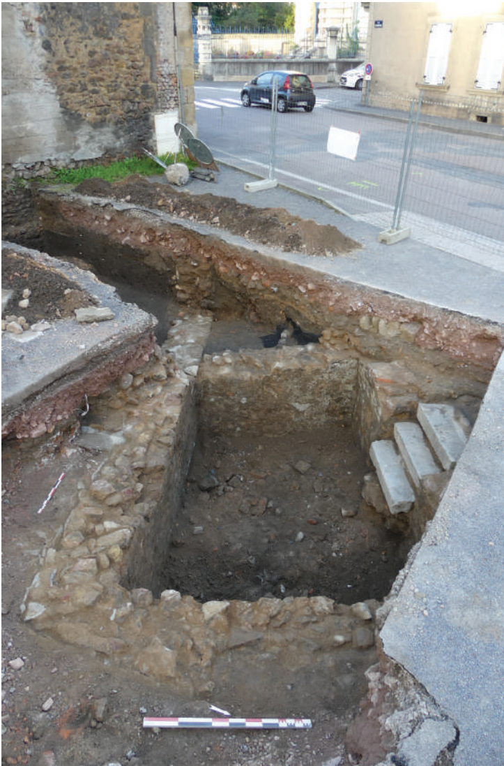
Fig. 113. Sondage 2 : infrastructures des XVIII e -XIX e s. se développant dans le tènement St. 4 dont une cave. A l'arrière-plan, la courtine qui se prolongeait au niveau de la rue Eumène où s'élevait une tour détruite lors du percement de l'axe viaire au XIX e s. Cliché Y. Labaune vers l'O.
