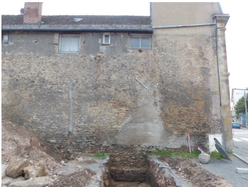
Fig. 20. Vue générale de la façade et de l'élévation de la courtine et de ses fondations dégagées au niveau du sondage 2.
