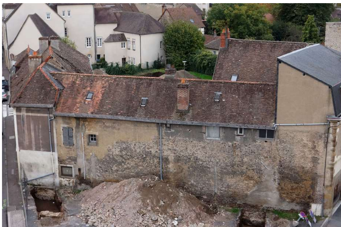
Fig.19. Vue générale de la façade nord du bâtiment.
