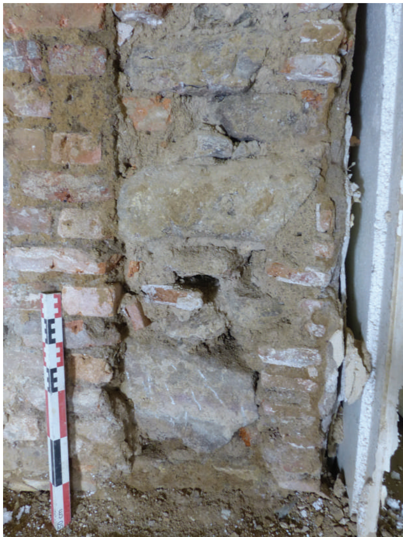
Fig. 9. Détail du parement de l'UC 2.4.
