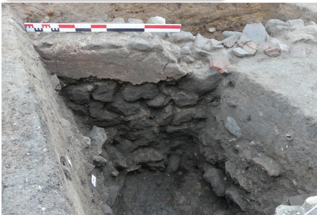
Fig. 48. Sondage 4 : parement du mur M27 couvert d'enduit hydraulique dans sa partie supérieure. Cliché T. Dessolin.
