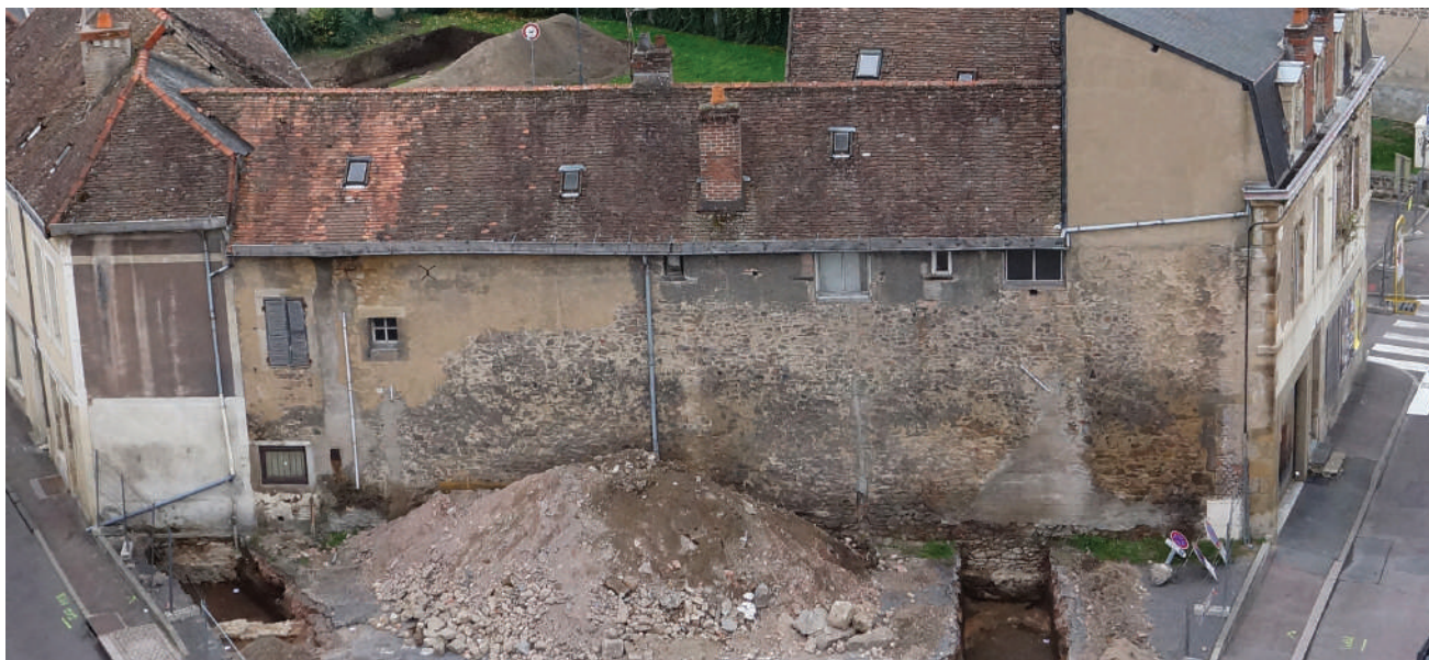
Fig. 109. Façade nord des bâtiments promis à la démolition recelant les vestiges de la courtine de l'enceinte de Marchaux conservés en élévation.
