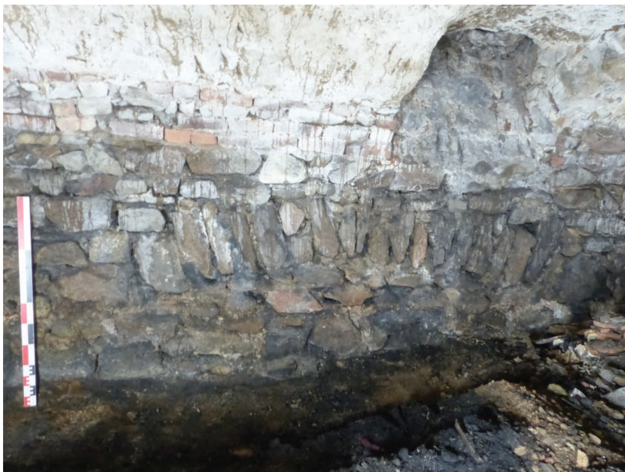
Fig. 30. L'arc de décharge dans le mur est de la cave. Cliché Katia Lagorsse, Inrap.
