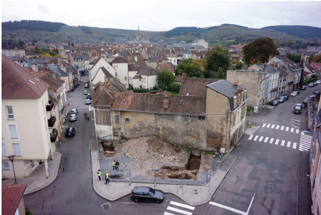
Fig. 18. Vue générale de l'intervention depuis le nord. Au premier plan les sondages sédimentaires 1 et 2 menés au droit du bâti à démolir. A gauche la petite rue Marchaux d'origine médiévale qui se dirige vers la ville haute dont la cathédrale est visible à l'arrière-plan. Cliché Com'air.
