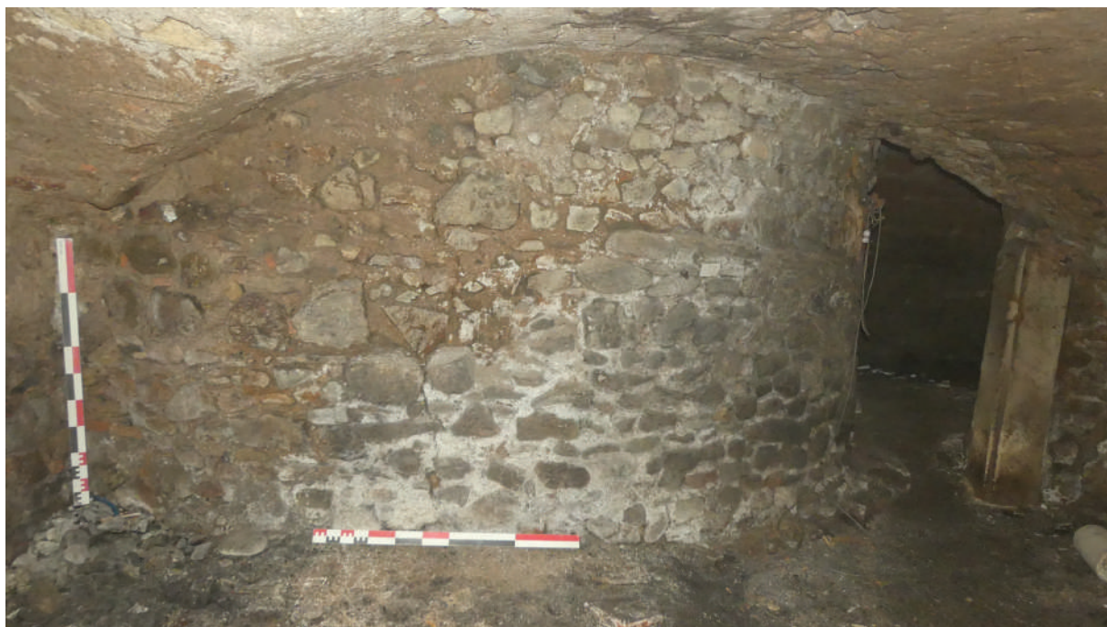
Fig. 31. Parement externe de la tour de flanquement orientale de la porte méridionale de Marchaux, conservée dans une cave hors emprise du diagnostic.
