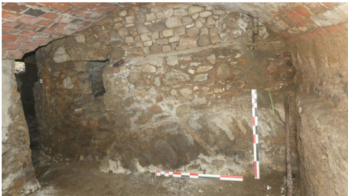
Fig. 32. Parement externe de la tour de flanquement orientale de la porte méridionale de Marchaux, conservée dans une cave hors emprise du diagnostic.
