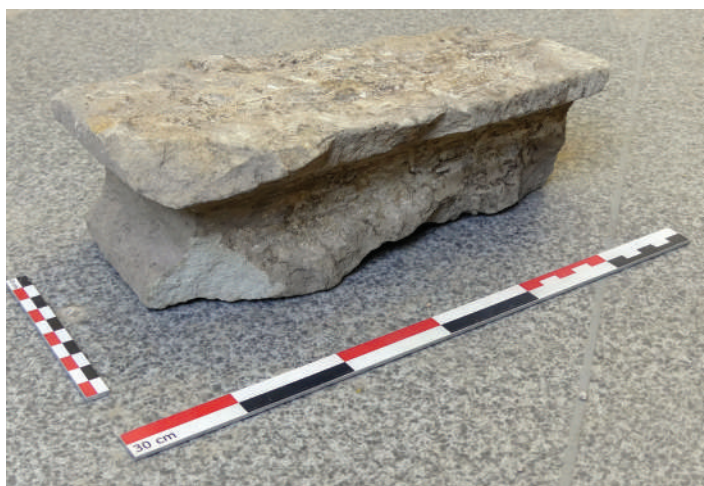
Fig. 18. Moellon de chaînage d'angle en grès fin du Rhétien, avec moulure en creux (L/4000).
