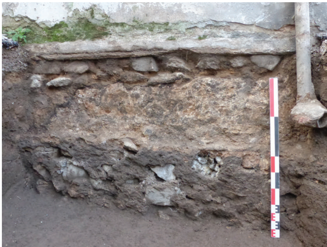
Fig. 22. Vue de détail des fondations du mur de façade nord dégagé au niveau du sondage 2, à l'emplacement de la tour démantelée au XVIII e s. et conservée uniquement au niveau R-1. Cliché Katia Lagorsse, Inrap.
