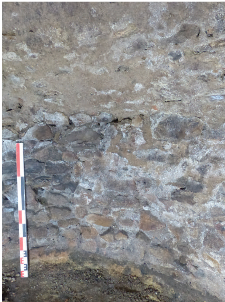
Fig. 23. Le parement interne de la tour et le départ de la voûte. Cliché Katia Lagorsse, Inrap.
