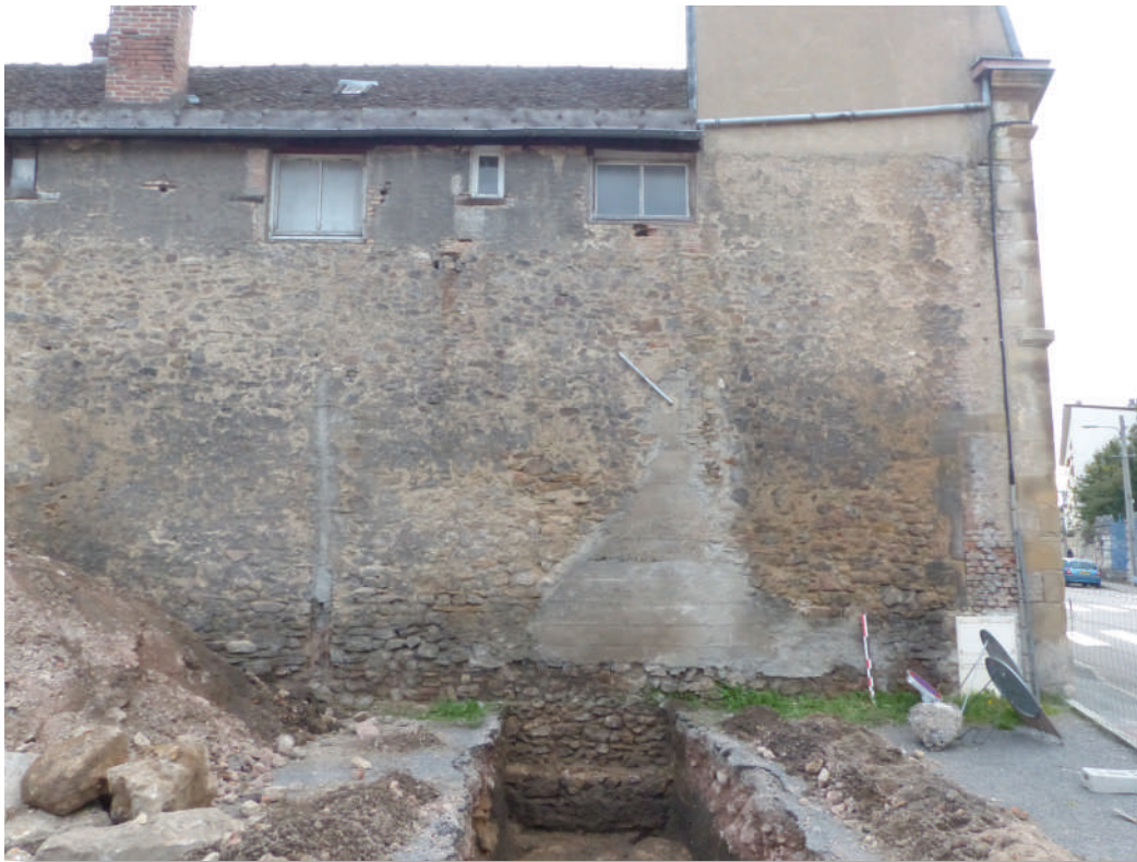
Fig. 96. Façade nord des bâtiments promis à la démolition montrant la conservation en élévation de la courtine de l'enceinte de Marchaux. Le sondage sédimentaire 2 au droit de cette façade a été réalisé afin de révéler l'aspect des fondations de la courtine.
