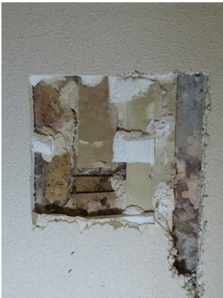
Fig. 3. Piquetage en cours du sondage 1. Cliché Katia Lagorsse, Inrap.
