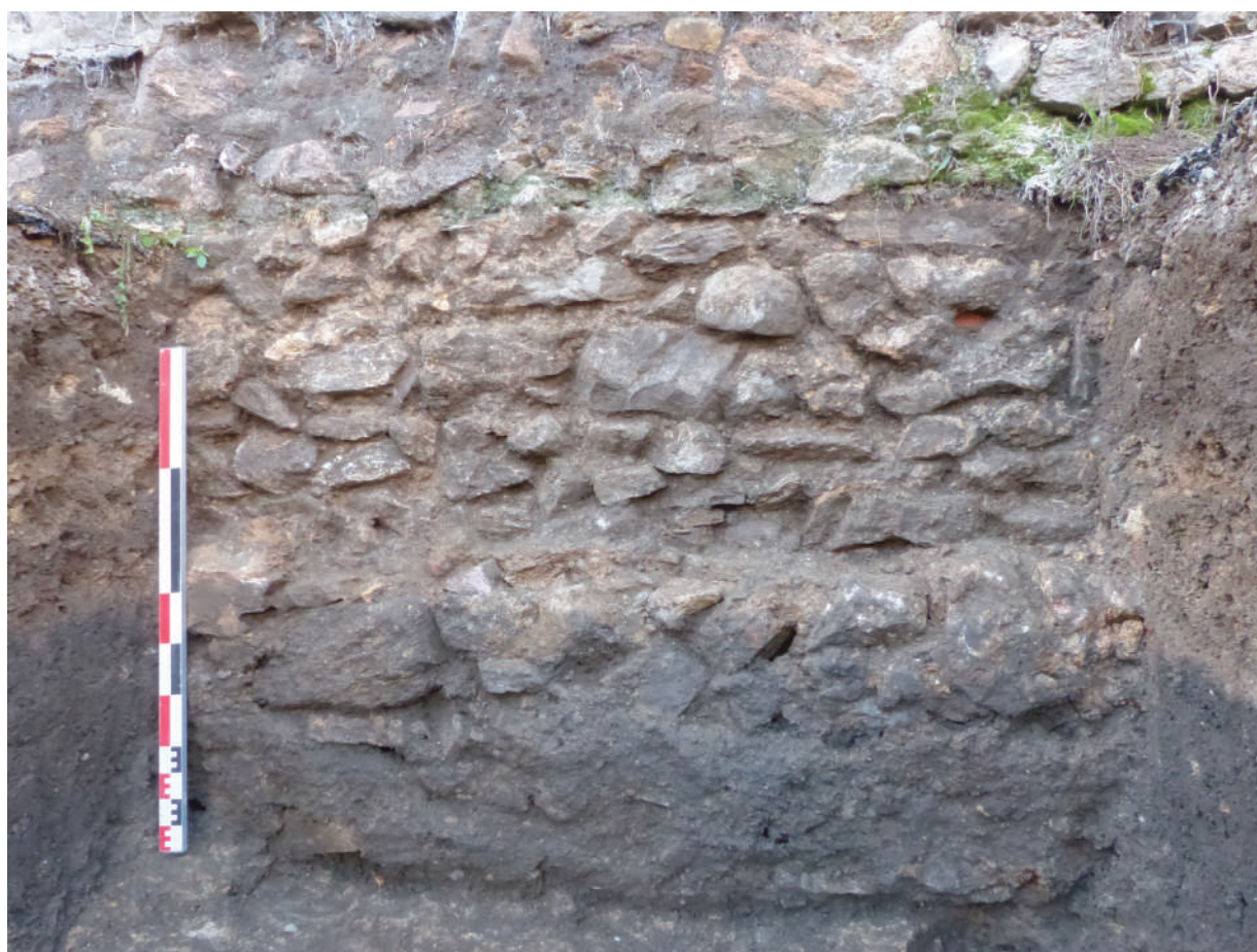
Fig. 21. Vue de détail des fondations de la courtine dégagées au niveau du sondage 2 qui reposent directement sur des maçonneries d'époque romaine (en bas du cliché).
