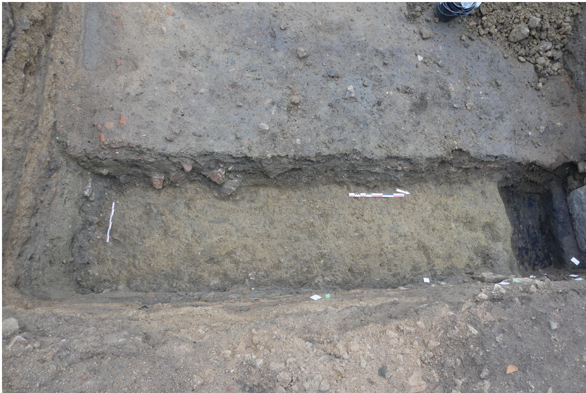
Fig. 31. Vue du niveau de sédiment naturel remanié en vue de l'installation du premier niveau de voirie.
