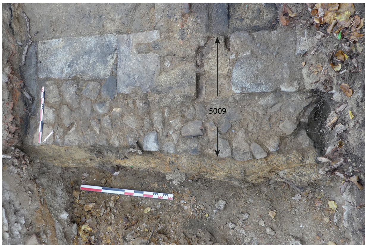
Fig. 33. Secteur 2, sondage 5 : vue zénithale du massif de fondation 5009, en bas du cliché la tranchée d'épierrement 5019 est bien visible. Cliché Y. Labaune.
