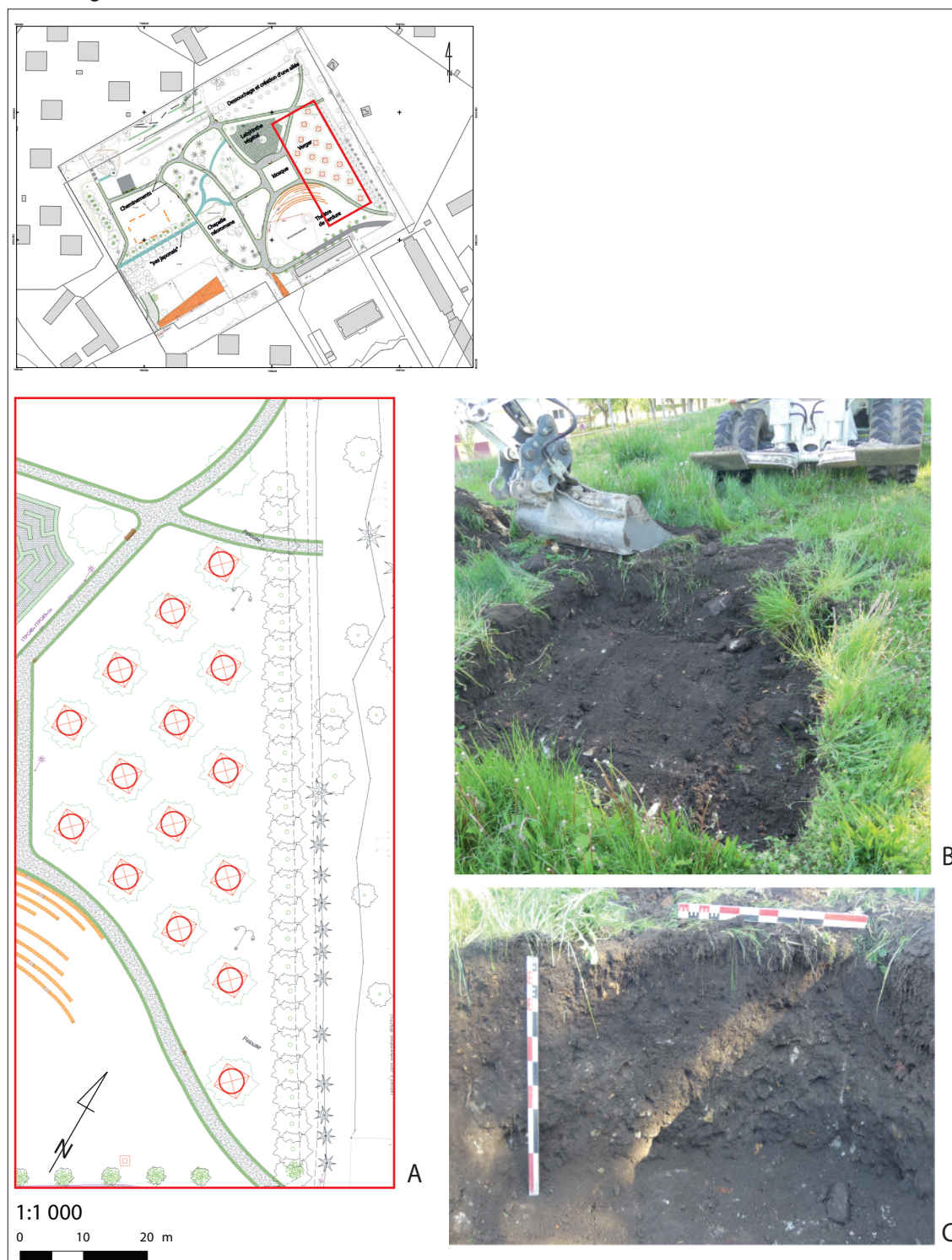
Fig. 23. Surveillance des terrassements à l'emplacement du verger conservatoire. A : emprise du verger et localisation des fosses horticoles ; B-C : exemple de creusement d'une des fosses touchant uniquement les horizons de terre végétale. DAO Y. Labaune, d'après T. Dessolin.
