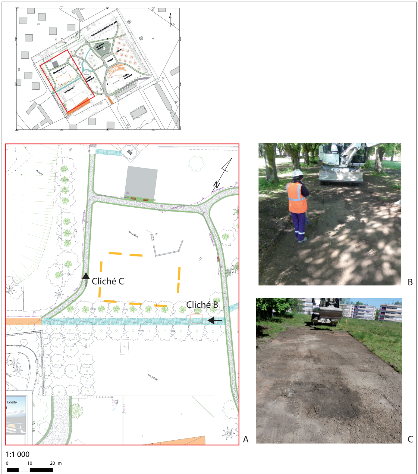
Fig. 27. Surveillance des terrassements lors de la création des cheminements piétons dans le secteur de l'abbatiale et du cloître. A : localisation des cheminements ; B-C : clichés des terrassements. DAO Y. Labaune, d'après T. Dessolin.
