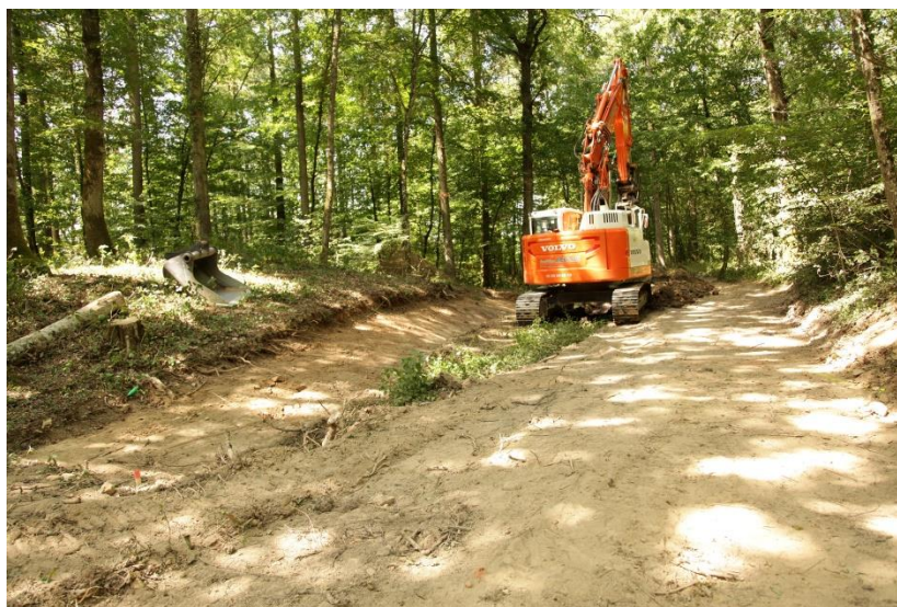
Fig. 10. Zone d'emprise au niveau de la levée après décapage. Vue partielle à droite du chemin de la levée la plus orientale. Cliché B. Ligouis.
