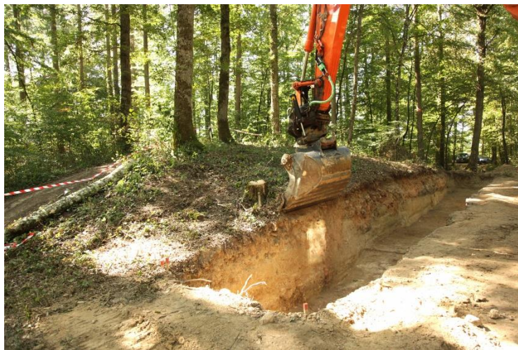
Fig. 11. Vue sur la section transversale de la levée et la tranchée. Cliché B. Ligouis.
