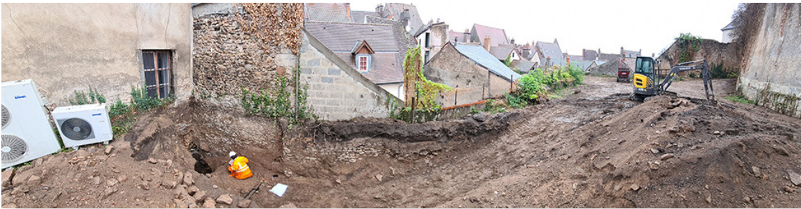
Fig. 68. Vue générale du sondage géotechnique, cliché pris en direction de la courtière. Cliché Yannick Labaune.
