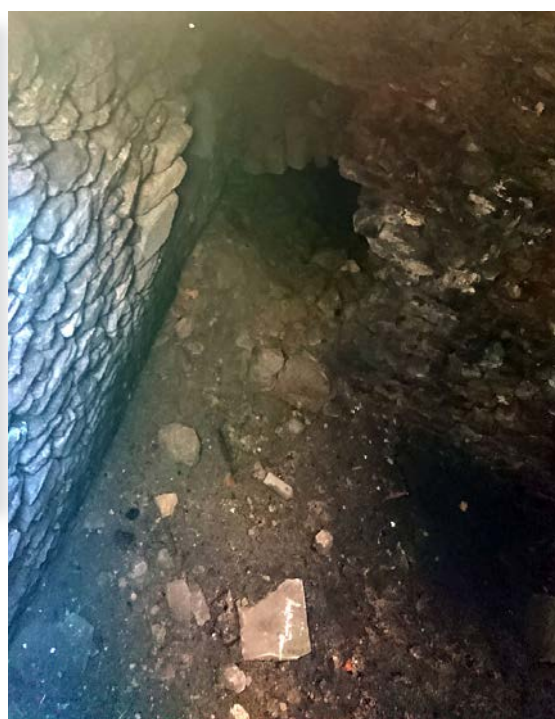
Fig. 143. Intérieur de St. 7.1 : cliché pris en direction du nord et de l'ancien palais de Justice, l'éboulement laisse entrevoir la poursuite de l'espace souterrain en direction de l'ancien palais de Justice. Cliché C. Couderc.
