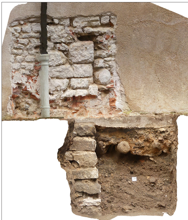
Fig. 321. Angle nord-ouest du « Donjon » imbriqué dans le bâti du XV e s.
