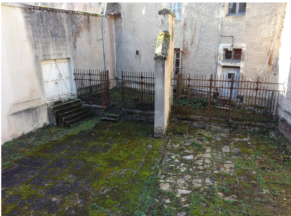
Fig. 53. Vue générale du dallage de la cour des prisonniers, de la maçonnerie et de la grille en fer forgé séparant la cour du pavillon du gardien, avant dépose. Cliché Y. Labaune.
