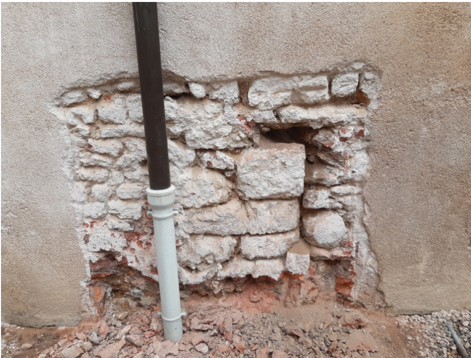
Fig. 74. Fenêtre en cours de décroutage dans la cour de l'hôtel Lacomme. Cliché C. Couderc
