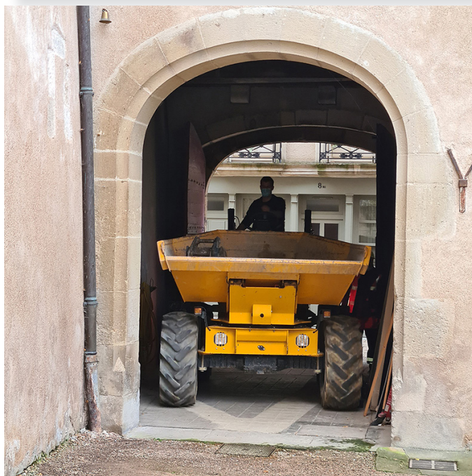
Fig. 60. Moyens mécaniques mis en œuvre dans un espace très contraint.
