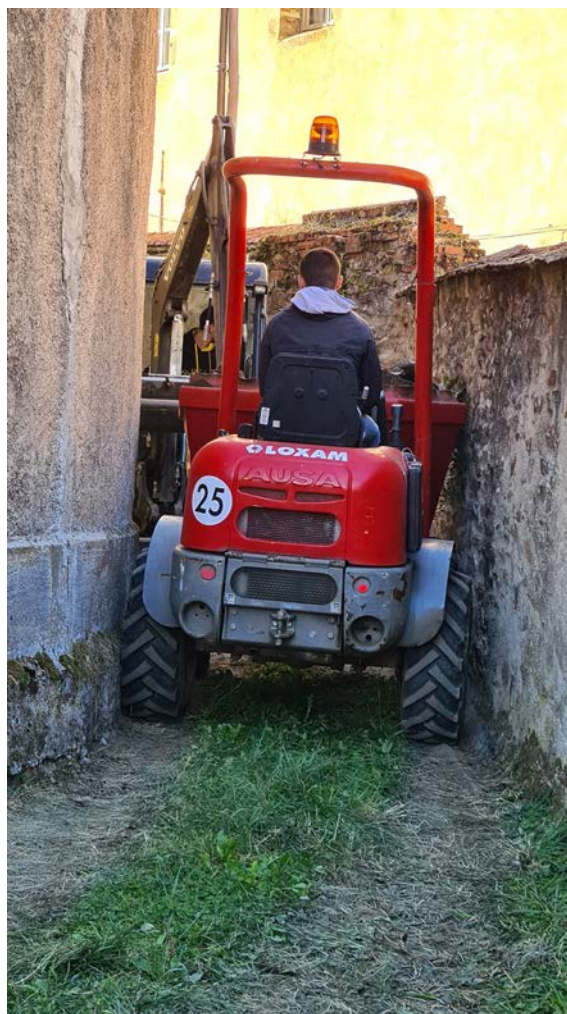
Fig. 46. Moyens mis en œuvre dans un espace particulièrement contraint, ici l'étroit passage entre le mur de clôture de l'hôtel Rolin et le mur périmétral de la prison panoptique. Cliché Yannick Labaune
