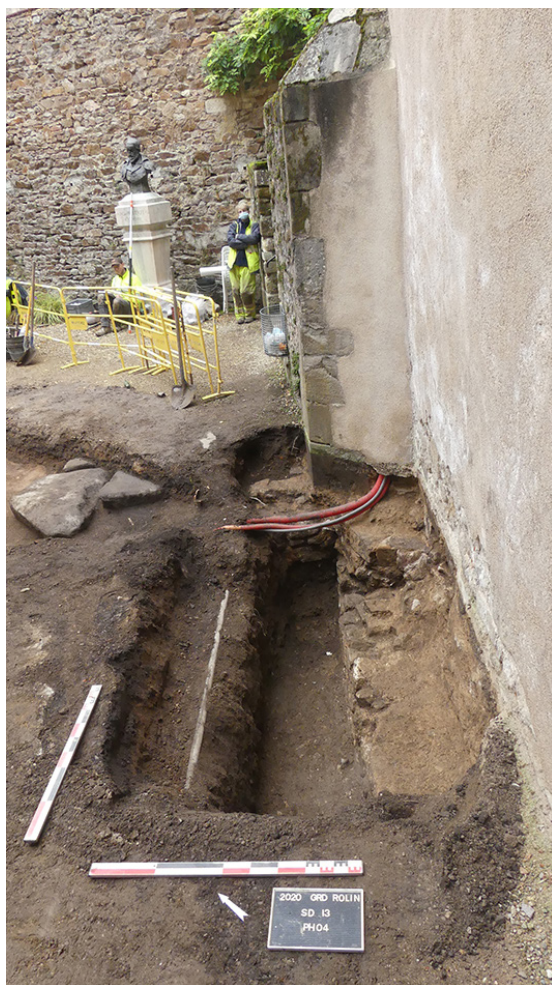
Fig. 185. Vue générale de UM74.
