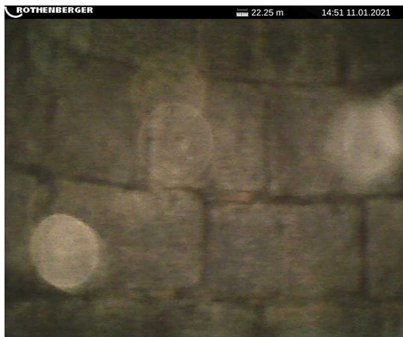
Fig. 279. Cliché du parement du puits découvert dans la cour Lacomme réalisé avec une caméra endoscopique. Cliché équipe de fouilles.
