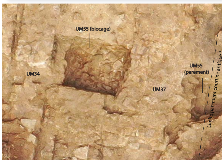
Fig. 135. Imbrication de UM55, possible mur de courtine de l'enceinte réduite, dans les maçonneries et infrastructures plus récentes.
