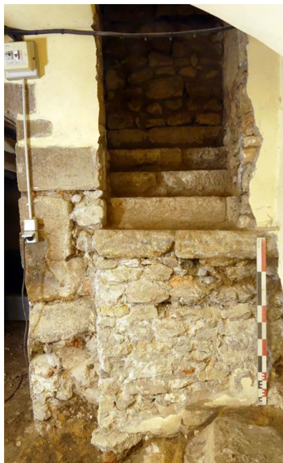
Fig. 322. Escalier d'accès à l'intérieur du « Donjon » découvert après décroûtage.
