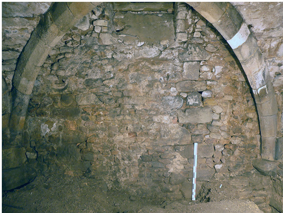
Fig. 179. Vue générale du mur 61 : deux césures verticales témoignent d'une reprise totale de la partie centrale.
