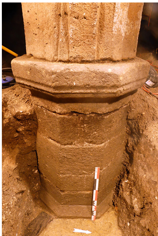
Fig. 338. Pile centrale et sa base masquée par les remblais récents.
