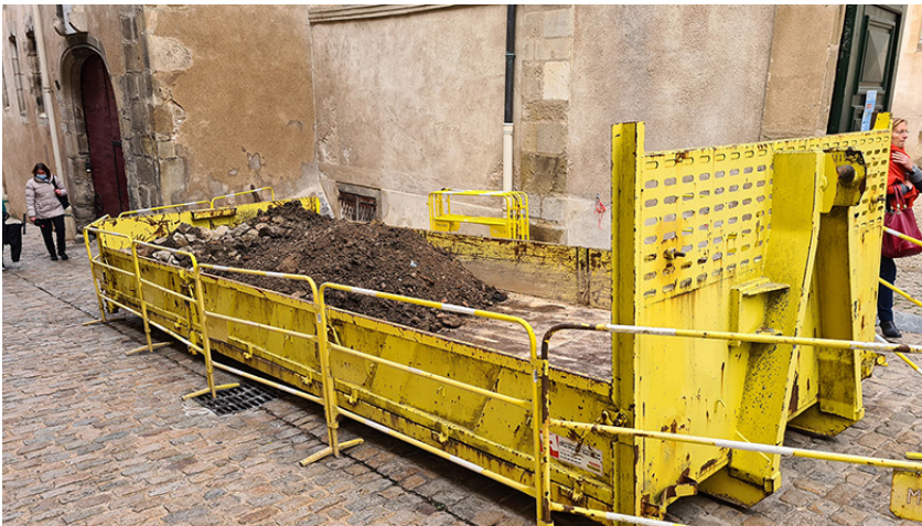
Fig. 58. Benne déposée devant l'entrée de la cave permettant stockage et évacuation des déblais.
