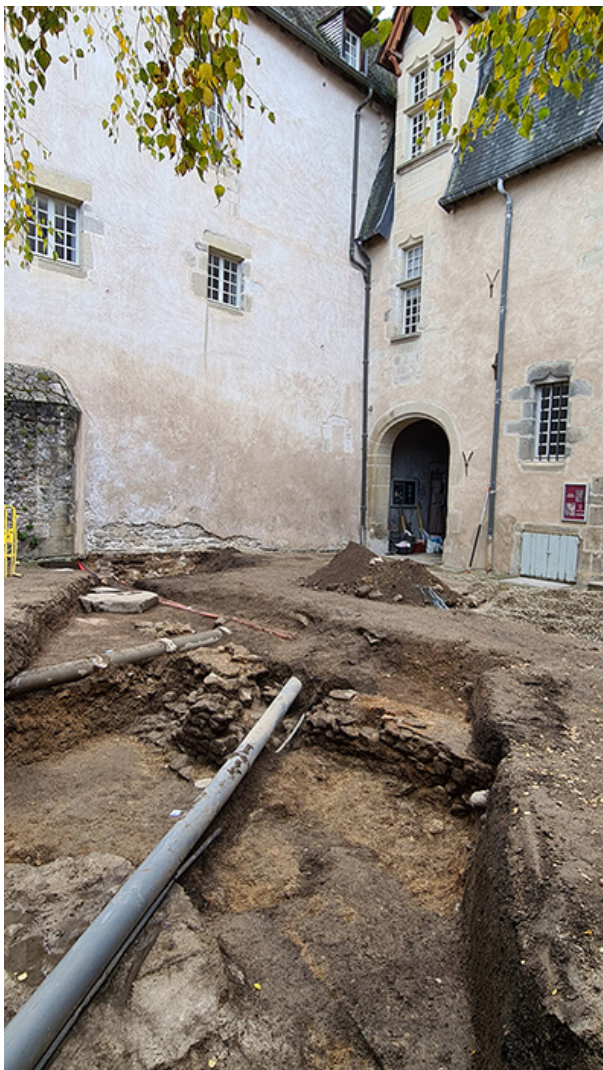
Fig. 333. Les vestiges de la maison Prémery, affleurant dans la cour de l'hôtel Rolin.
