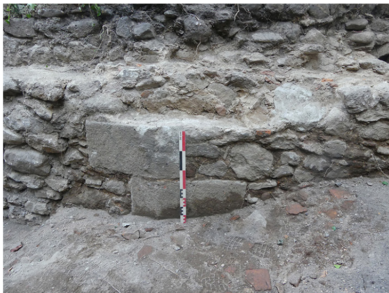
Fig. 125. Chainage d'angle repéré au niveau d'un point d'inflexion de la courtine. A droite du cliché se développe UC28.2 l'état le plus ancien de la courtine à l'endroit du sondage. A gauche du cliché, un coup de sabre sépare l'élévation de l'état le plus récent UC28.1. Cliché C. Couderc.
