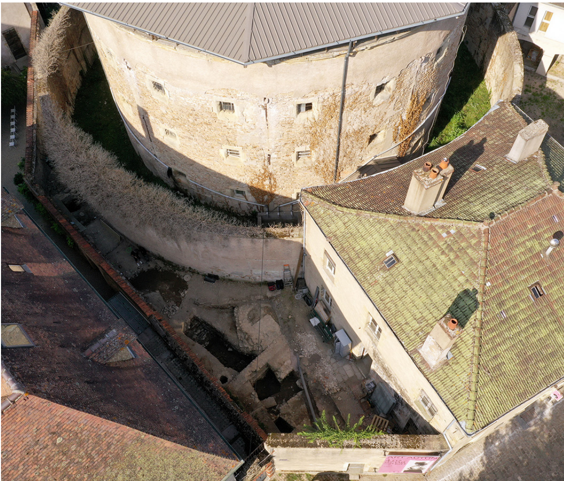
Fig. 48. Vue aérienne du sondage 1 réalisé dans un espace très contraint. Cliché Com'air.
