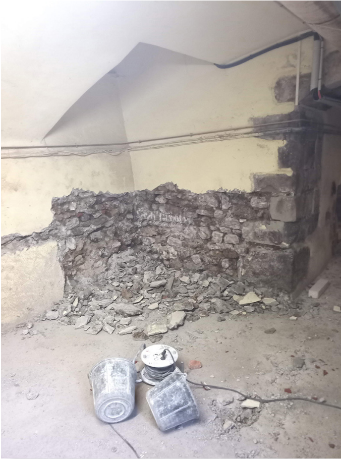
Fig. 72. Angle de mur en cours de décroutage dans les caves de l'hôtel Lacomme. Cliché C. Couderc
