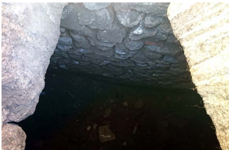
Fig. 142. Intérieur de St. 7.1 : cliché pris en direction du nord-ouest et de UM43. Cliché C. Couderc.
