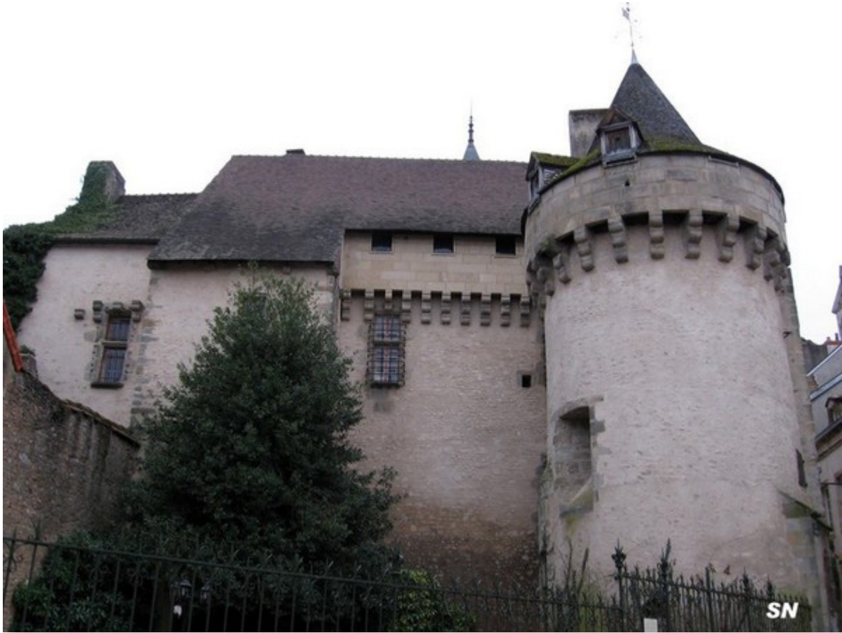
Fig. 11. Façade septentrionale de l'Hôtel Rolin qui prend appui sur l'enceinte réduite dans son état médiéval, au niveau du corps de garde et des vestiges de la Porte dite des Bancs (XII e , milieu XIV e s.). Cliché Y. Sylvain.
