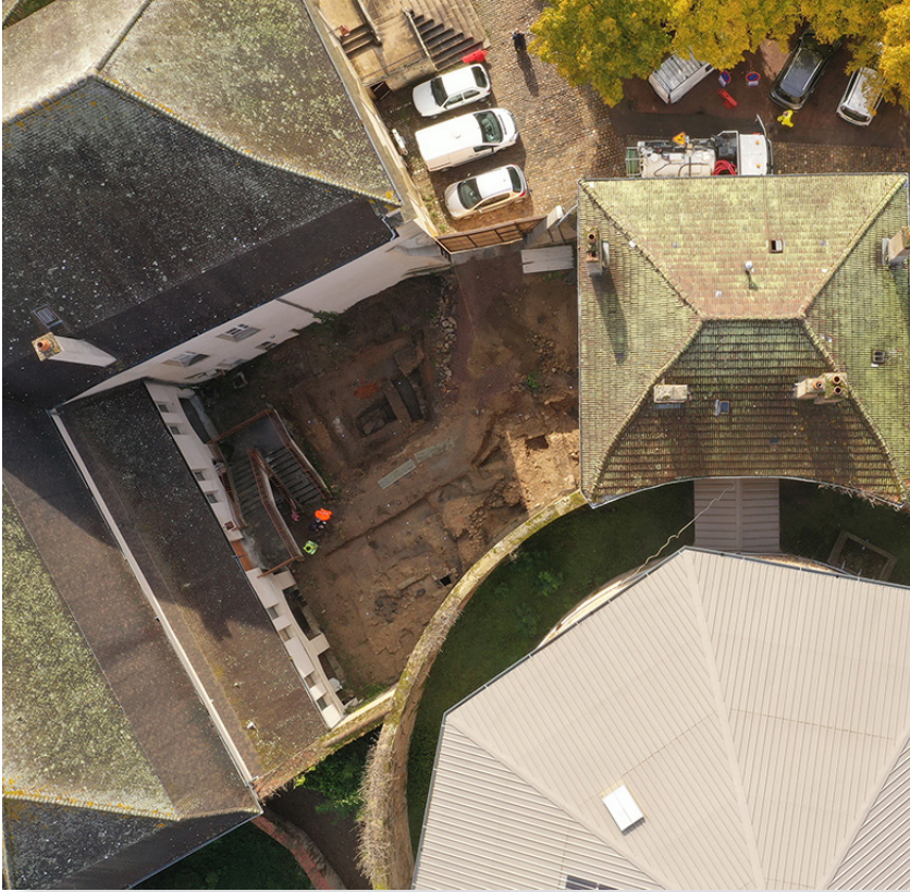
Fig. 54. Vue aérienne de l'intervention menée lors de la tranche 2. Cliché Com'air
