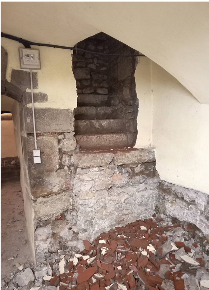
Fig. 73. Découverte d'un escalier lors du décroutage des murs de la cave de l'hôtel Lacomme. Cliché C. Couderc
