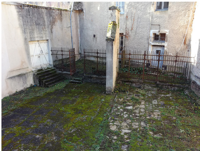
Fig. 161. Vue de la cour des prisonniers avant démontage du pavement originel, montrant UM34 en élévation avec sa grille en fer.
