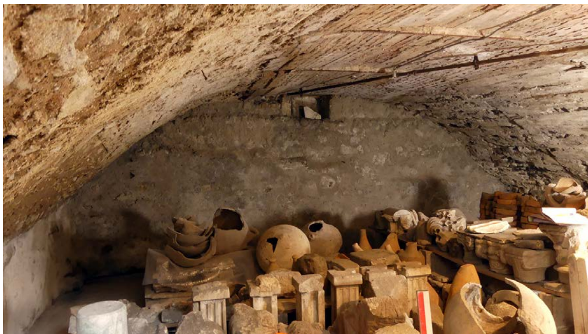
Fig. 292. Reprise de l'ensemble du faîte de la voûte de la cave ouest de l'hôtel Rolin en briques et installation de tirants métalliques.
