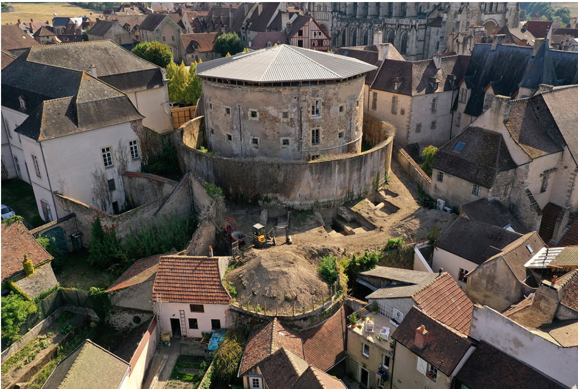
Fig. 47. Difficile gestion des déblais dans un secteur exigu où l'évacuation est impossible. Cliché Com'air.
