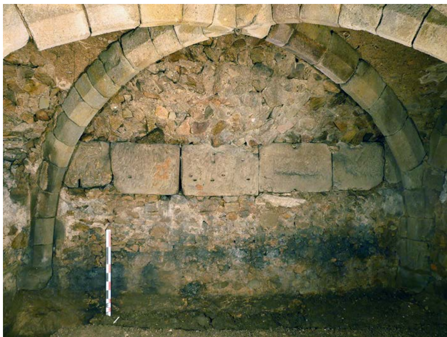
Fig. 316. Courtine de l'enceinte réduite mobilisant des blocs de grand appareil conservée dans la cave Lacomme donnant sur la rue des Bancs.
