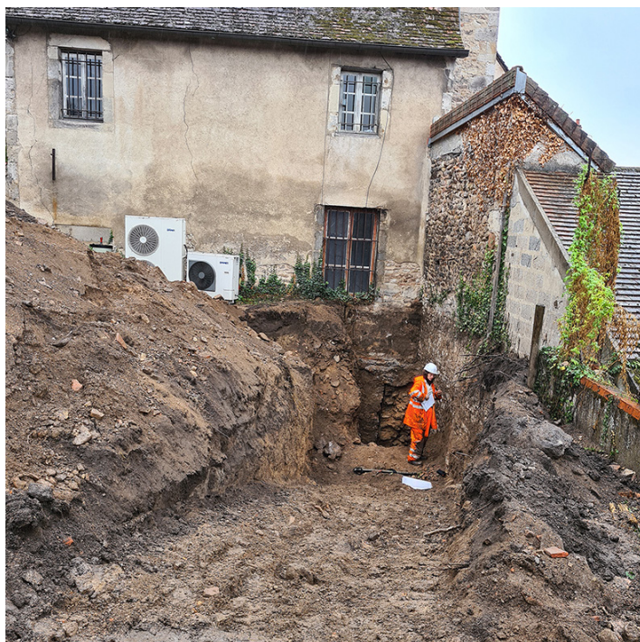
Fig. 110. Vue générale du sondage géotechnique au droit de la courtine et de l'hôtel Rolin. Au premier plan, la rampe d'accès de la pelle mécanique au sondage profond. Cliché Y. Labaune.
