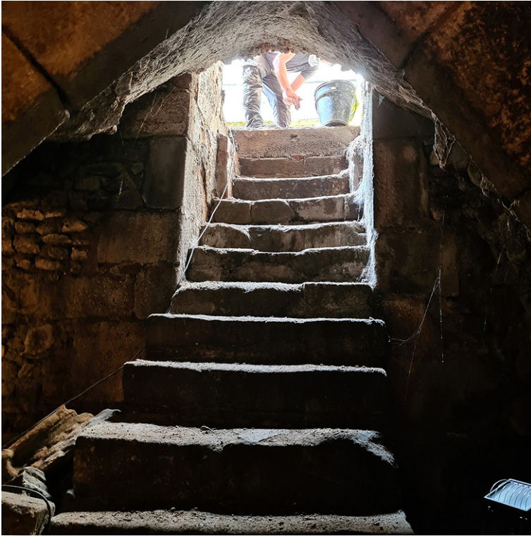
Fig. 57. Escalier utilisé pour évacuer les déblais.
