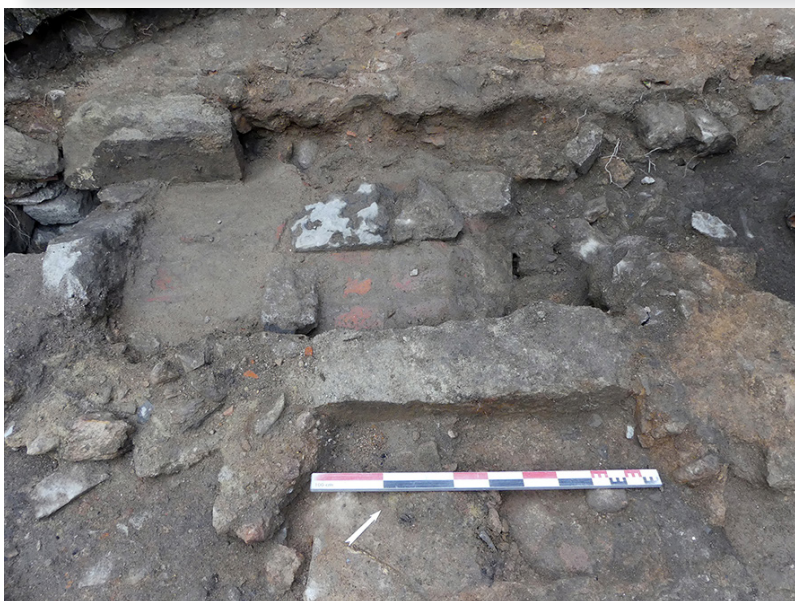
Fig. 163. Vue de détail des aménagements réalisés au niveau de l'extrados de la voûte du dispositif souterrain. Cliché équipe de fouilles.
