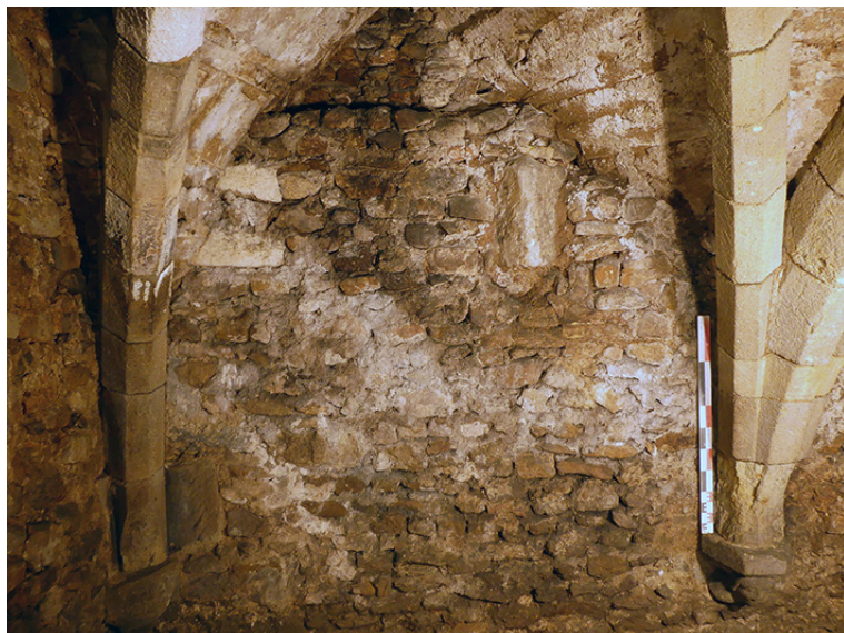
Fig. 173. Maçonnerie en grand appareil (UC 57.2) englobée par le mur nord-est de la cave (UC 57.1). Cliché C. Couderc
