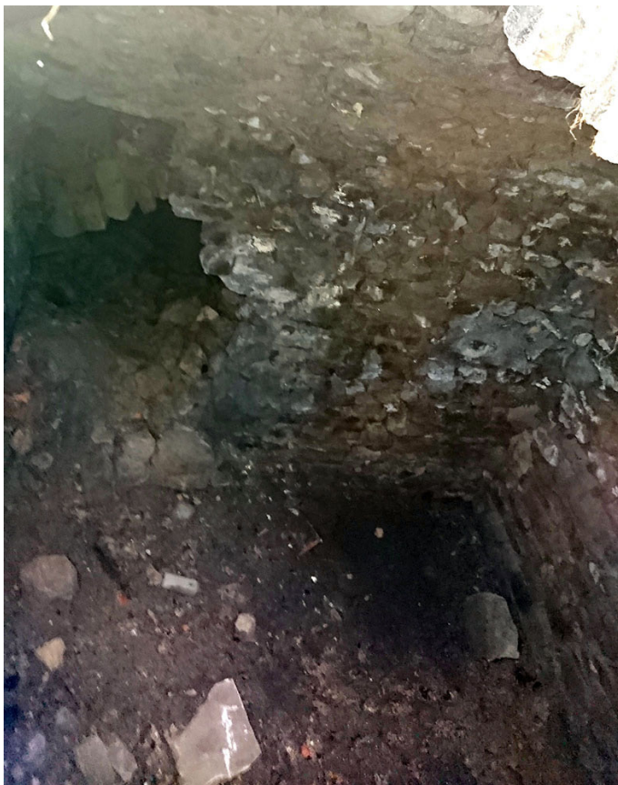
Fig. 144. Intérieur de St. 7.1 : cliché pris en direction de l'angle nord-est de la structure, l'éboulement laisse entrevoir la poursuite de l'espace souterrain en direction de l'ancien palais de Justice. Cliché C. Couderc.
