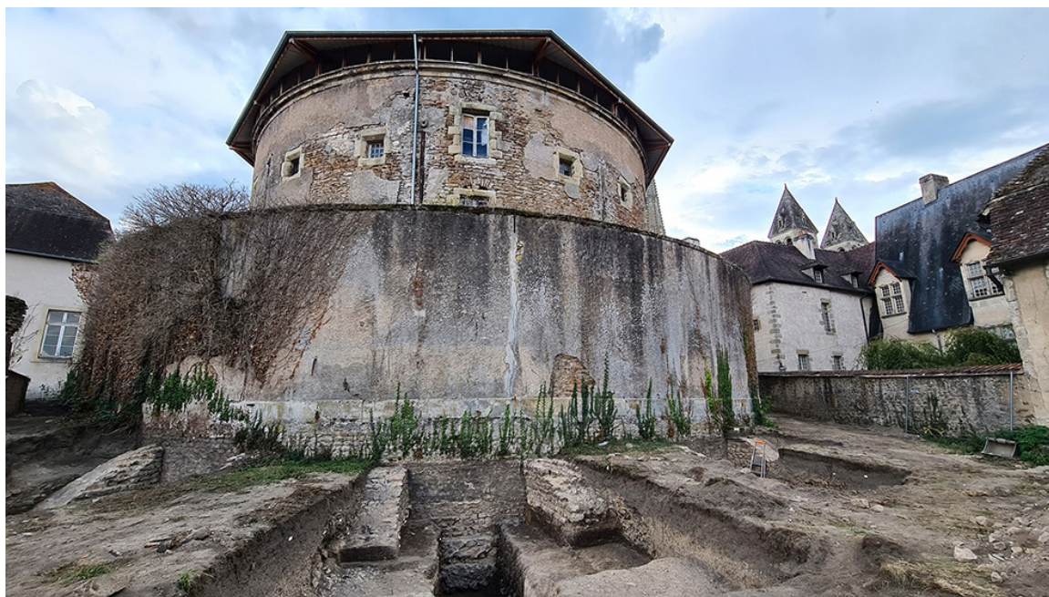
Fig. 119. Vue générale des 3 sondages, 3 à 5, ayant livré six contreforts rayonnants régulièrement espacés pour soutenir le mur périphérique circulaire de la prison panoptique.
