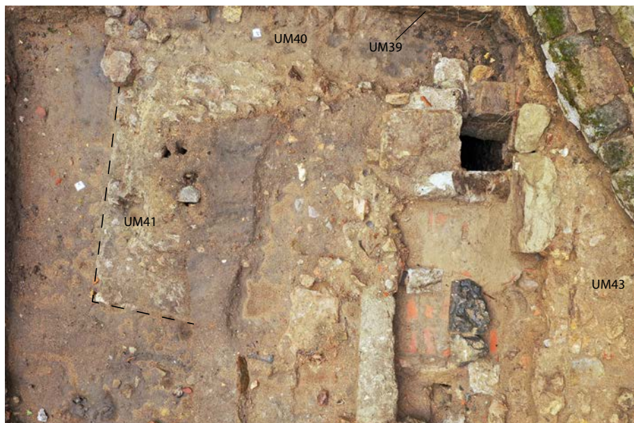
Fig. 141. Angle sud de l'extrados de la voûte, à gauche du cliché, et trappe d'accès au nord-est du cliché. DAO Y. Labaune, d'après Com'air.
