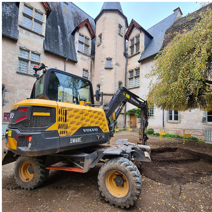
Fig. 59. Moyens mécaniques mis en œuvre dans un espace très contraint.
