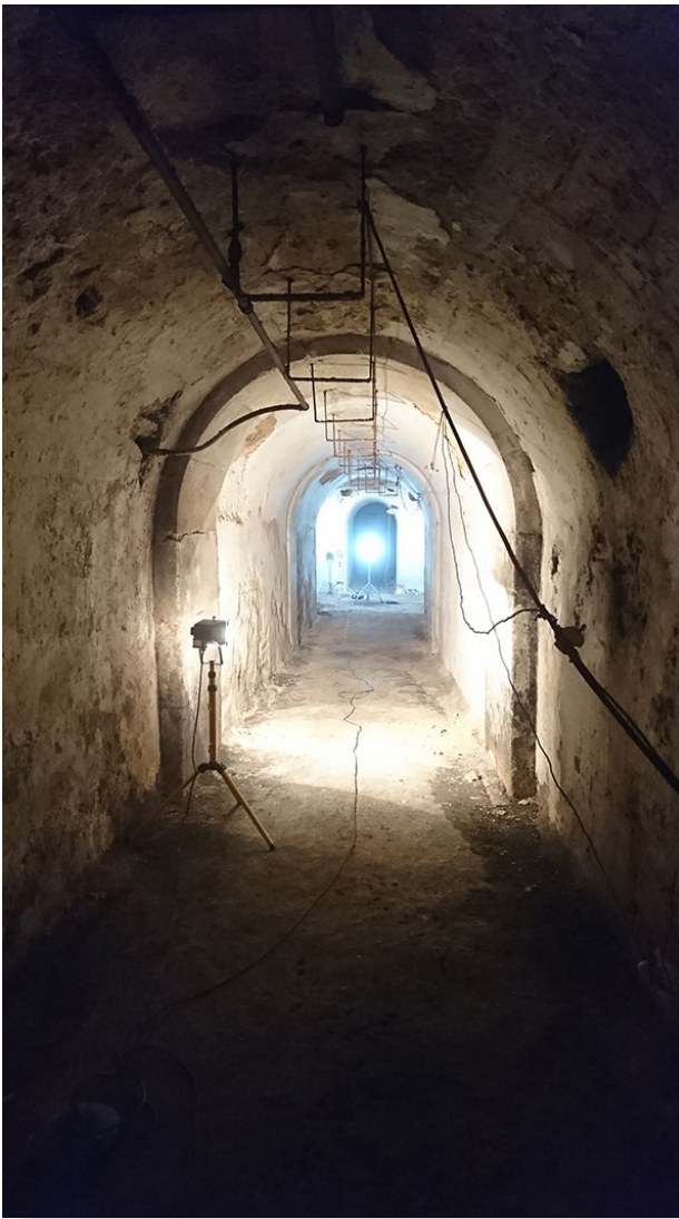
Fig. 71. Vue générale du couloir au début de l'intervention dans les sous-sols de la prison. Cliché C. Couderc
