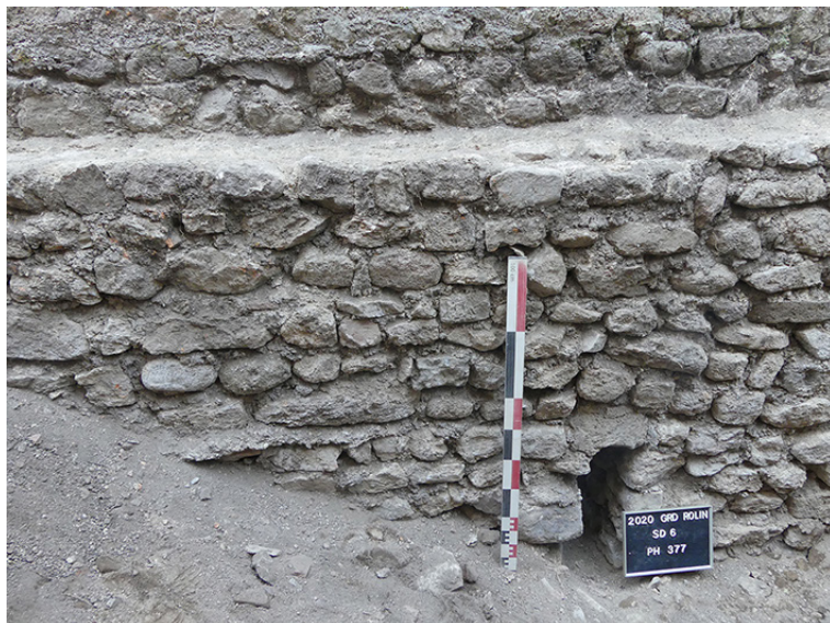
Fig. 130. Paroi de UC28.1 l'état le plus récent de la courtine à l'endroit du sondage (une reprise en sous œuvre ?). Cliché C. Couderc.
