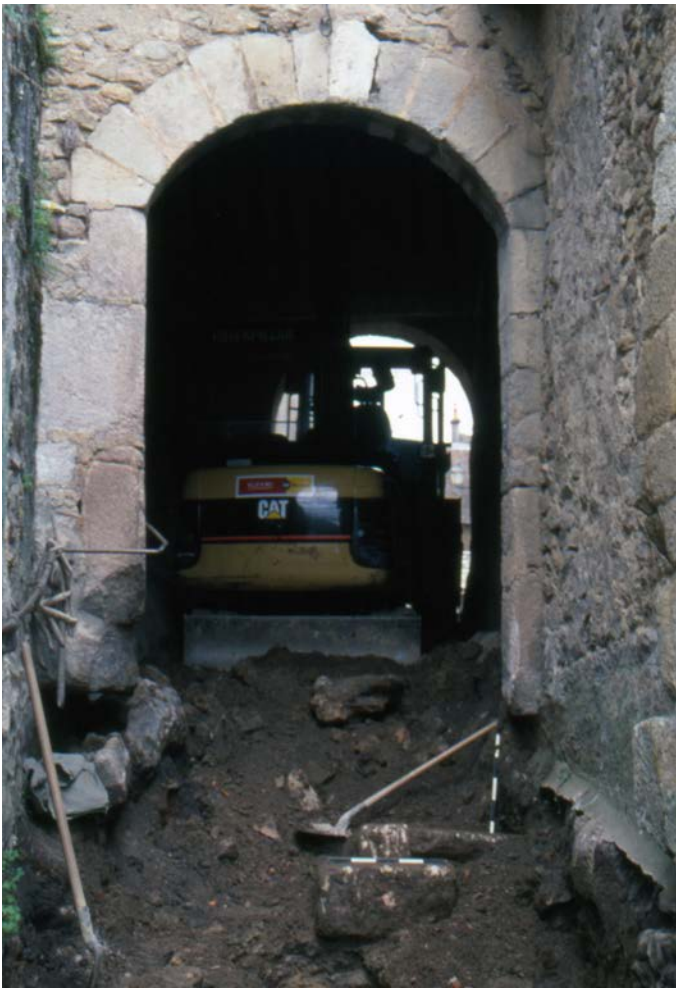
Fig. 17. Surveillance archéologique réalisée porte de Breuil. Un système de seuil (blocs avec crapaudine et butée) ménagé dans des grands blocs en grès parallélépipédiques apparaît sous les montants de l'élévation du XII e siècle. Etat de la poterne tardo-antique ou du haut Moyen-Age.
