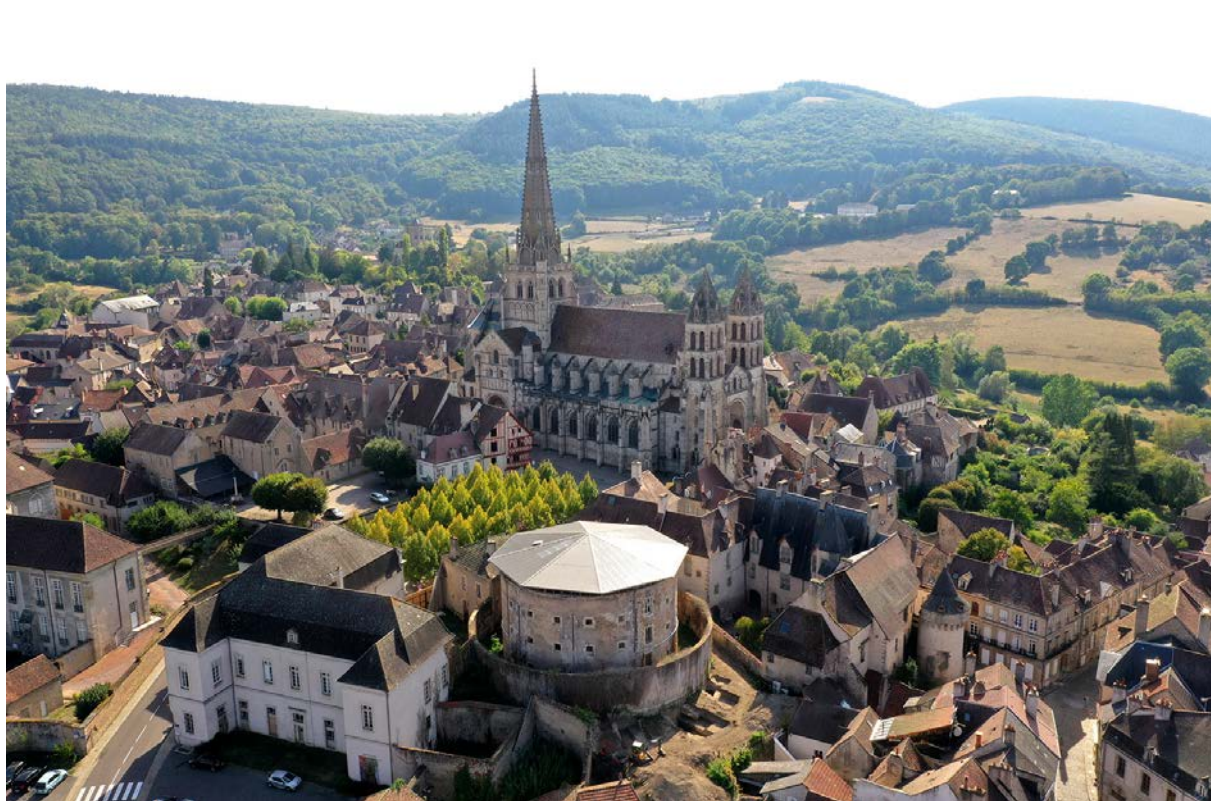
Fig. 2. Au premier plan le futur complexe muséal, avec de gauche à droite, l'ancien palais de Justice, l'ancienne prison Panoptique, l'hôtel Lacomme puis l'hôtel Rolin contre lequel s'élève la tour dite des Bances liée à la porte du XII e s. permettant d'accéder à la « ville haute » ceinte de sa fortification. La cime des arbres correspond à la place Saint-Louis. En arrière-plan la cathédrale Saint-Lazare et la pointe méridionale dominée par la tour dite des Ursulines. Cliché Com'air.
