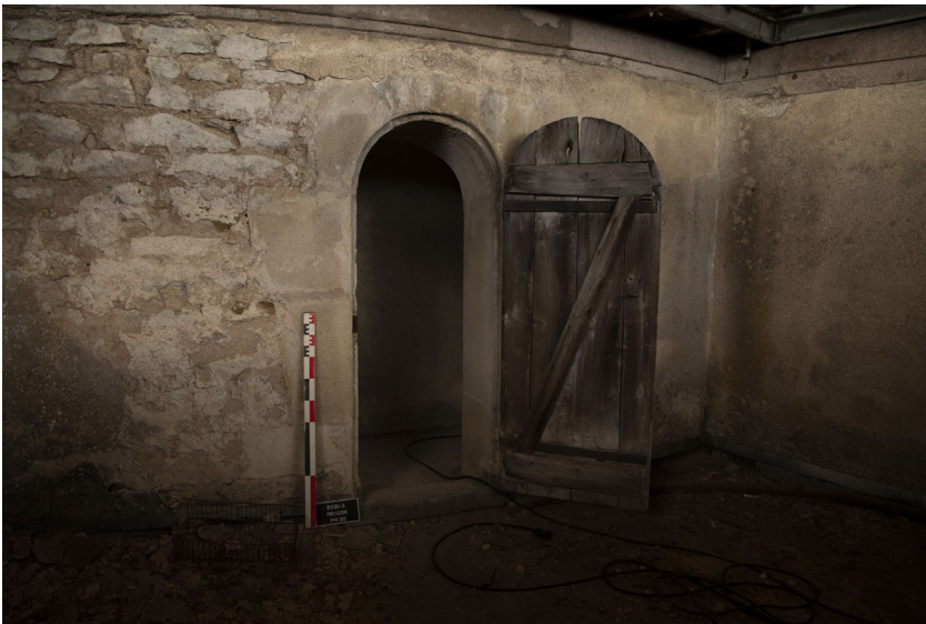
Fig. 43. Cours de promenade du troisième étage.
