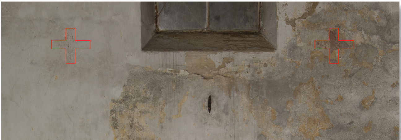
Fig. 61. Croix rouge visibles sur le parement intérieur de l'UM 2 dans l'espace PR_RDC_08.
