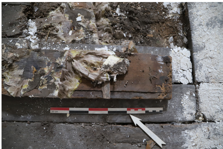
Fig. 78. Mérule active découverte sous un parquet de la prison. C. Couderc
