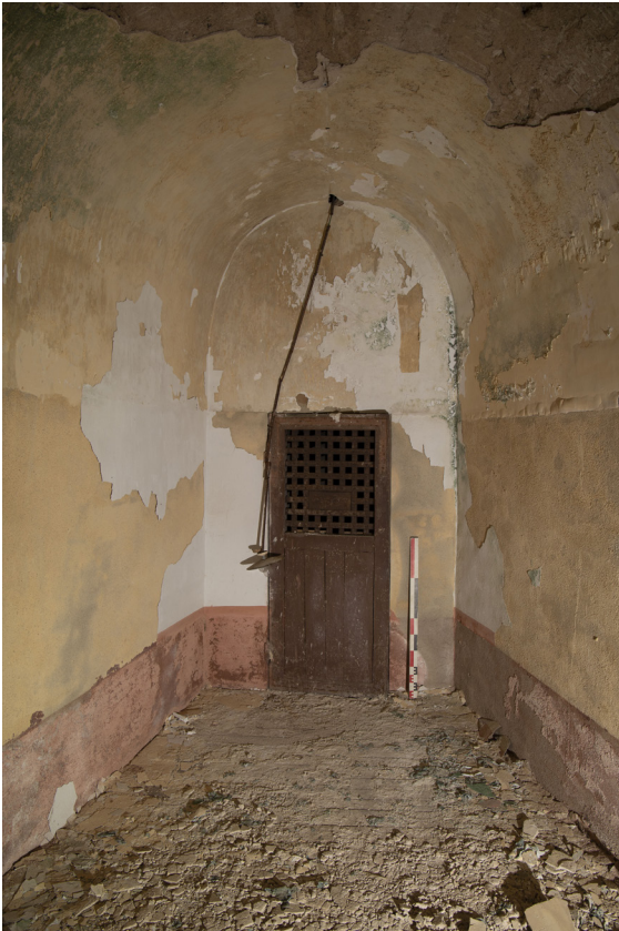
Fig. 55. Enduit jaune et rouge correspond au 2ème état de revêtement des geôles.
