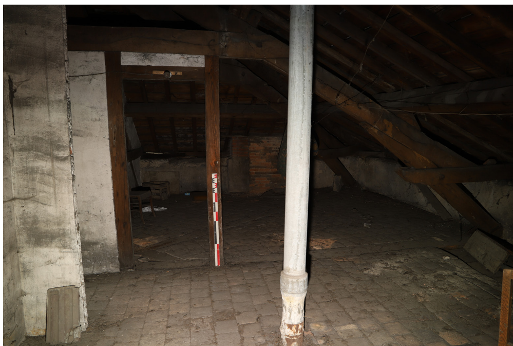
Fig. 24. Combles de la maison du gardien. Cliché C. Couderc
