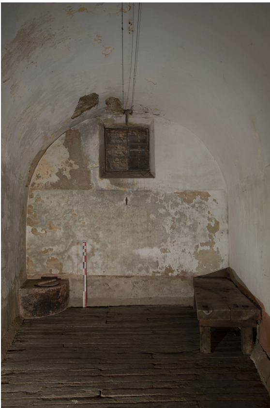
Fig. 29. Voutement de chaque geôle. Cliché C. Couderc
