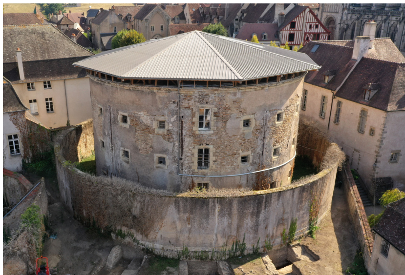
Fig. 27. Etat du parement extérieur de la prison (UM 2).
