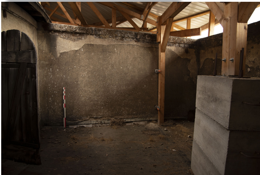
Fig. 18. Cours de promenade avec sol en bitume. Cliché C. Couderc
