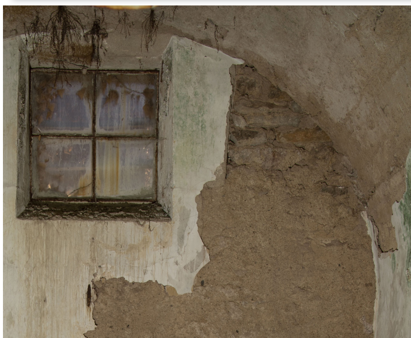
Fig. 28. Appareil des murs de la prison.
