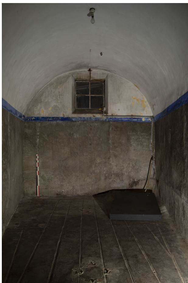
Fig. 60. Salle de bains (PR_RDC_12). Cliché C. Couderc
