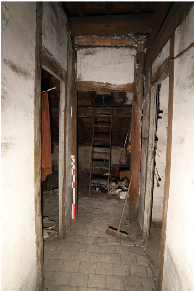
Fig. 25. Cloisons en briques clôturant l'espace des combles de la maison du gardien.
