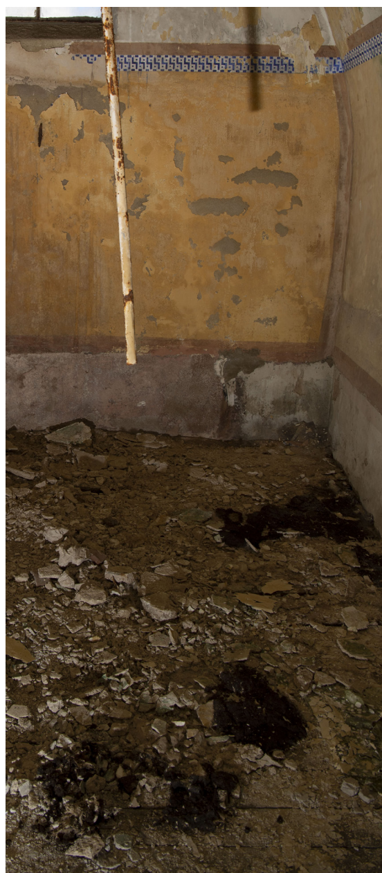
Fig. 80. Geôle PR_R2_17 : photographie prise en 2021 ; les souches de mérule sont toujours présentes au sol. C. Couderc
