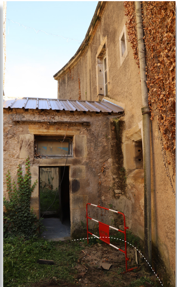
Fig. 26. Chaine d'angle arrondie au niveau du chemin de ronde.
