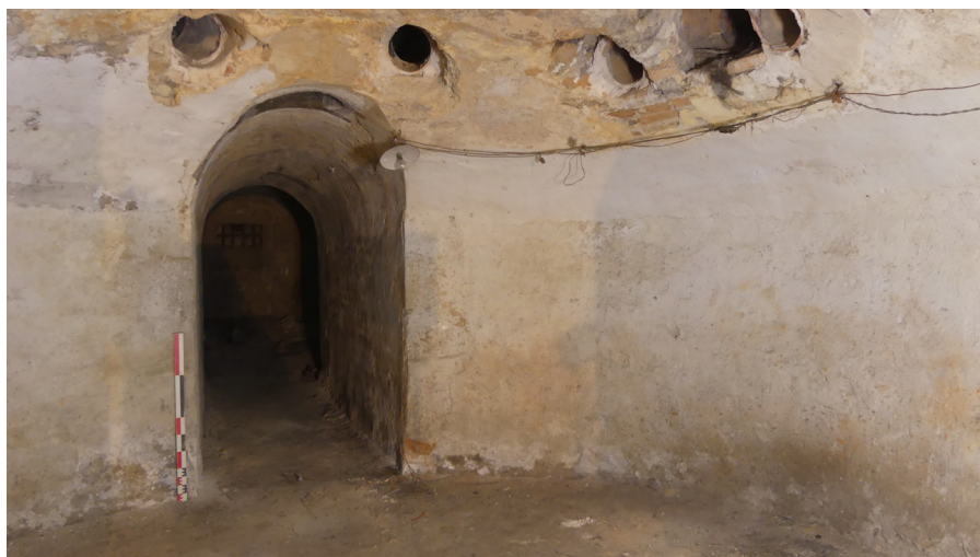
Fig. 42. La chaufferie. Cliché C. Couderc
