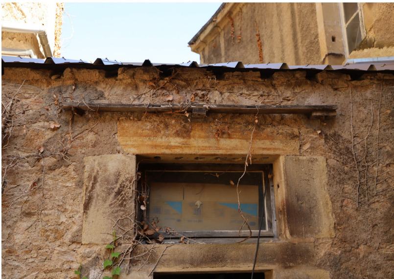
Fig. 64. Trace d'accroche d'un petit appentis côté ouest du chemin de ronde.
