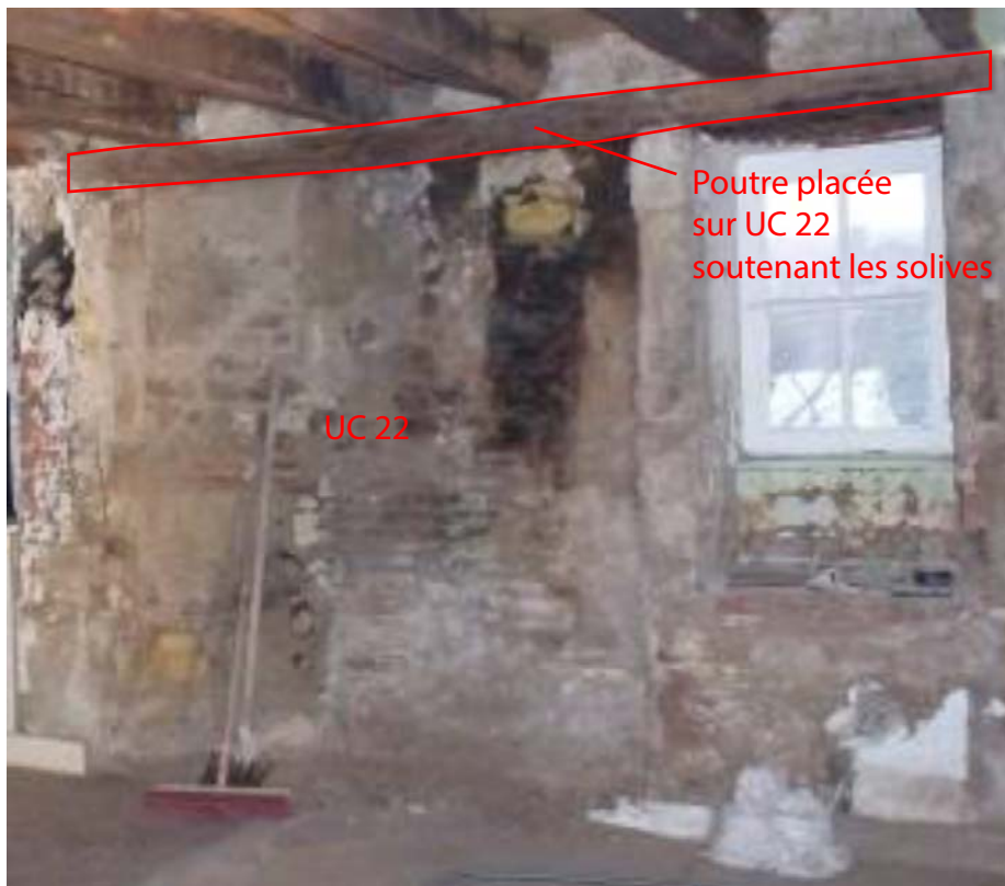
Fig. 30. Vue de la poutre s'appuyant sur le bouchage de la cheminée et soutenant le plafond (ESP 2). ©J. Barthel
