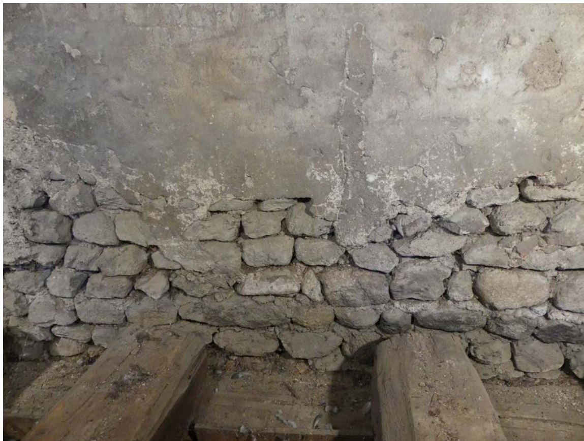
Fig. 58. Appareil du parement intérieur de l'UM 4. © C. Couderc
