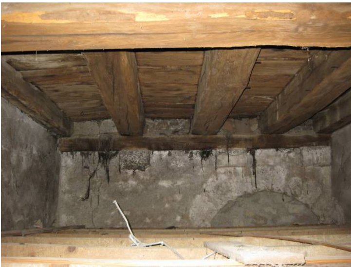
Fig. 39. Vue générale du sous-plafond (ESP 5). ©J.Barthel
