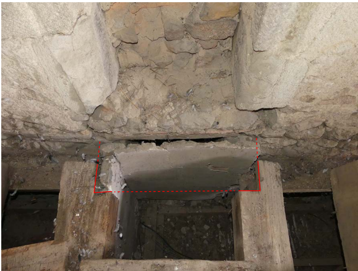
Fig. 47. Trémie correspondant à l'ancien conduit de cheminée.
