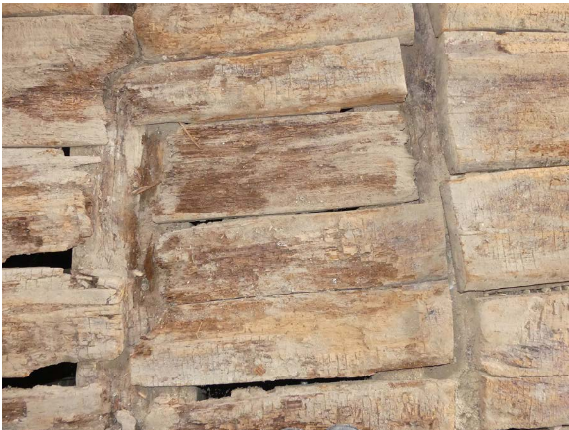
Fig. 46. Vue du parquet de l'ESP 6.
