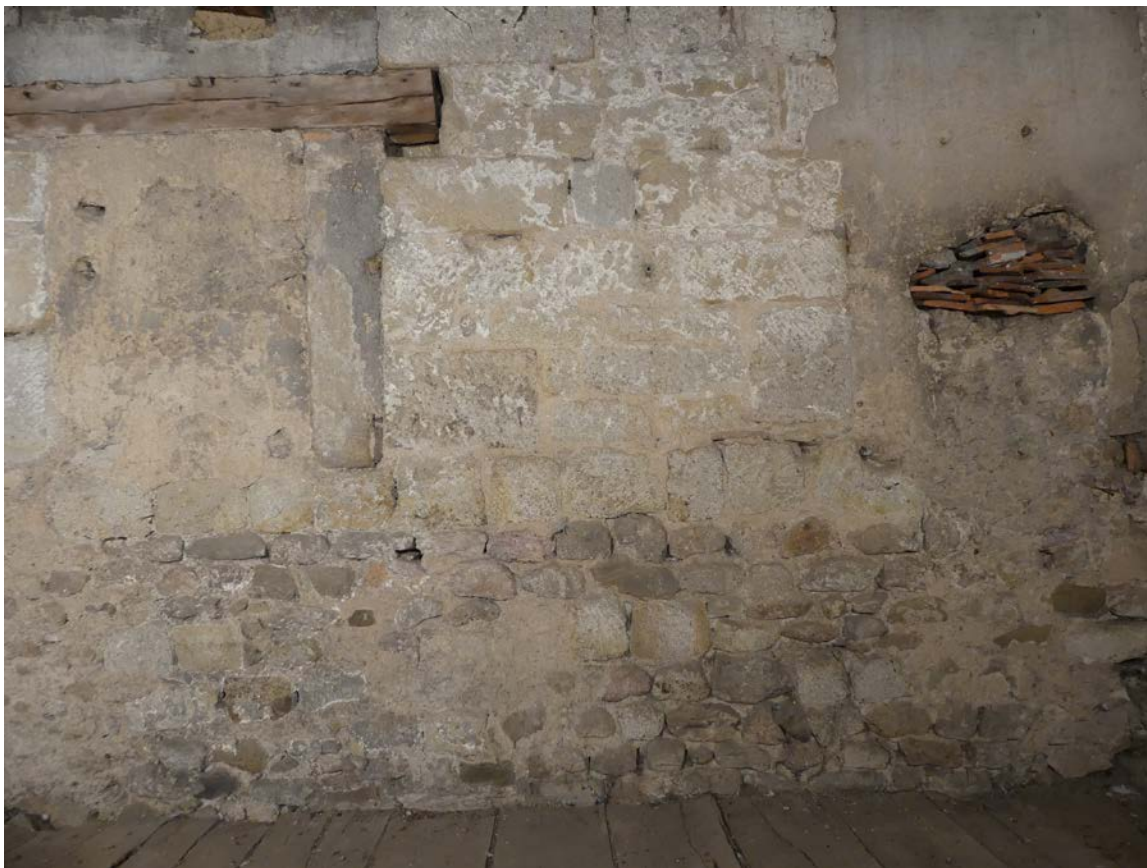
Fig. 75. Détails de l'appareil du parement intérieur de l'UM 4 (ESP 7). ©C. Couderc
