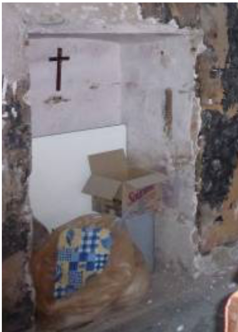
Fig. 34. Placard aménagé dans le mur ouest (UM 4 – ESP 2).
