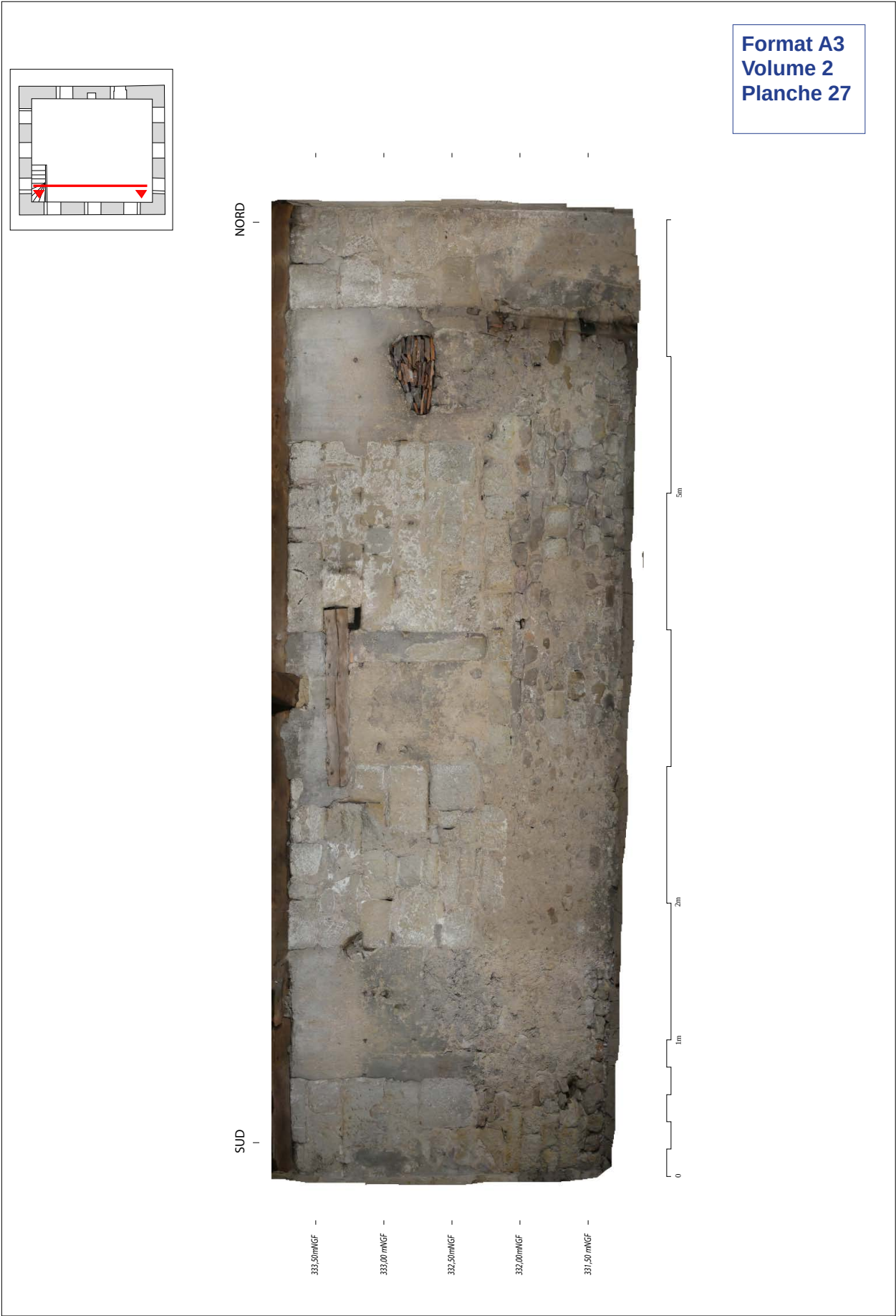
Fig. 70a. Orthophotographie du parement intérieur de l'UM 4 (ESP 7). Ech. : 1 : 25. Relevé et traitement : C. Couderc
