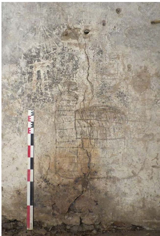
Fig. 3. Vue générale des graffitis présents au centre du mur sud (niveau 4 – ESP 6).
