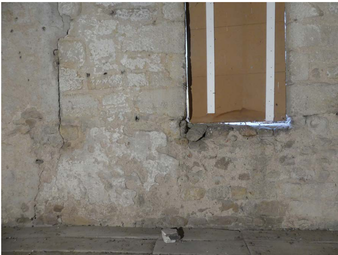
Fig. 76. Appui en moellons de la baie centrale de l'UM 3 (ESP 7). ©C. Couderc
