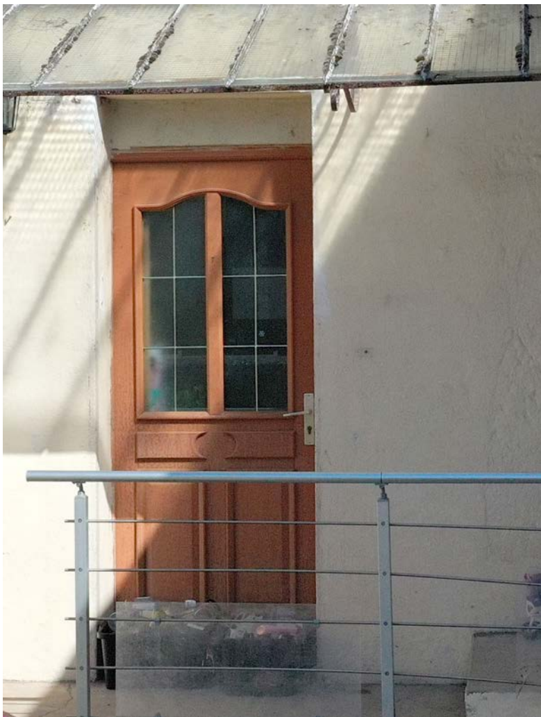
Fig. 26. Vue de la porte occidentale (UM 3). ©Com'Air
