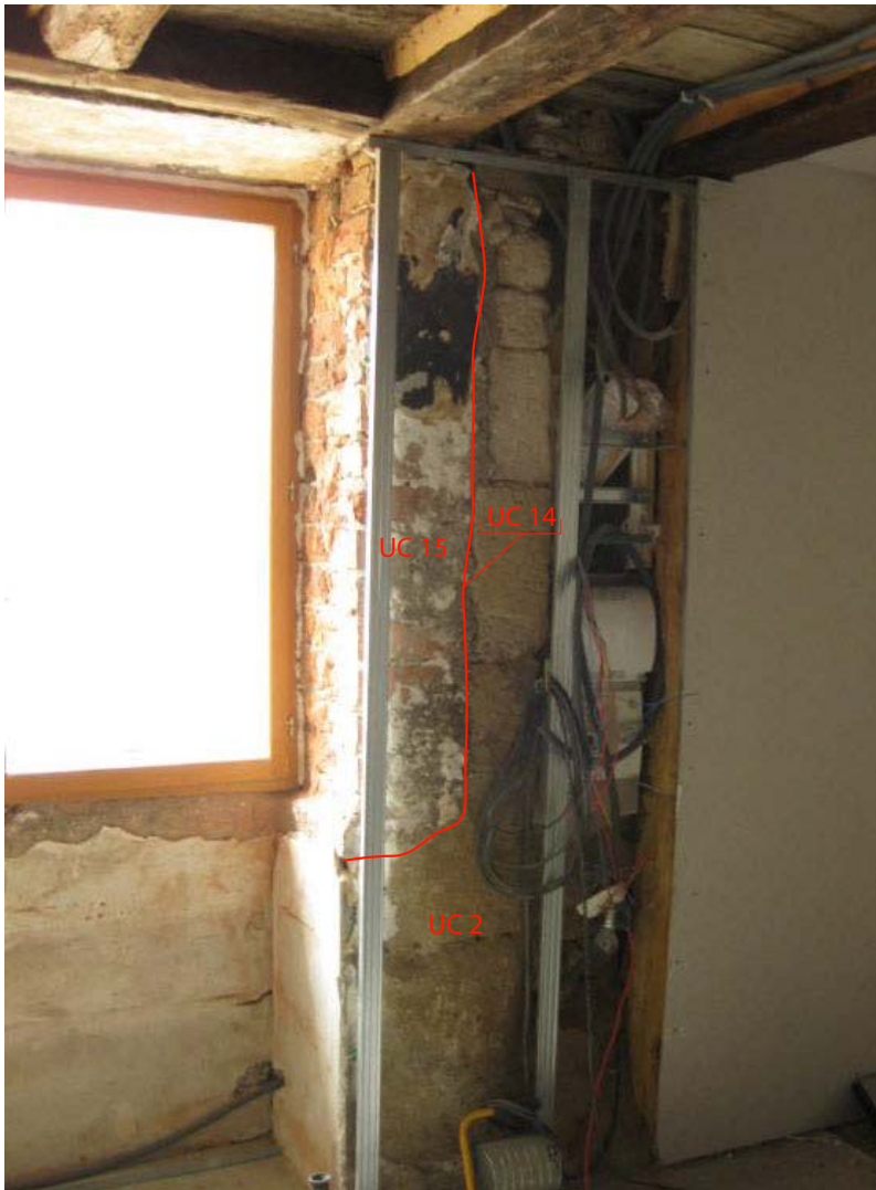
Fig. 32. Césure marquant l'insertion de la baie nord de l'UM 2 (ESP 2). © J. Barthel
