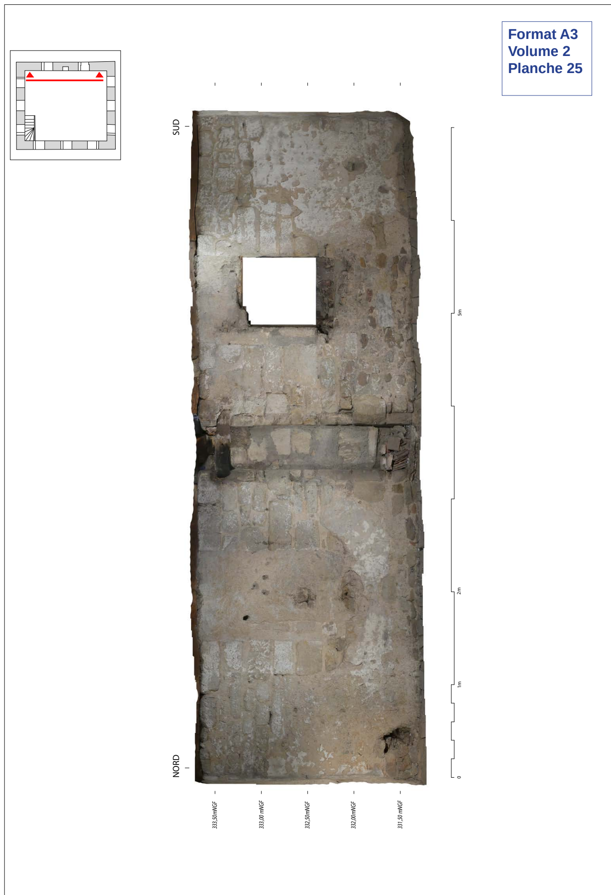
Fig. 69a. Orthophotographie du parement intérieur de l'UM 2 (ESP 7). Ech. : 1 : 25. Relevé et traitement : C. Couderc
