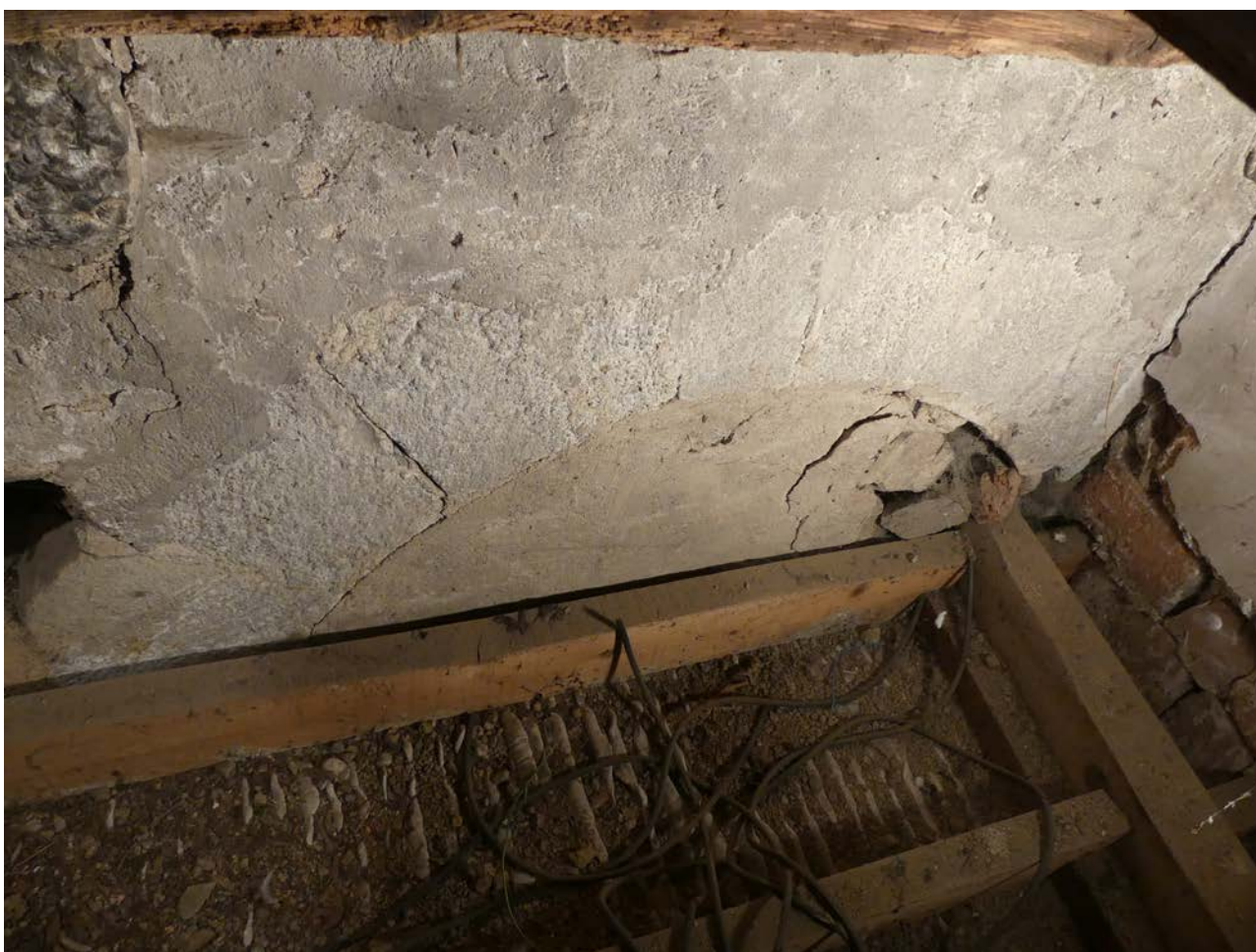
Fig. 41. Arc bouché visible sur le parement intérieur de l'UM 4.
