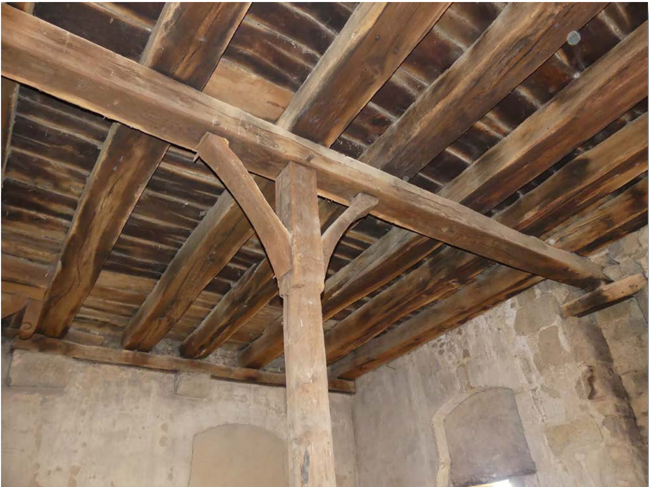
Fig. 48. Vue générale de l'ESP 6.
