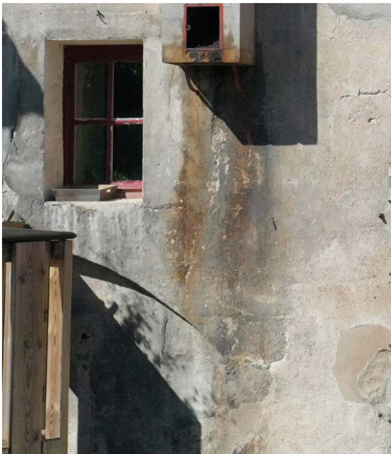
Fig. 24. Vue de la fenêtre sud au rez-de-chaussée (UM 2).
