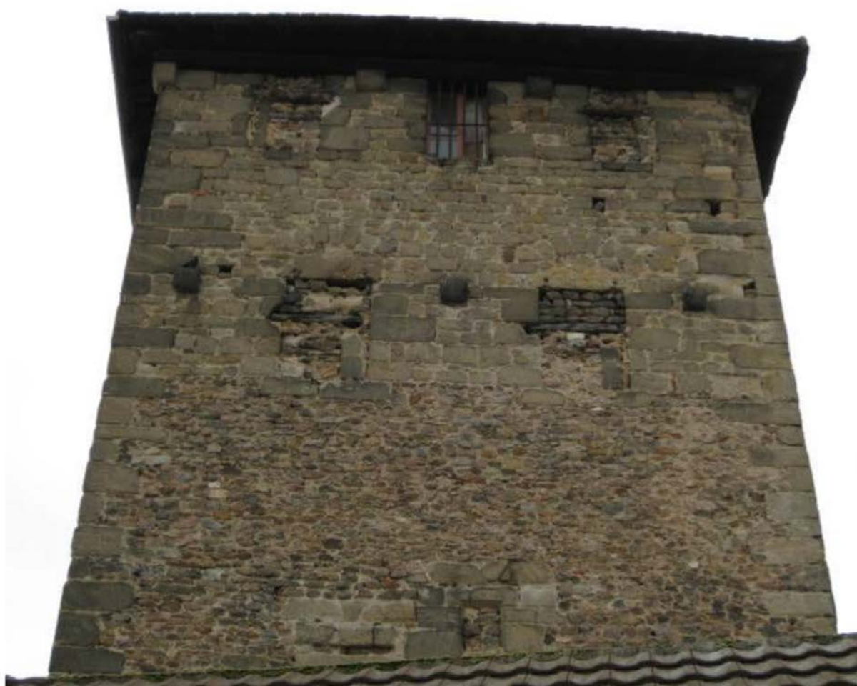
Fig. 43. Vue générale du parement extérieur de l'UM 1 avant les travaux de façade.
