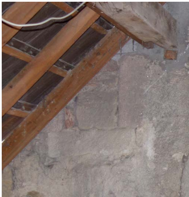
Fig. 37. Baie bouchée aménagée au deuxième niveau du mur sud (UM 3). Elle a été dégagée durant les travaux du bâtiment adossé au sud de la tour.
