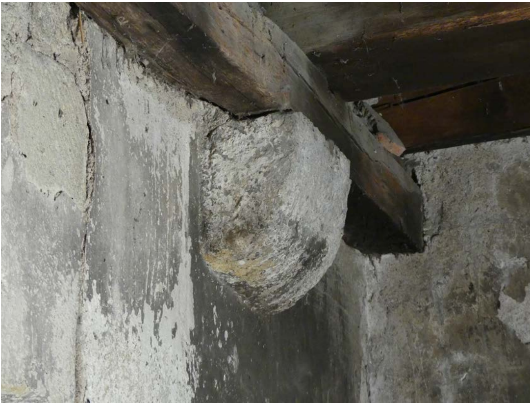
Fig. 61. Détail d'un corbeau soutenant le plafond de l'ESP 6.
