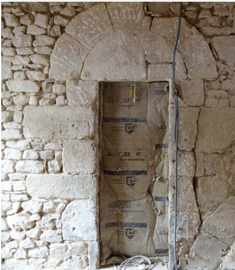
Fig. 27. Vue de la porte orientale (UM 3) avant les travaux de restauration. ©R. Legros
