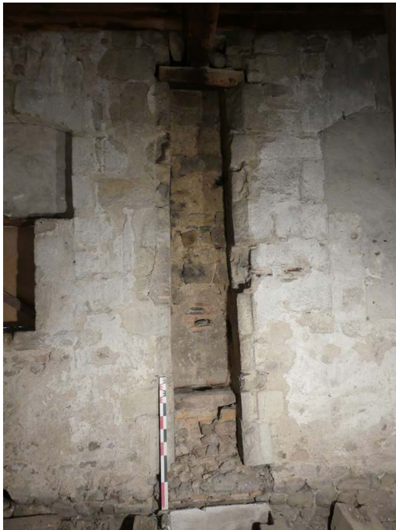
Fig. 60. Conduit de cheminée aménagé au centre de l'UM 2 (ESP 6).
