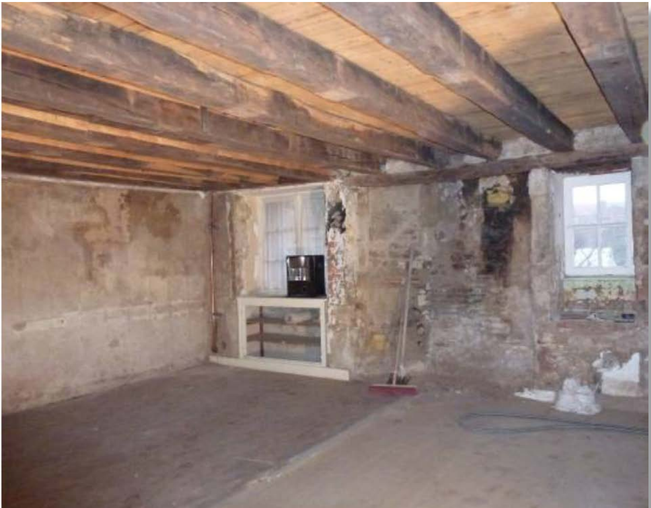
Fig. 17. Vue générale de la cuisine durant les travaux de 2011-2012. ©J. Barthel
