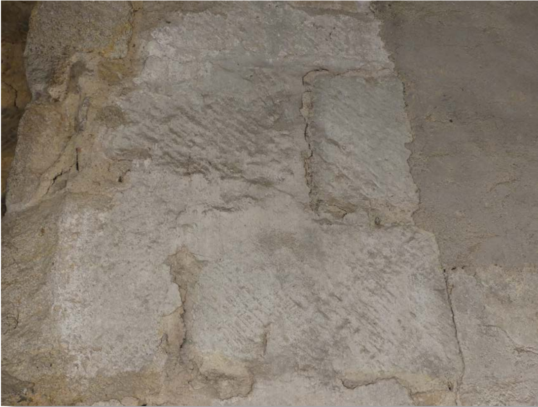
Fig. 59. Appareil du parement intérieur de l'UM 4. © C. Couderc
