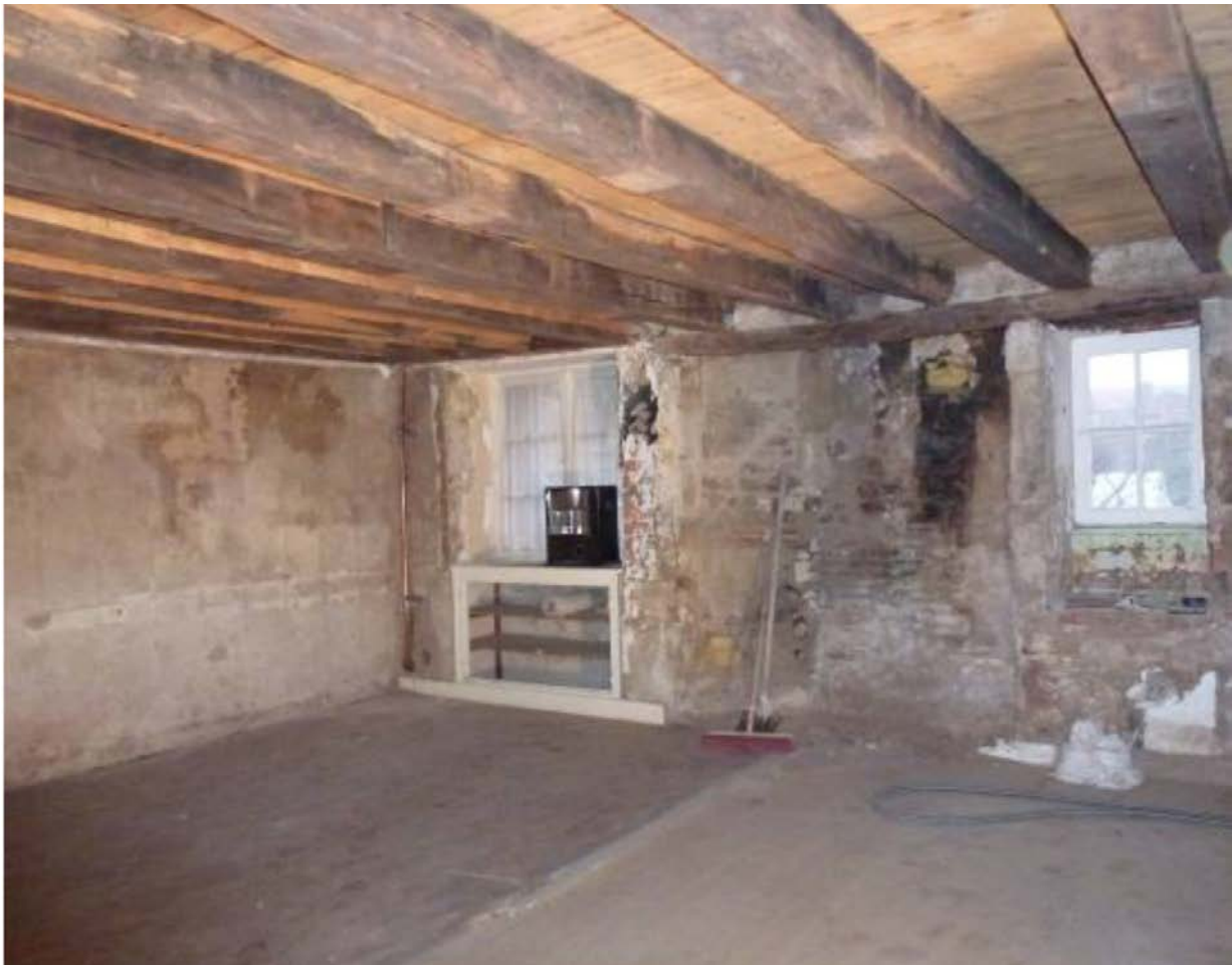
Fig. 29. Vue générale du plafond du rez-de-chaussée (ESP 2). ©J. Barthel
