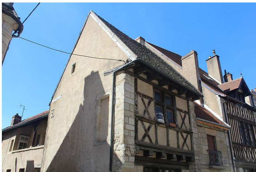
Fig. 48. Vue de la porte bouchée au premier étage dans l'UM2.
