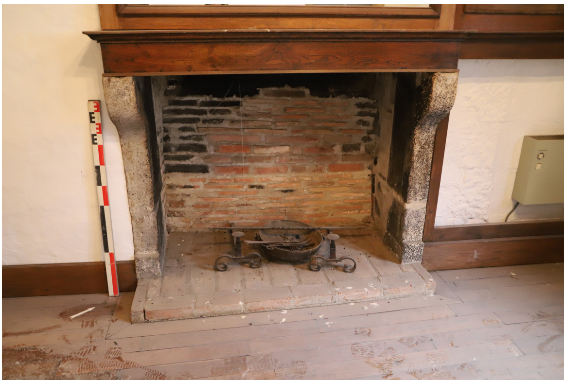
Fig. 28. Cheminée du premier étage. © C. Couderc
