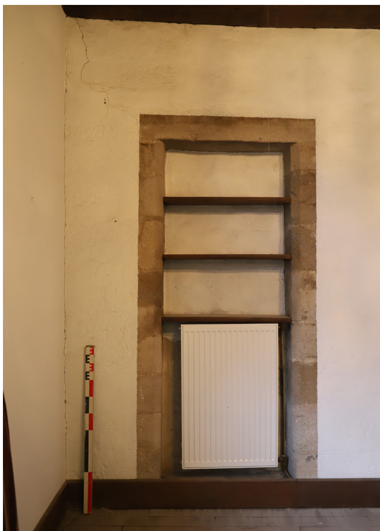
Fig. 29. Placard mural correspondant à une porte bouchée dans l'UM2. © C. Couderc
