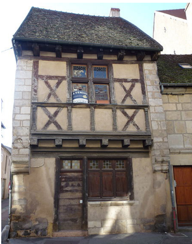
Fig. 27. Façade en pan-de-bois. © C. Couderc
