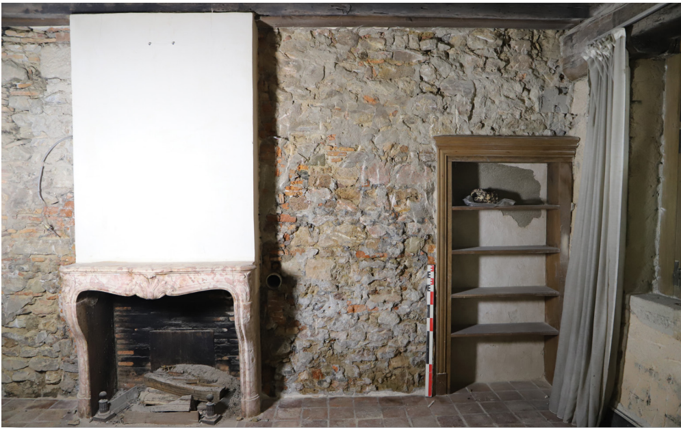
Fig. 59. Cheminée installée par M. de Ganay, propriétaire actuel. © C. Couderc
