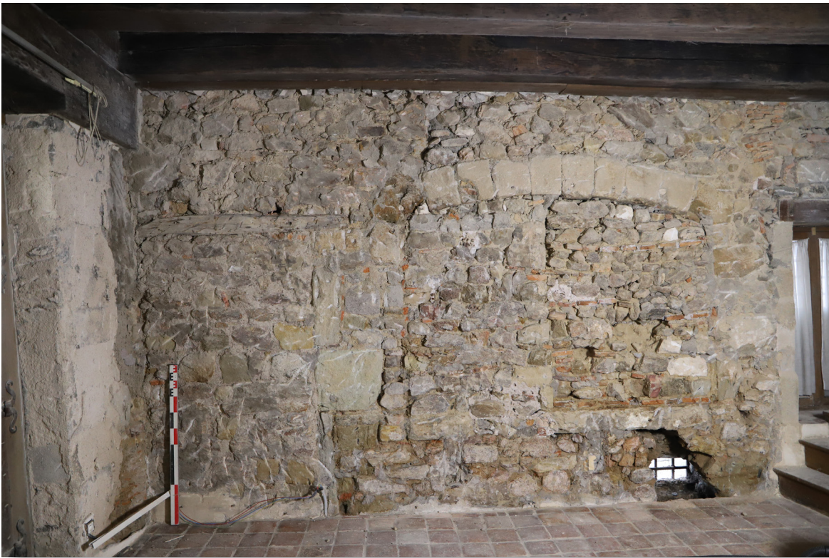
Fig. 17. Photographie des ouvertures de l'UM2.
