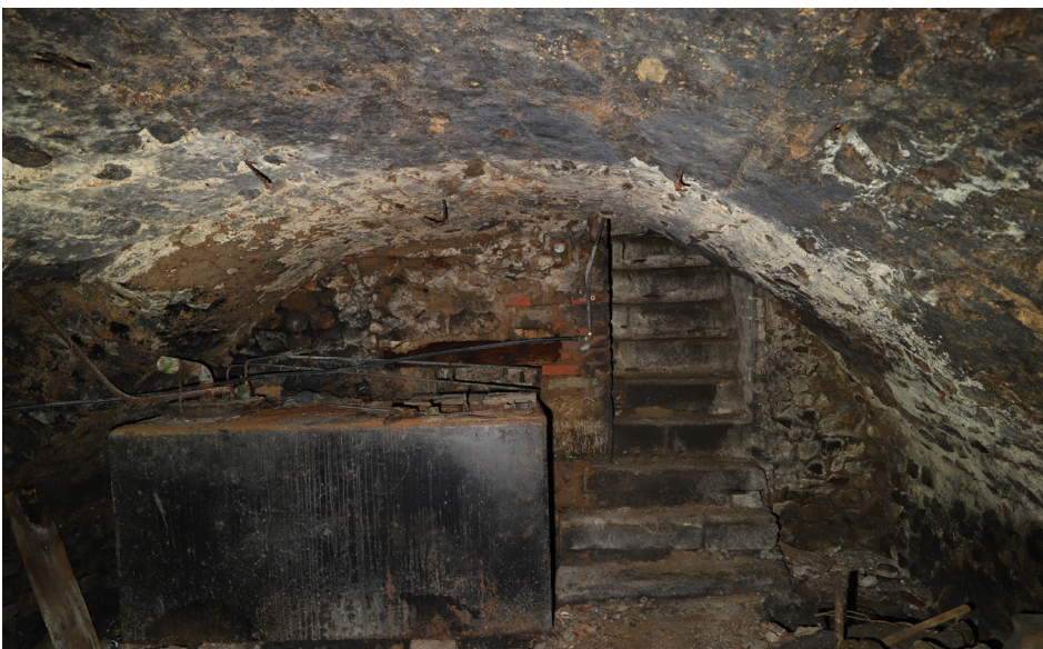
Fig. 51. Vue de l'escalier de la cave.
