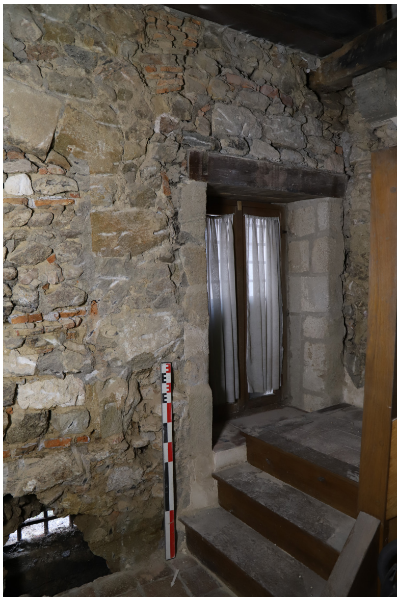
Fig. 25. Escalier desservant le premier étage.
