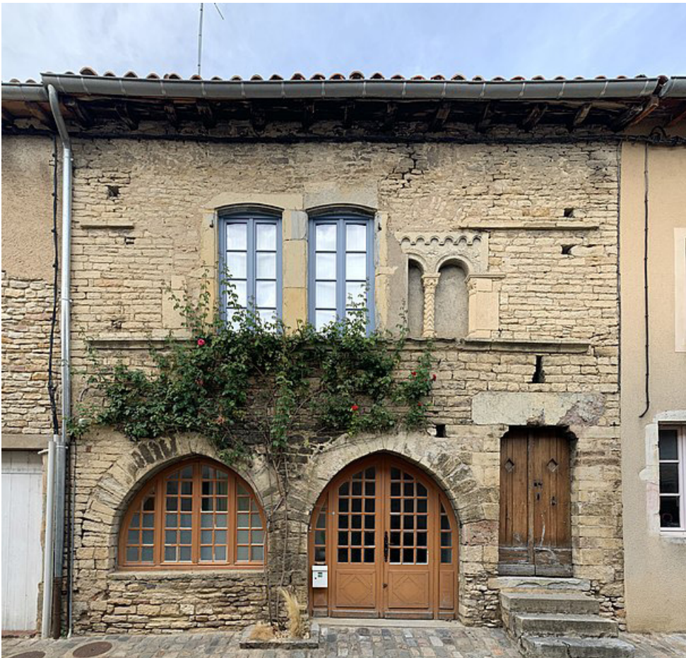
Fig. 46. Maison 12 rue d'Avril à Cluny. © Wikipédia
