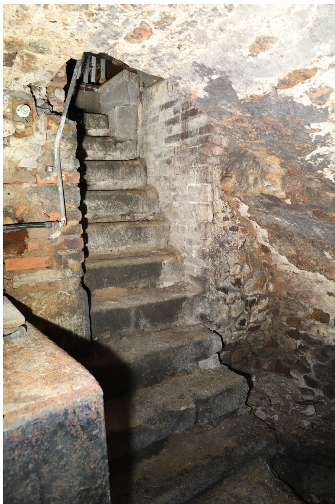
Fig. 12. Escalier d'accès à la cave. © C. Couderc
