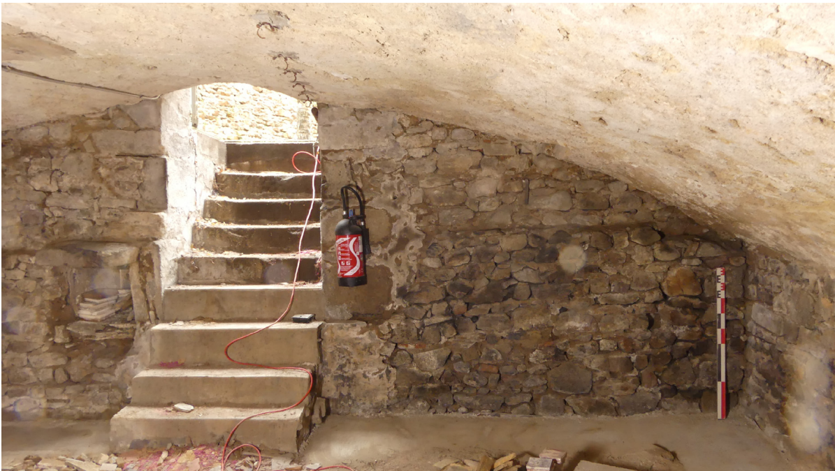
Fig. 37. Escalier de la cave nord de l'hôtel Rolin. © C. Couderc
