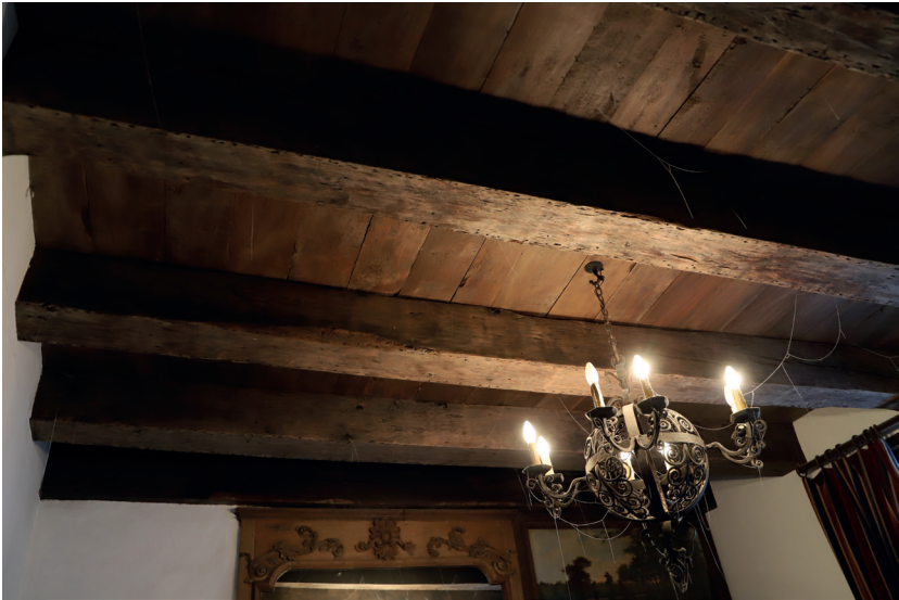
Vue générale du plafond
