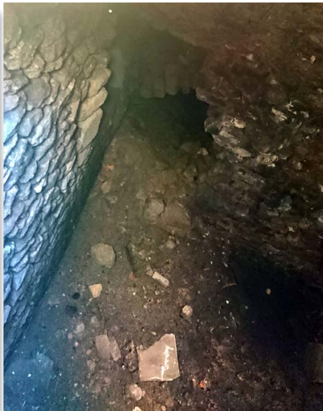
Fig. 81. Intérieur de la citerne / « fosse septique » St. 7.1 : cliché pris en 2021 en direction du nord et de l'ancien palais de Justice. A gauche l'arrivée de la canalisation St. 3, à droite l'éboulement / ouverture sommaire qui laisse entrevoir la poursuite de l'espace souterrain en direction de l'ancien palais de Justice.
