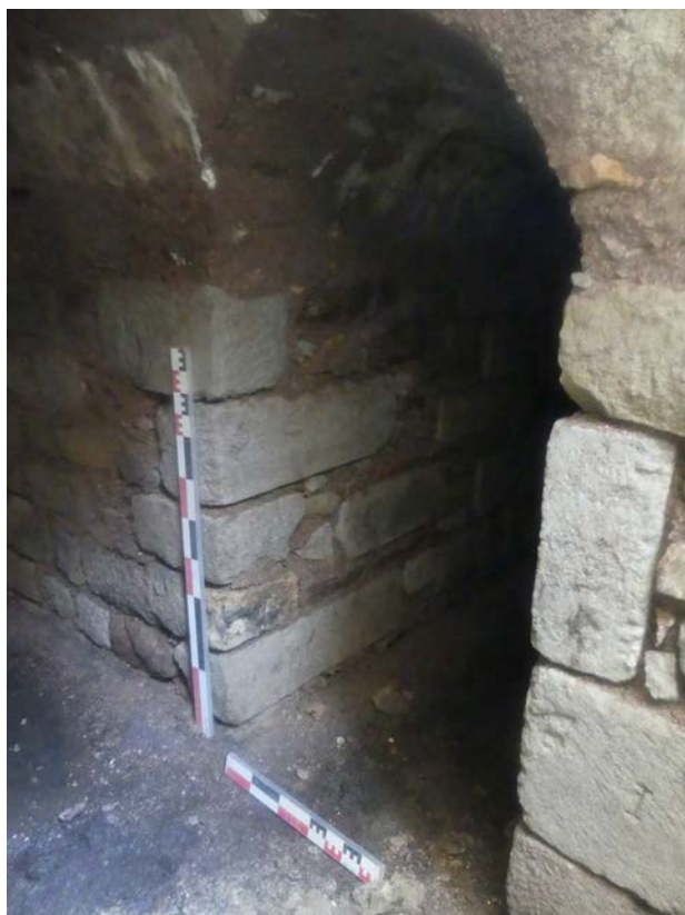
Fig. 80. Chainage d'angle entre le collecteur St. 1 (à gauche du cliché) et la conduite d'évacuation St. 3 (à droite du cliché).
