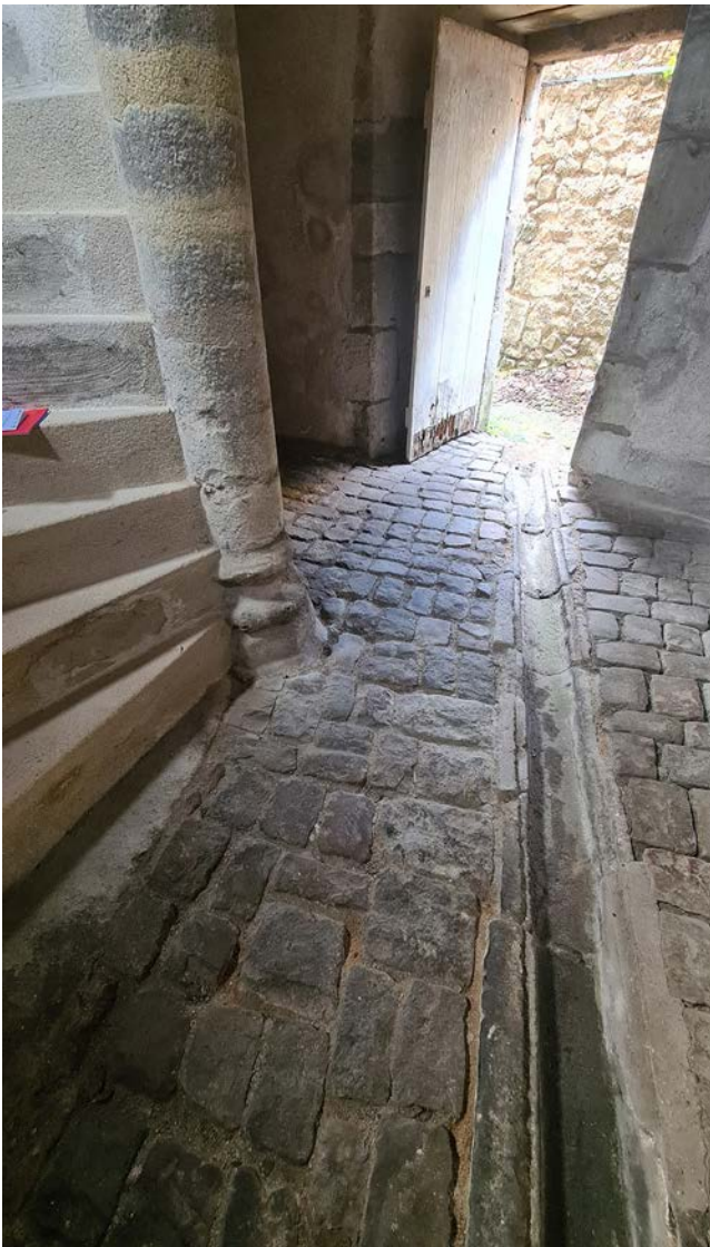
Fig. 60. Canal aménagé avec des dalles creusées de cunettes au pied de la tour Marchaux d'Autun. Cliché Y. Labaune
