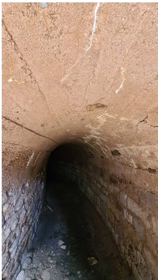
Fig. 38. Détail de l'intrados de St. 1 et de la voûte en béton banché : les négatifs de planches sont bien visibles.
