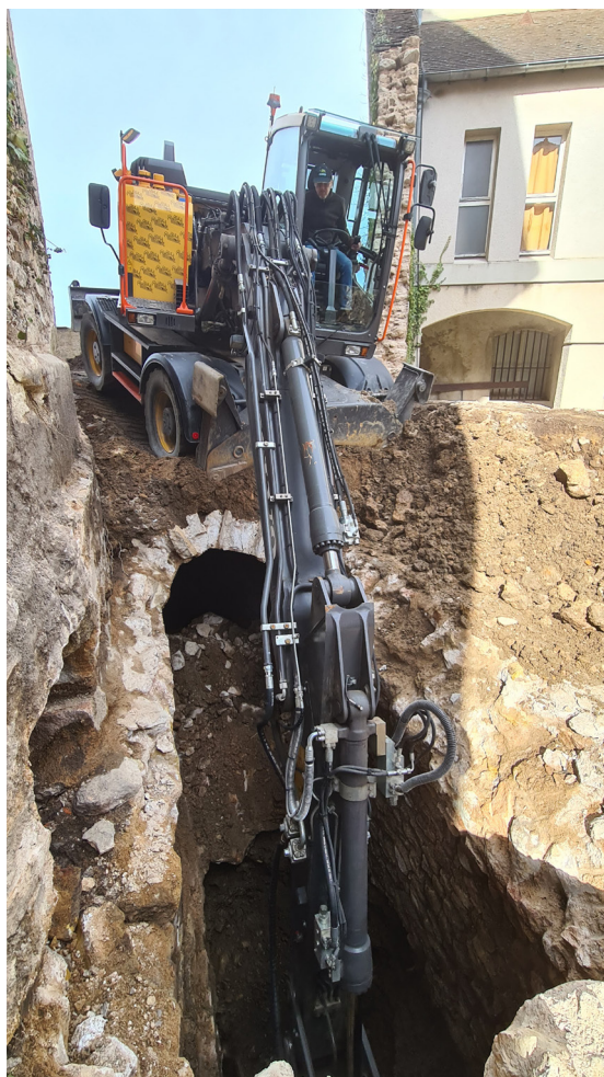
Fig. 7. Modalités complexes d'intervention : la pelle mécanique intervient à bout de bras depuis une plateforme ménagée au-dessus d'un espace creux, le collecteur voûté souterrain ceinturant la prison.
