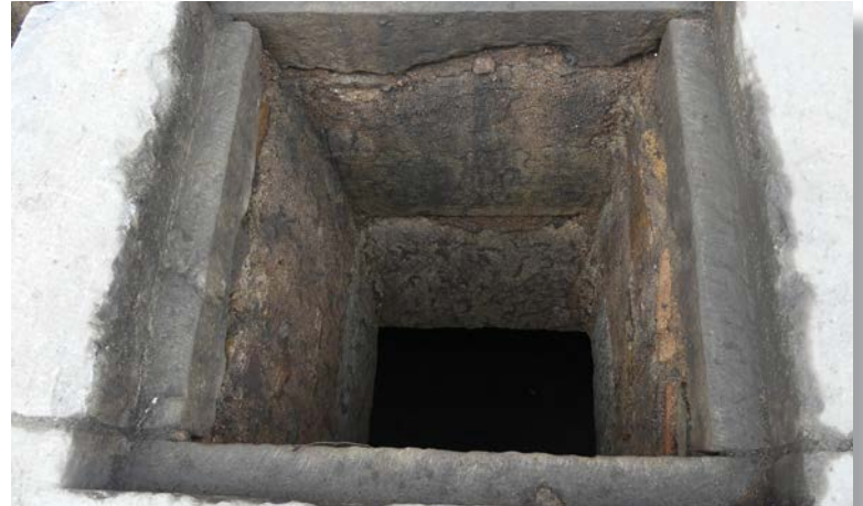
Fig. 76. Intérieur du regard de visite ménagé au travers de la voûte du collecteur St. 1.
