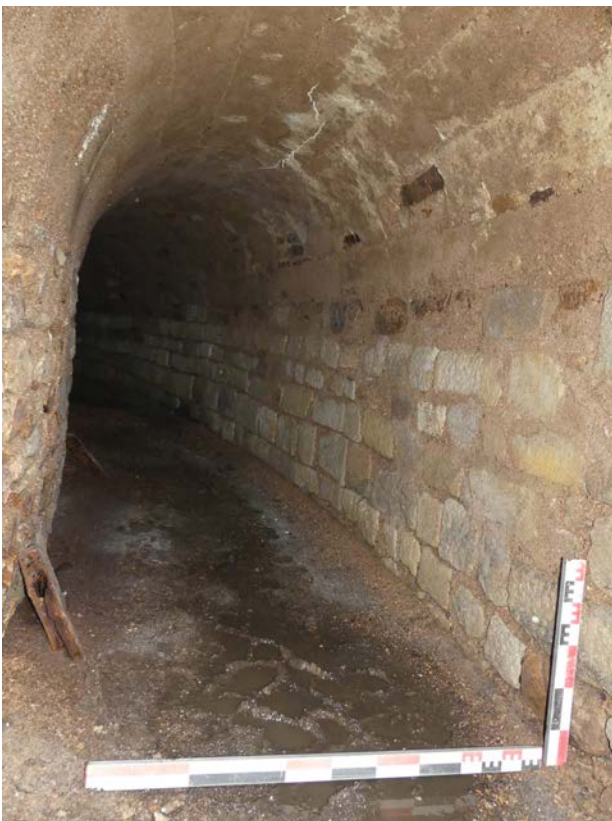
Fig. 71. Vue de l'intérieur du collecteur. A gauche la fondation du cylindre de la prison fait de blocs équarris fait office de piédroit, à droite le piédroit extérieur construit en beaux moellons taillés, dont certainement des remplois, en partie supérieure la voûte en béton banché.
