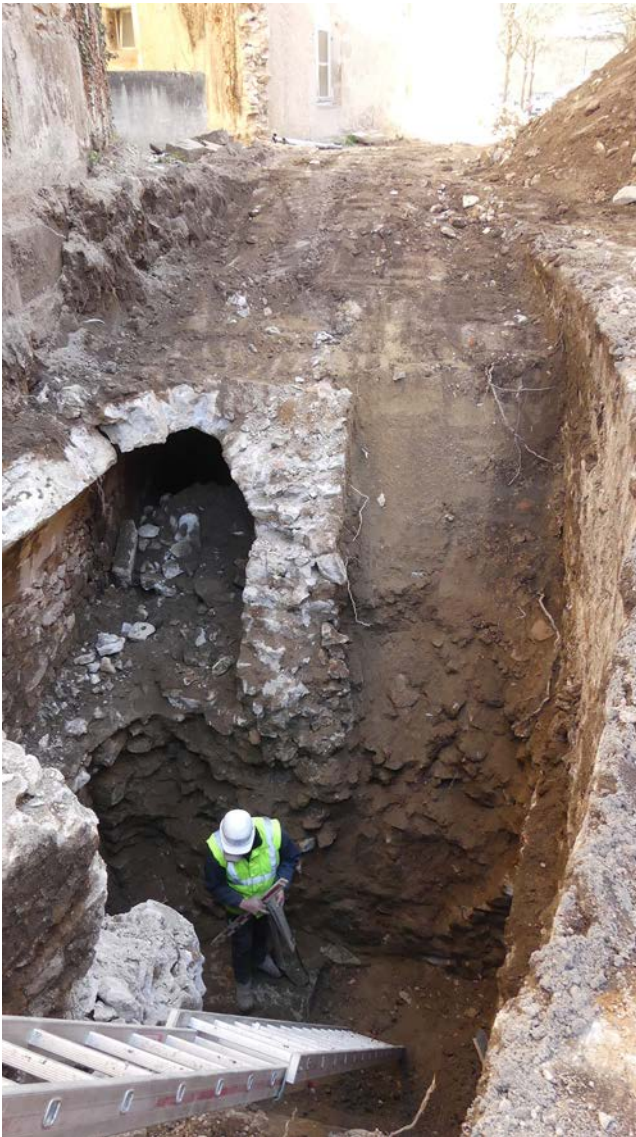
Fig. 18. Vue générale de la canalisation St. 1. A droite du cliché les fondations du mur circulaire périphérique du chemin de ronde.
