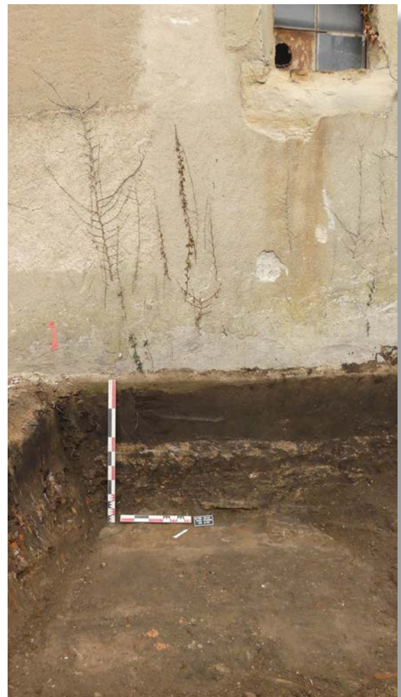
Fig. 56. Vue générale du niveau de chantier 3.02, scellant l'extrados du collecteur St. 1 venant buter contre les fondations de l'édifice carcéral. Cliché Y. Labaune pris en direction du nord-ouest.
