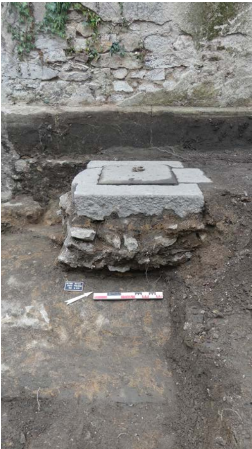
Fig. 75. Au premier plan, l'extrados de la voûte du collecteur souterrain puis, en arrière-plan, l'un des regards de visite qui affleurerait au niveau du chemin de ronde (sondage SD1).
