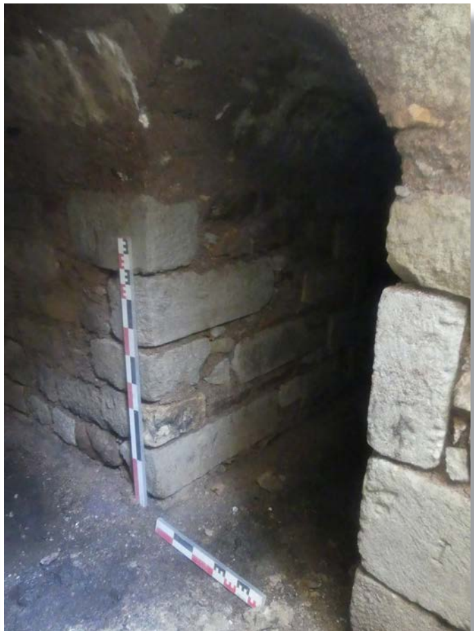
Fig. 51. Chainage d'angle entre St. 1 (à gauche du cliché) et St. 3 (à droite du cliché). Cliché Y. Labaune pris en direction du nord-est.
