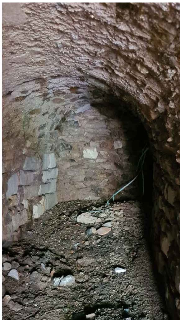
Fig. 48. L'une des deux extrémités du collecteur St. 1 située à l'est du pavillon des gardiens. La maçonnerie qui « ferme » le collecteur pourrait être celle des fondations de la maison des gardiens (?).
