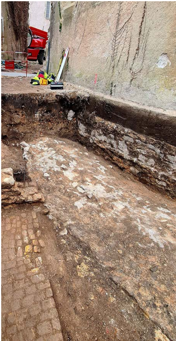
Fig. 33. A droite du cliché, on observe la couronne de blocs de grand appareil ceinturant le cylindre de la prison, puis le départ des fondations 3.21, chaînée avec l'extrados du collecteur enterré St. 1 que l'on observe en partie centrale.
