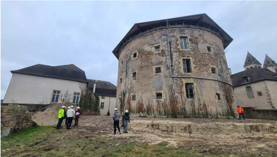
Fig. 6. Aspect de la prison Panoptique après démontage du mur ceinturant le cylindre de la prison au niveau du sol de circulation du chemin de ronde. Cliché Yannick Labaune.
