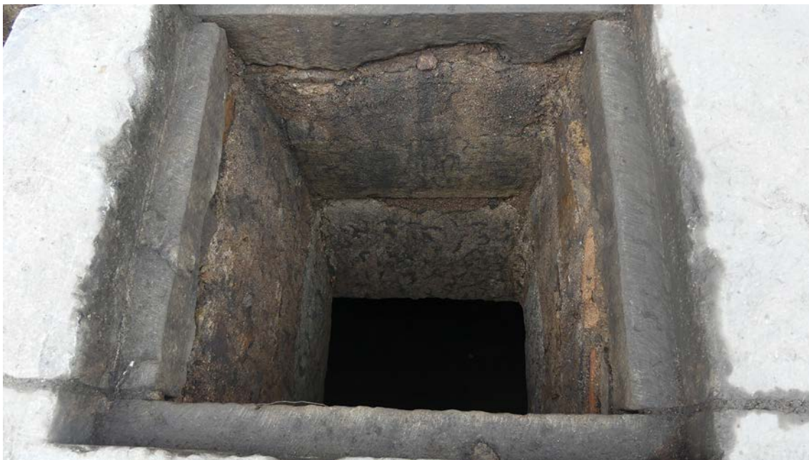
Fig. 41. Intérieur du regard de visite ménagé au travers de la voûte du collecteur St. 1.
