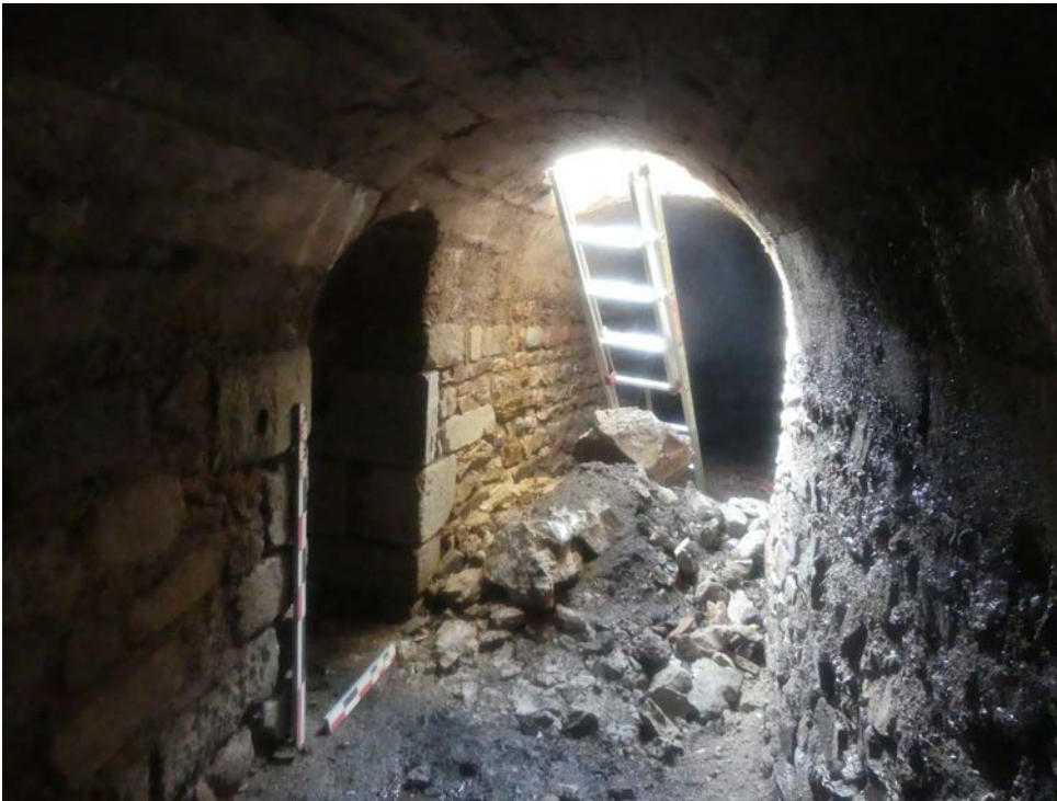
Fig. 49. Embranchement St. 1 / départ de St. 3 en direction d'une citerne / « fosse septique » St. 7.1. Cliché Y. Labaune pris en direction du sud-ouest.
