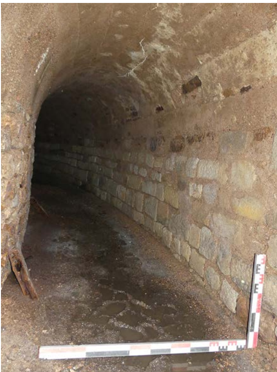
Fig. 37. L'intérieur du collecteur St. 1 : à droite le piédroit externe UM4=3.17 ; en haut la voûte en béton banché.
