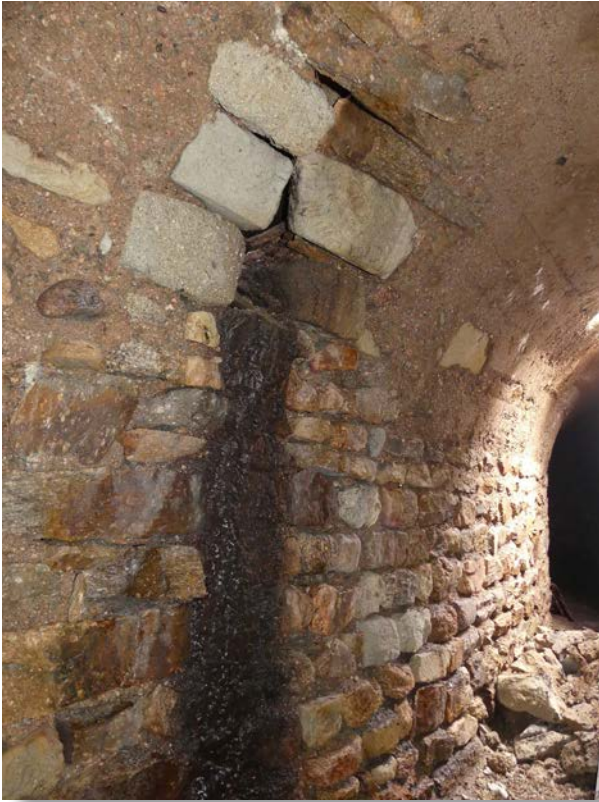
Fig. 73. L'un des exutoires ménagés au travers de la voûte situé à l'aplomb des conduites métalliques d'eau pluviale installées en façade de l'édifice carcéral.
