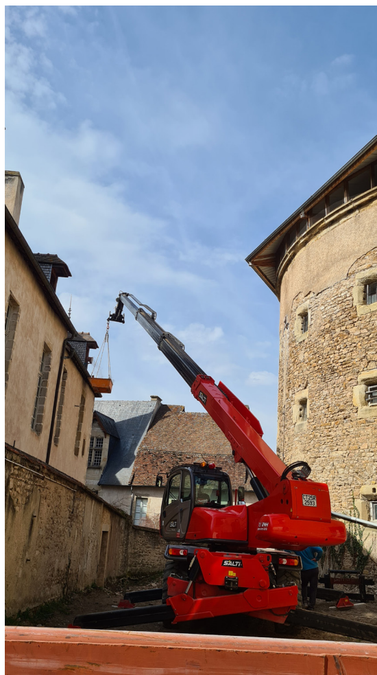
Fig. 8. Phase de co-activité avec l'entreprise chargée du curage des combles de l'hôtel Rolin. Cliché Y. Labaune
