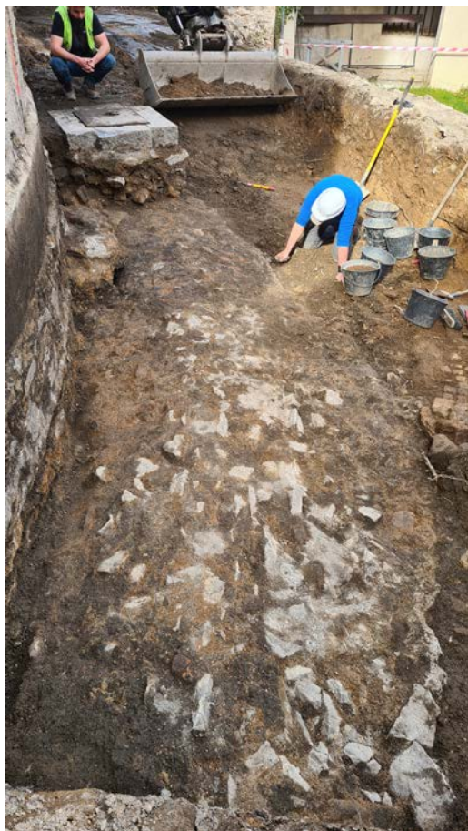
Fig. 72. A gauche la façade du cylindre, la couronne en grand appareil marquant le départ des fondations qui sont liées à la voûte du collecteur dont on aperçoit l' extrados . Au second plan l'un des regards de visite.
