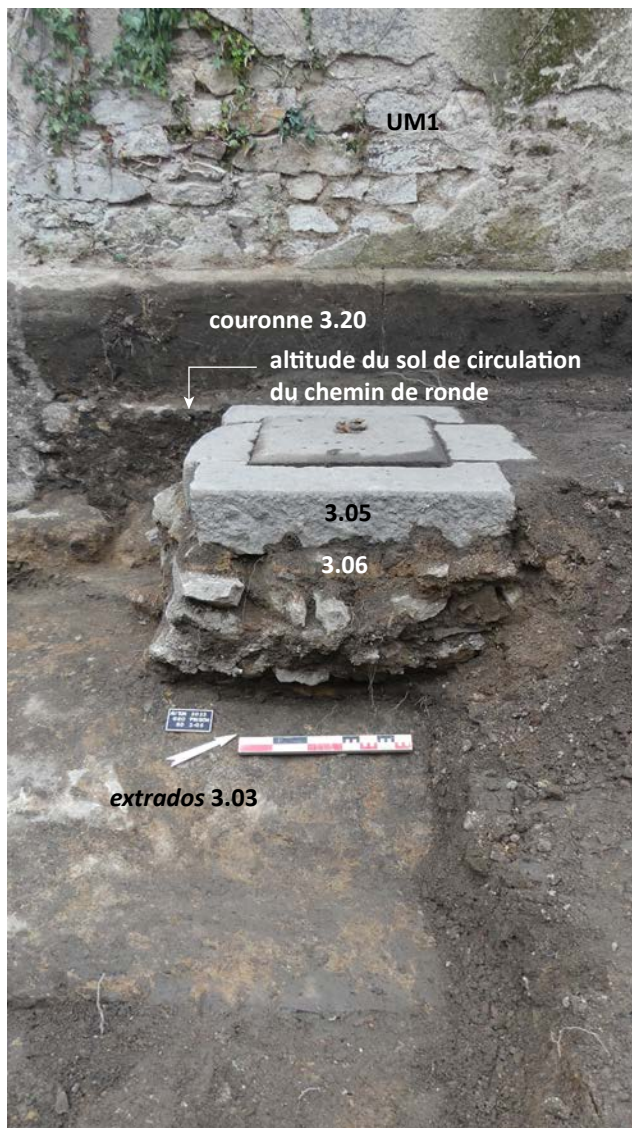
Fig. 40. Au premier plan, l'extrados de la voûte du collecteur St. 1 puis, en arrière-plan, l'un des regards de visite (3.05, 3.06) qui affleurerait au niveau du chemin de ronde.
