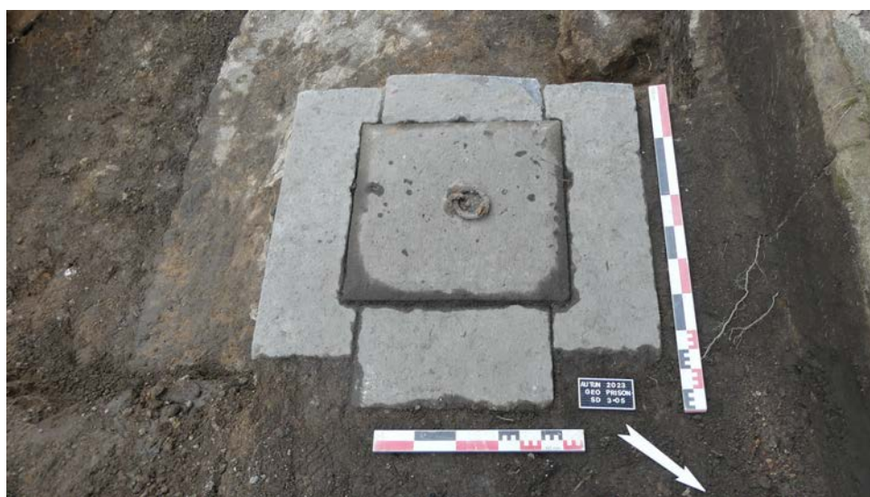
Fig. 43. Regard de visite dans le collecteur St. 1 : aménagement 3.05 avec sa dalle d'obturation.
