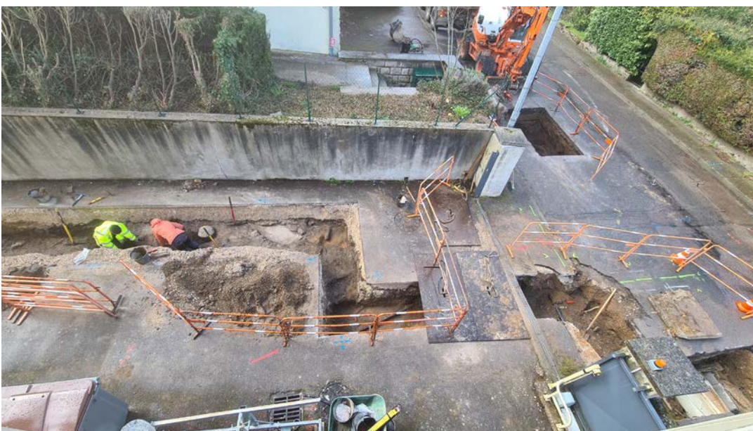
Fig. 7. Vue générale de la tranchée et du raccordement au réseau de chaleur situé rue de Gaillon.
