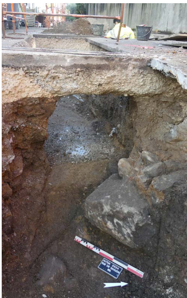
Fig. 45. Au premier plan le mur bahut M6 et l'une de ses fondations de colonne sous la forme d'un bloc de grès de grand appareil. Au second plan, le système de sols de circulation 15 qui arrive au contact de M6.
