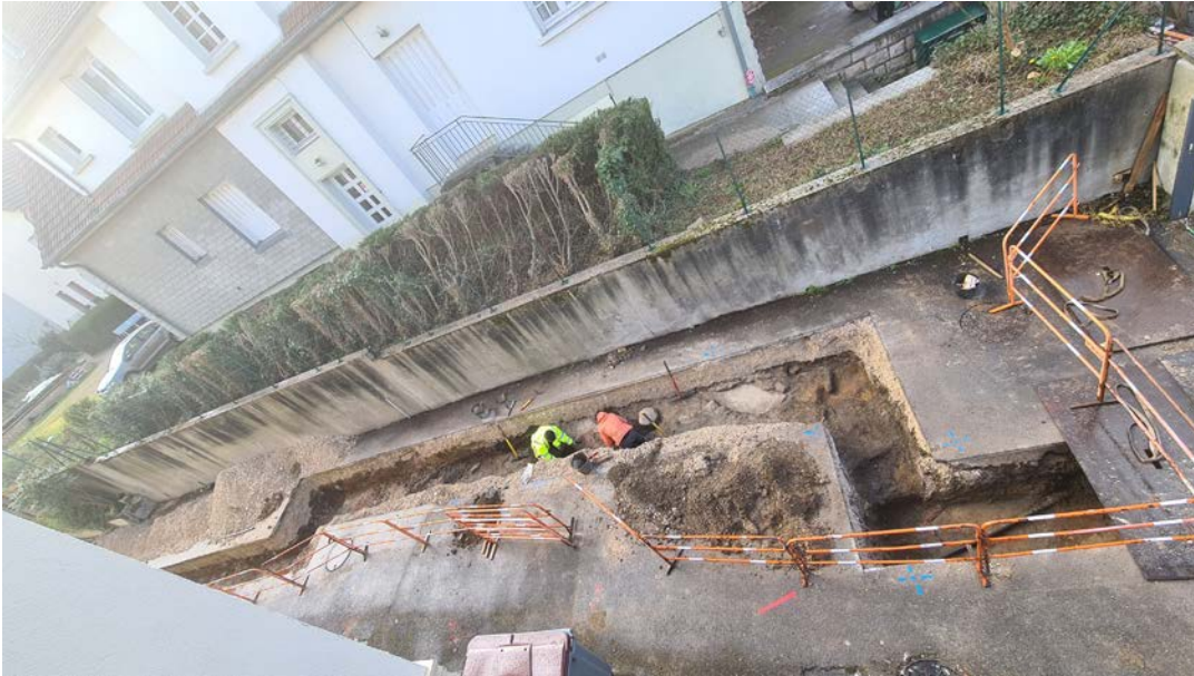
Fig. 6. Vue générale de la tranchée ayant fait l'objet d'un suivi archéologique, à l'endroit où la stratigraphie antique était la mieux conservée.
