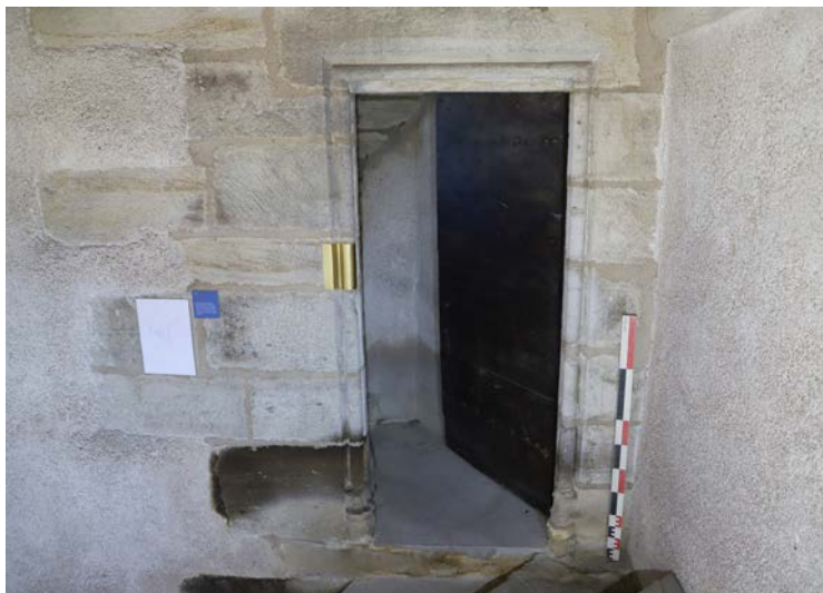
Fig. 43. Porte d'accès à l'escalier en encorbellement depuis le premier étage de la tour (OUV 45)
