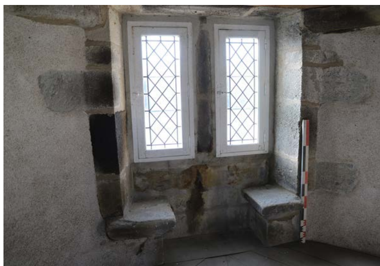
Fig. 41. Baie à meneau et coussièges au premier étage de la tour Marchaux .
