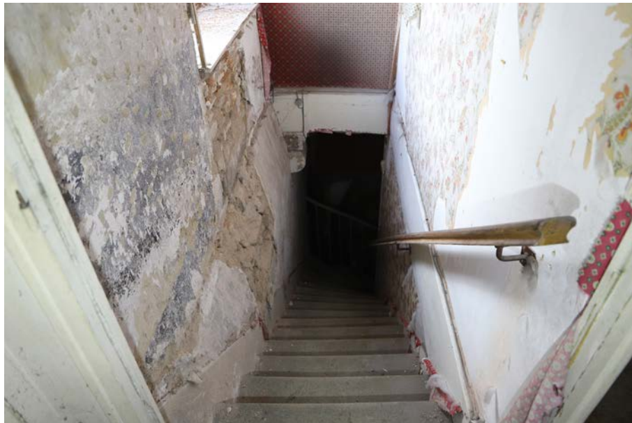
Fig. 25. Différence d'épaisseur entre le rez-de-chaussée et le premier étage pour le mur pignon sud-est (UM 3).
