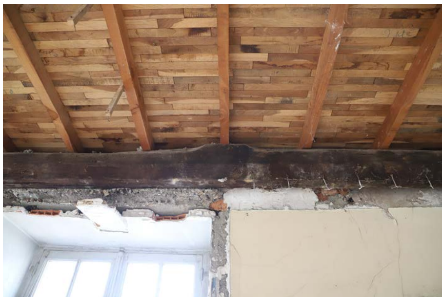
Fig. 17. Entrait de la charpente en remploi comme poutre supportant le plancher de la moitié nord du comble.
