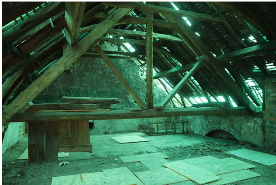
Fig. 29. Vue de la charpente de comble, dans l'espace 9. © Cliché A. Belot
