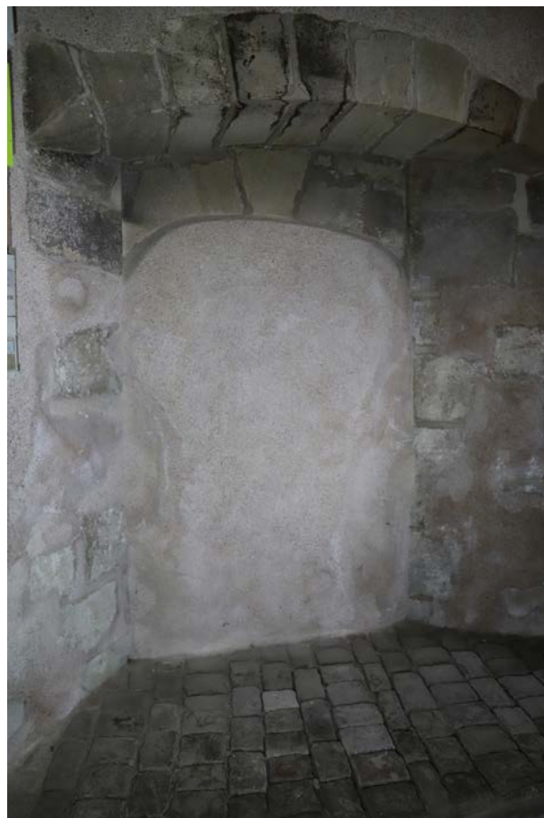
Fig. 33. Porte bouchée au rez-de-chaussée de la tour Marchaux (OUV 17).
