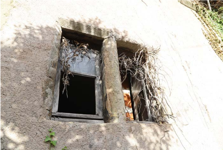
Fig. 14. Vue de la fenêtre OUV 9 depuis l'extérieur. © Cliché A. Belot
