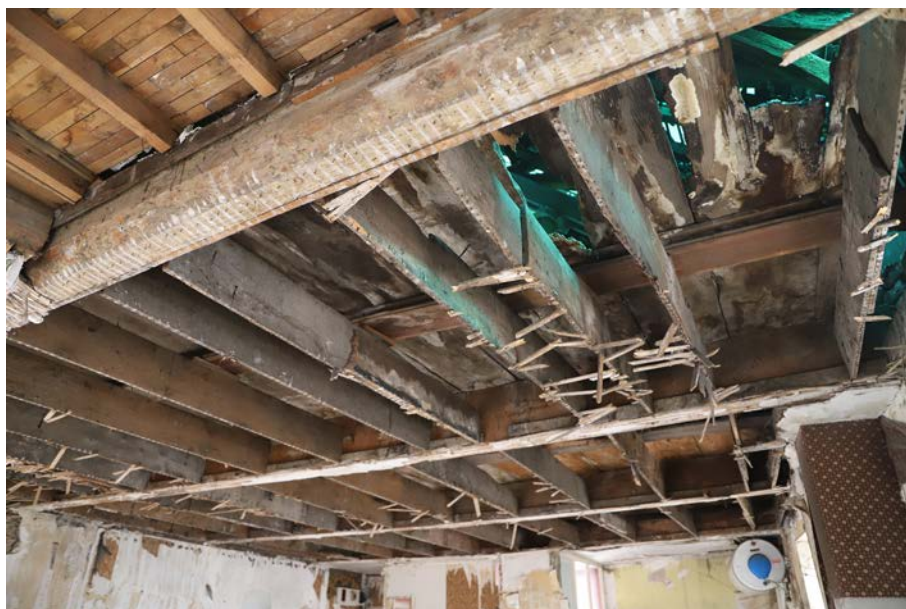
Fig. 18. Vue du plancher de la moitié sud du comble depuis le premier étage .
