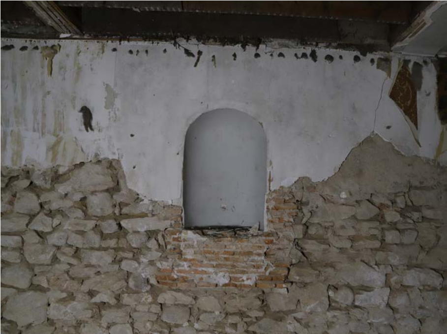
Fig. 40. Niche en briques installée dans l'UM 2 au premier étage. © Cliché A. Belot
