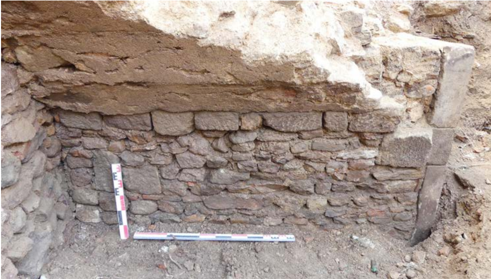
Fig. 70. Mur nord-ouest de la cave (US 3005), sur lequel s'appuie un départ de voûte (US 3006).
