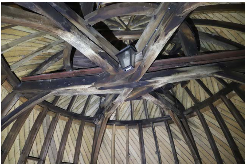
Fig. 47. Charpente de comble de la tour Marchaux.
