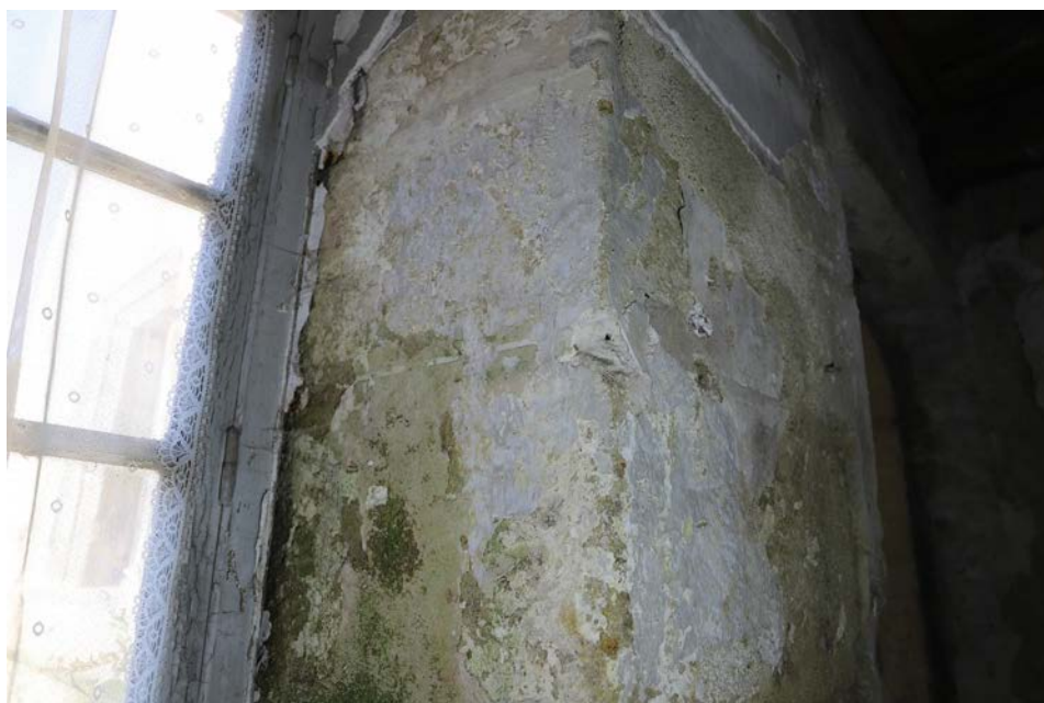
Fig. 21. Décor de faux-joints conservé sur l'un des piédroits de la baie OUV 31.
