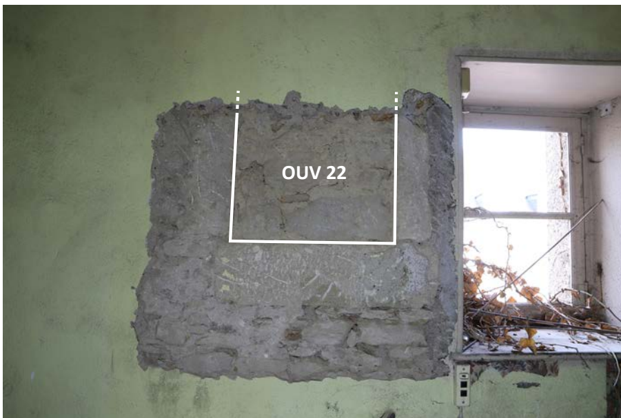
Fig. 38. Fenêtre bouchée OUV 22, mise au jour dans le sondage 18 .
