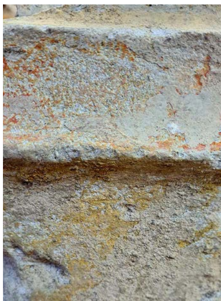
Fig. 32. Vue de détail de la stratigraphie des badigeons sur le bloc 15.
