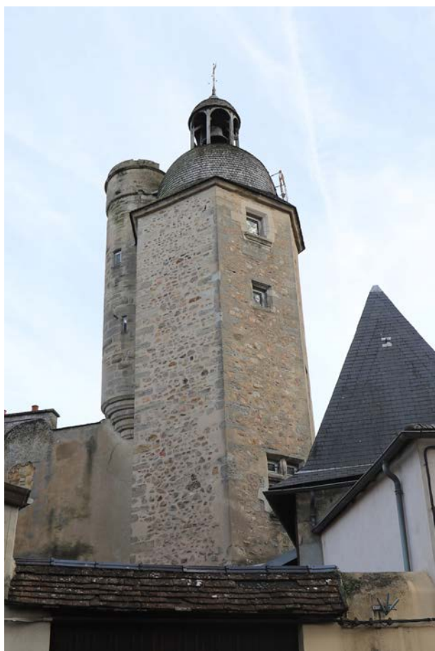
Fig. 30. Vue de la tour Marchaux depuis la Petite rue Marchaux.
