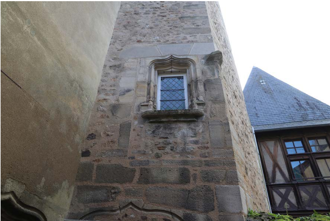
Fig. 56. Vue de la fenêtre OUV 40 depuis l'extérieur.
