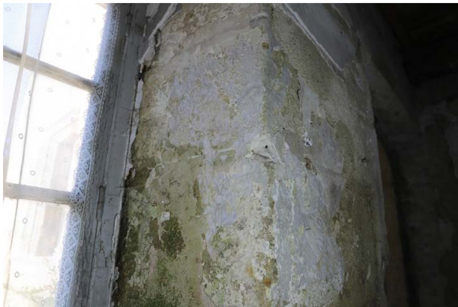
Fig. 32. Vue du décor de faux-joints dans l'ébrasement de la fenêtre OUV 31. © Cliché A. Belot
