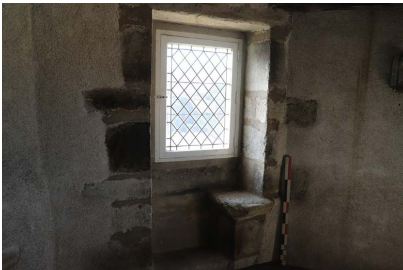
Fig. 46. Baie à coussiège située au deuxième étage de la tour (Ouv 47)
