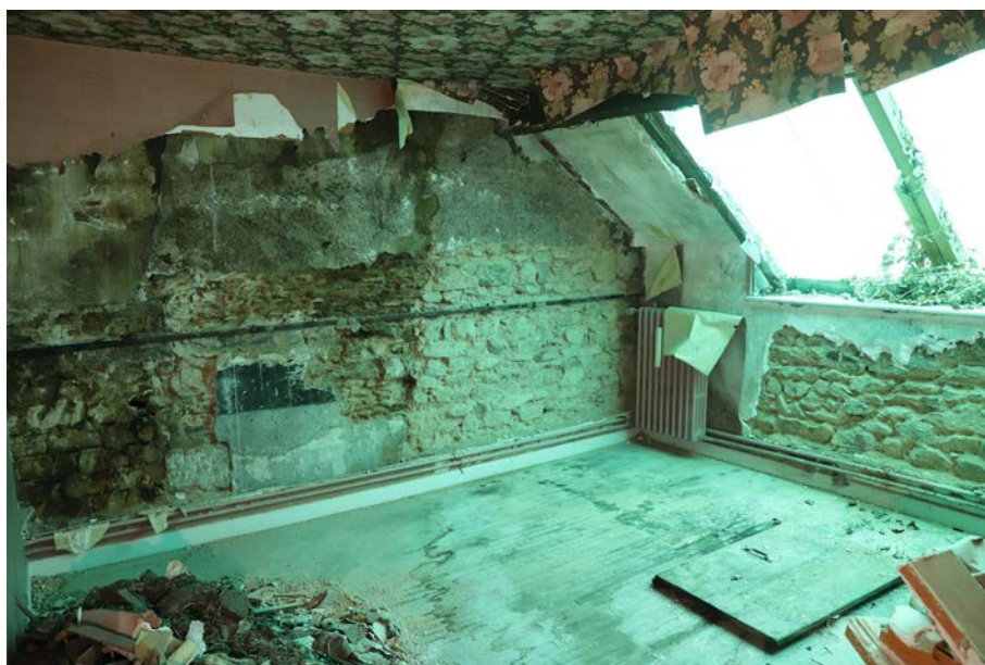
Fig. 28. Vue de l'espace 7. © Cliché A. Belot
