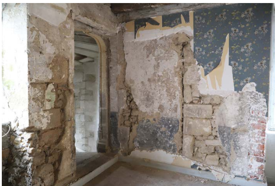
Fig. 23. Ancienne ouverture bouchée (OUV 19), repérée dans le sondage 15, au premier étage du logis.
