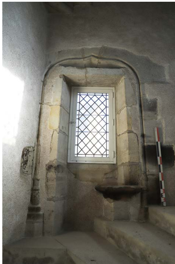
Fig. 38. Ancienne porte transformée en fenêtre dans la tour Marchaux (OUV 40).
