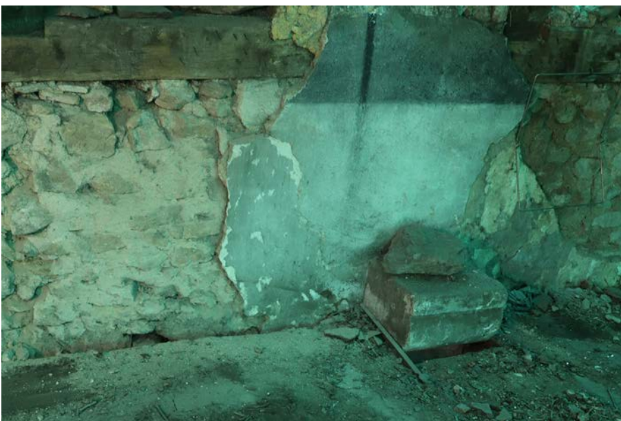
Fig. 95. Corbeau visible dans l'espace 9, au-dessus du plancher actuel du comble. © Cliché A. Belot
