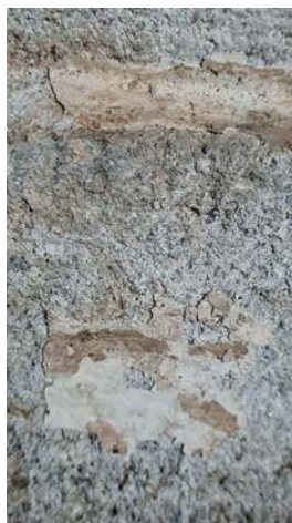
Fig. 11. Vue du lit d'attente du bloc 4, de son profil et de son aménagement en creux afin d'assurer une bonne adhérence du mortier au niveau des joints.
