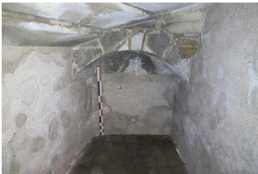
Fig. 36. Espace situé au rez-de-chaussée de la tour, sous l'escalier en vis.
