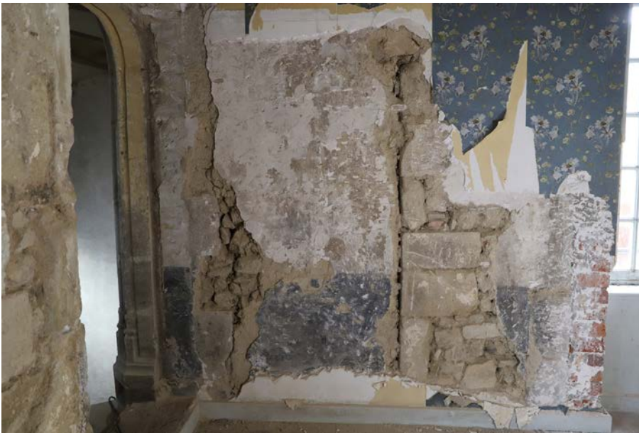
Fig. 37. Enduit gris et noir, observé ici dans le sondage 15.
