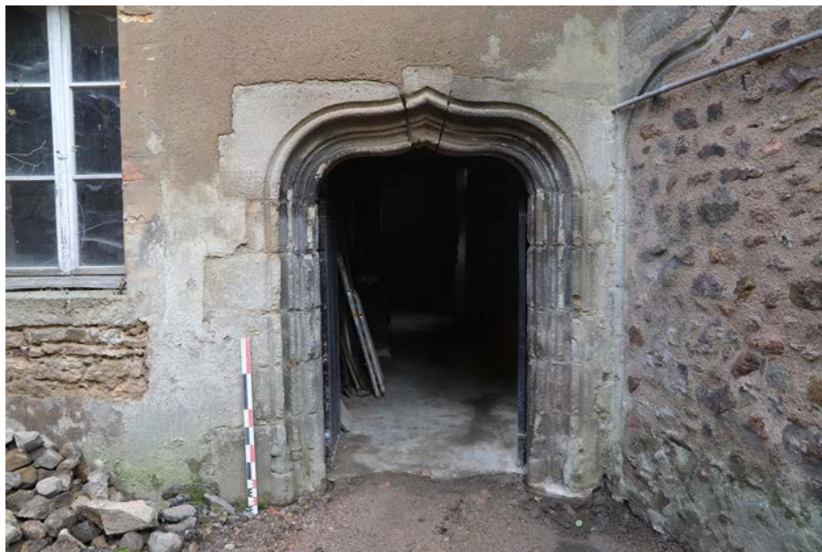
Fig. 4. Vue de la porte OUV 1. © Cliché A. Belot
