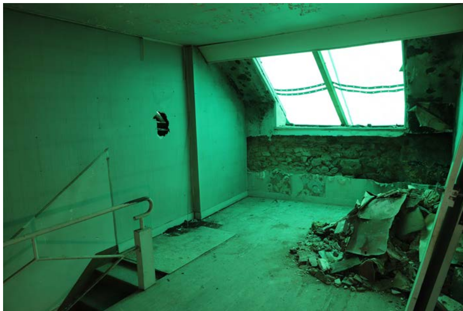
Fig. 26. Vue de l'espace 6. © Cliché A. Belot
