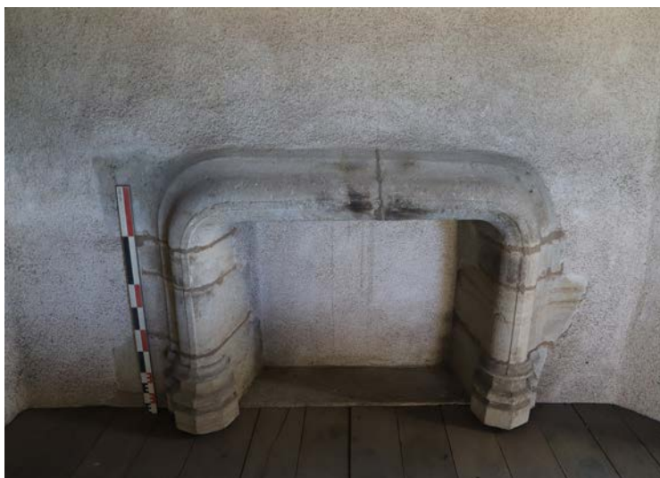
Fig. 45. Cheminée située au deuxième étage de la tour.
