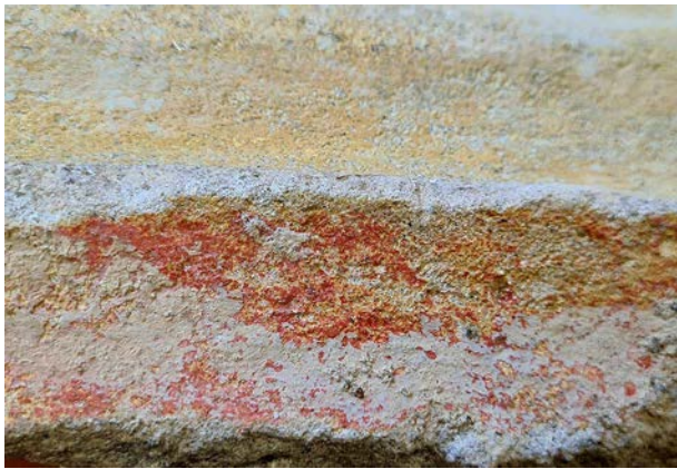
Fig. 28. Vue de détail de la stratigraphie des badigeons sur le bloc 14. © Cliché Y. Labaune
