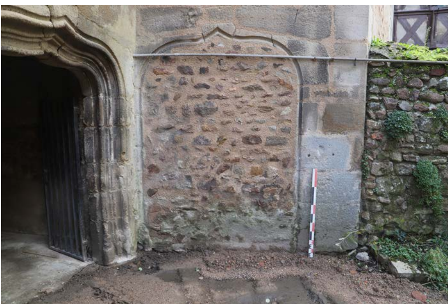
Fig. 23. Vue de la porte bouchée OUV 17.
