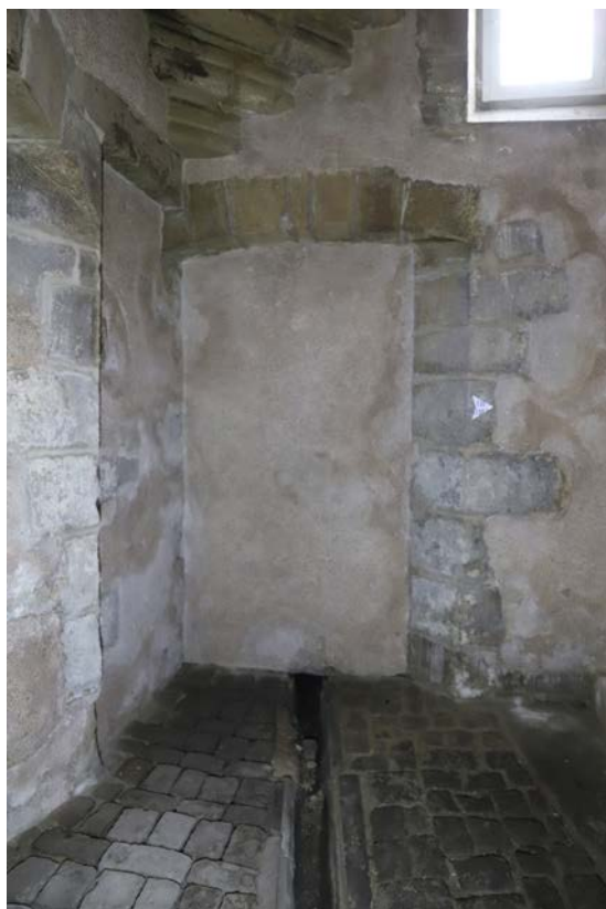
Fig. 34. Porte bouchée au rez-de-chaussée de la tour Marchaux (OUV 18).
