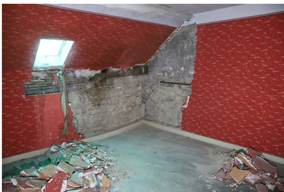
Fig. 27. Vue de l'espace 8. © Cliché A. Belot
