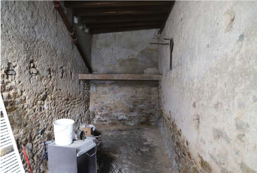
Fig. 25. Vue des deux murs de refends (UM 8 et 9) depuis l'espace 3 .
