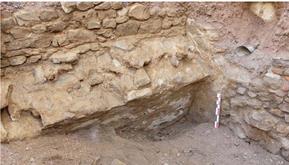
Fig. 71. Mur sud-est de la cave (US 3003), sur lequel s'appuie un départ de voûte (US 3008).
