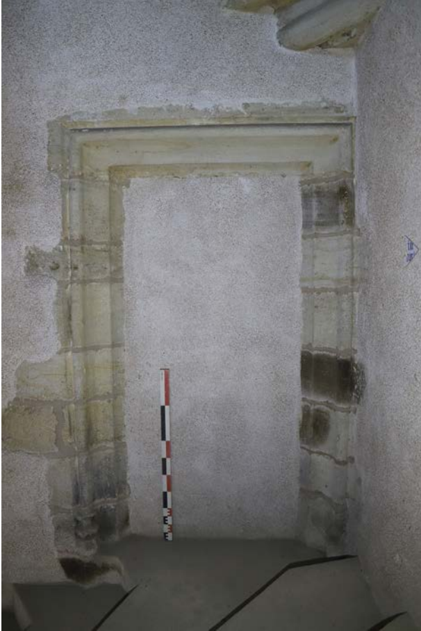
Fig. 94. Porte bouchée dans la tour Marchaux, au niveau du comble du logis (OUV 42). © Cliché A. Belot
