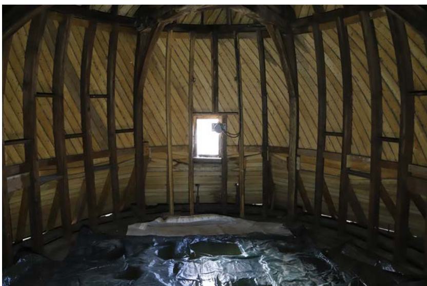
Fig. 48. Lucarne installée sur la toiture de la tour (Ouv 50).
