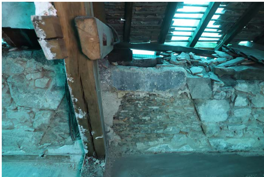
Fig. 46. Photographie des piédroits de la cheminée observés dans le sondage 4.
