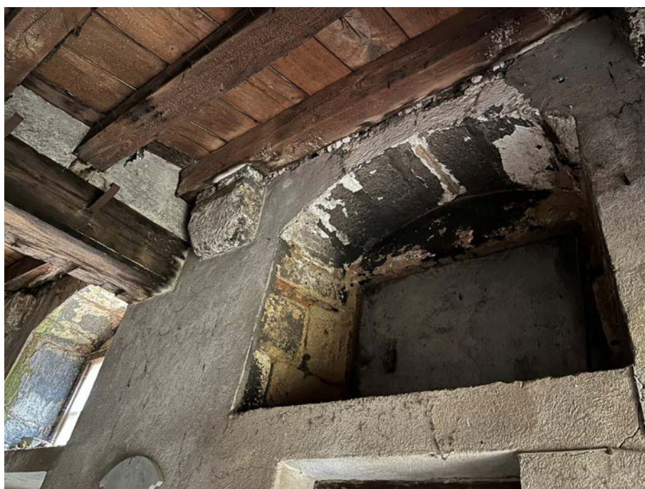
Fig. 13. Vue de la fenêtre bouchée OUV 13 depuis l'espace 1 .
