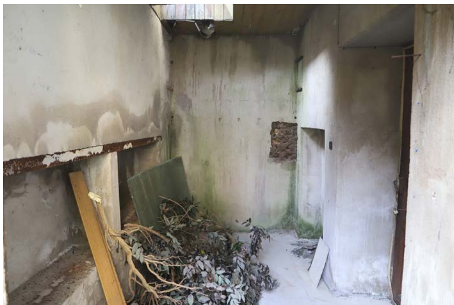
Fig. 10. Vue de l'espace 13. © Cliché A. Belot
