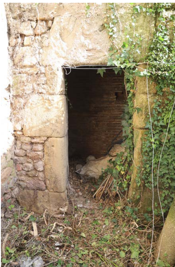
Fig. 12. Porte d'accès (OUV 15) à l'espace 12. © Cliché A. Belot
