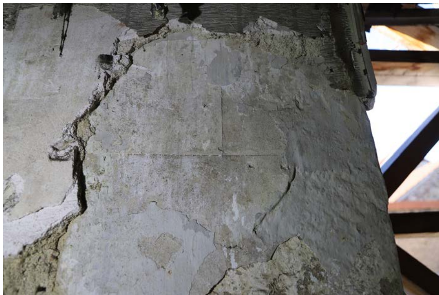
Fig. 22. Décor de faux-joints conservé sur l'un des piédroits de la baie OUV 29.
