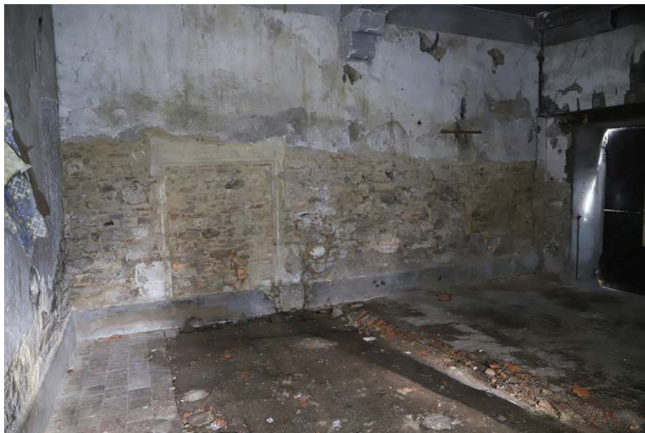
Fig. 7. Vue de l'UM 2 dans l'espace 4, avec la porte OUV 5 repérée lors des piquetages d'enduit.
