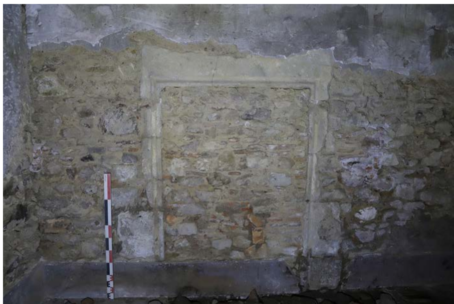
Fig. 9. Vue de la porte OUV 5, repérée dans le sondage 19. © Cliché A. Belot
