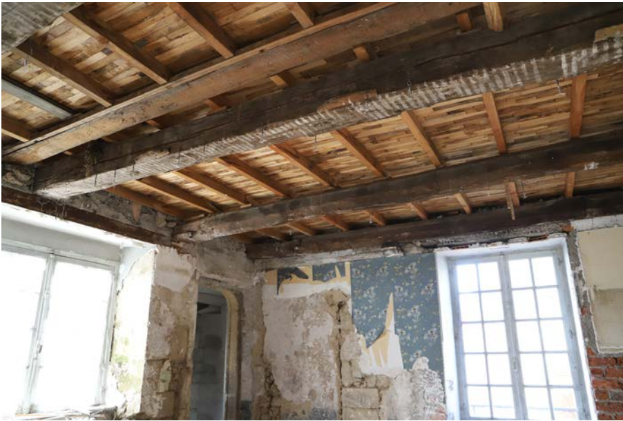
Fig. 52. Vue du plancher de la moitié nord des combles depuis le premier étage.
