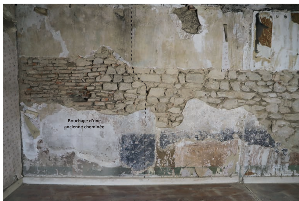
Fig. 36. Photographie annotée montrant l'emplacement d'une ancienne cheminée bouchée sur l'UM 2. © Cliché A. Belot
