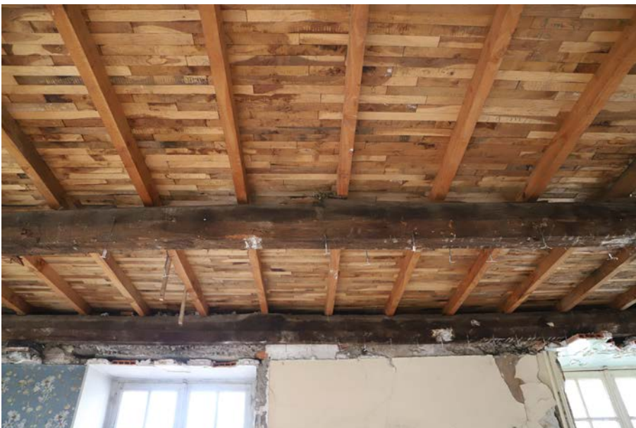
Fig. 53. Entrails de la charpente de comble réemployés dans le plancher.
