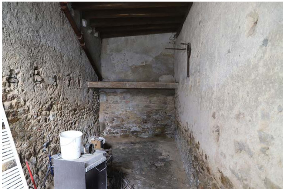
Fig. 6. Vue de l'espace 3, au rez-de-chaussée du logis. © Cliché A. Belot
