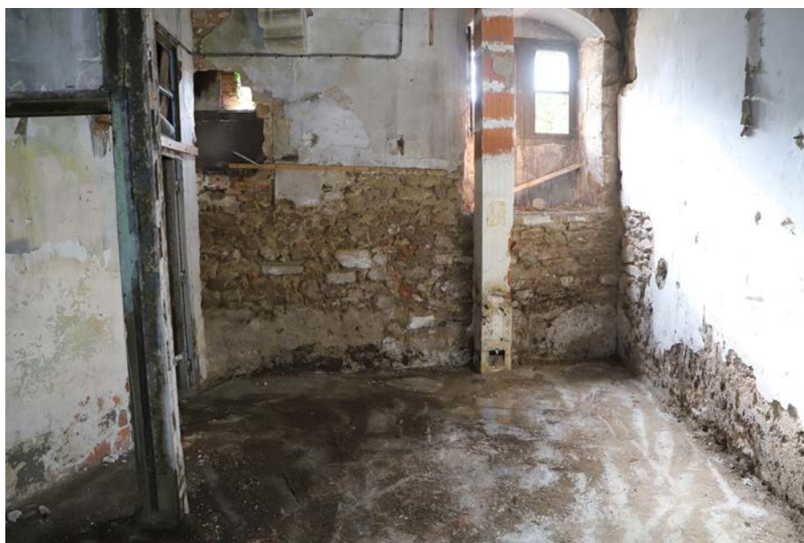
Fig. 8. Vue de l'UM 4 dans l'espace 4, au rez-de-chaussée du logis.
