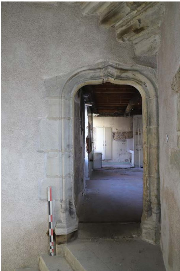
Fig. 86. Porte donnant accès au premier étage du logis depuis la tour (OUV 32).
