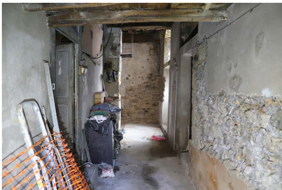
Fig. 3. Vue de l'espace 1, au rez-de-chaussée du logis. © Cliché A. Belot
