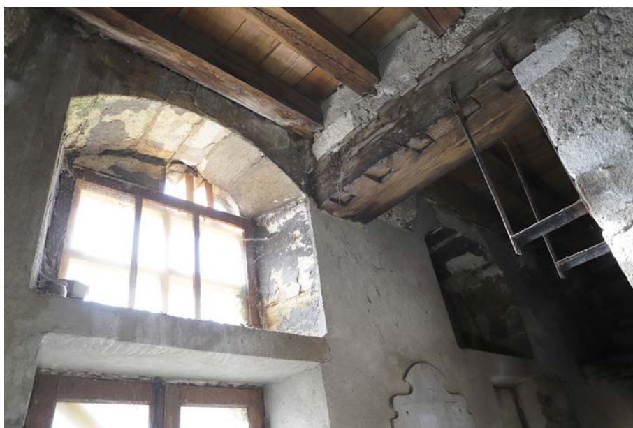
Fig. 12. Vue des fenêtres OUV 11 et OUV 13 depuis l'espace 3.
