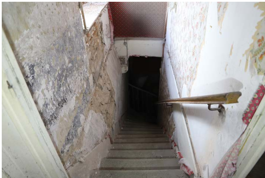
Fig. 16. Vue du changement d'épaisseur de l'UM 3 entre le rez-de-chaussée et le premier étage.
