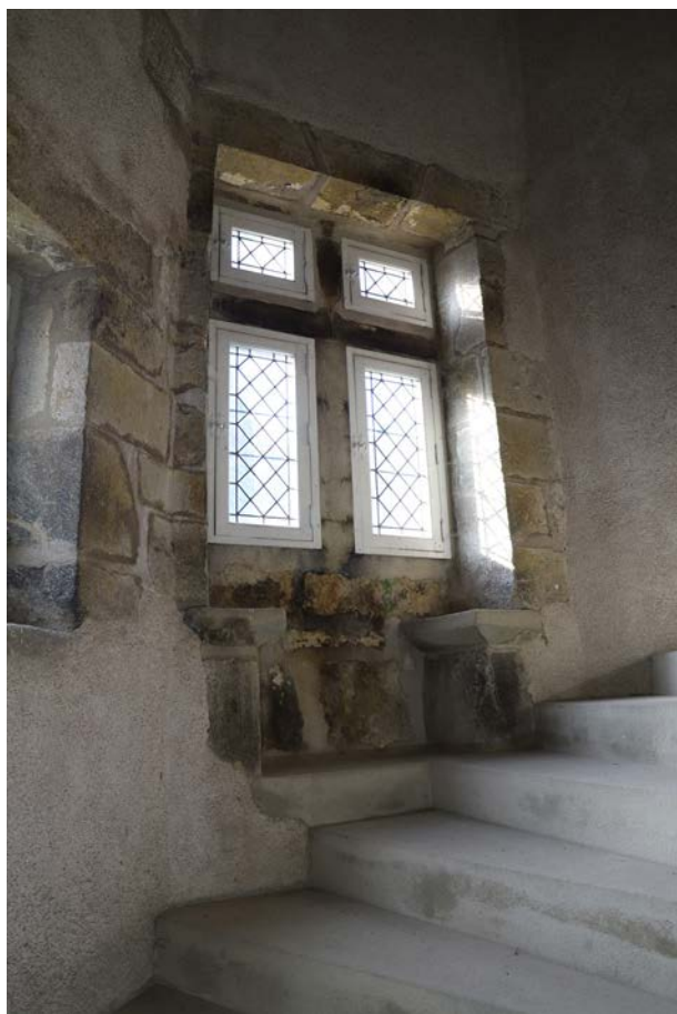
Fig. 37. Grande croisée à coussièges dans la tour Marchaux (OUV 39).
