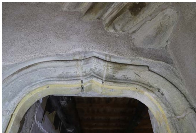
Fig. 20. Détail du linteau en accolade de la porte OUV 32, qui a conservé des traces de polychromie.
