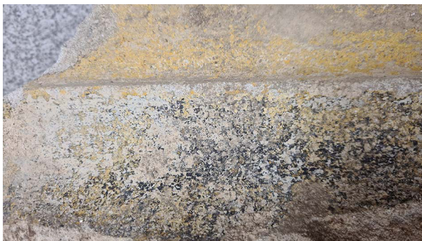
Fig. 36. Vue de détail de la stratigraphie des badigeons sur le bloc 16. © Cliché Y. Labaune
