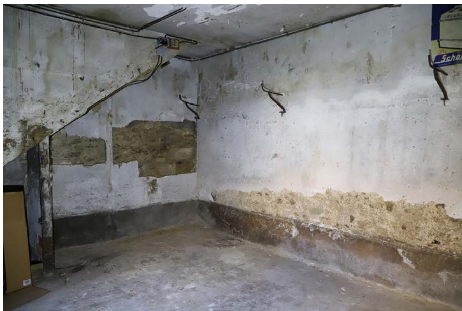
Fig. 5. Vue de l'espace 2, au rez-de-chaussée du logis. © Cliché A. Belot
