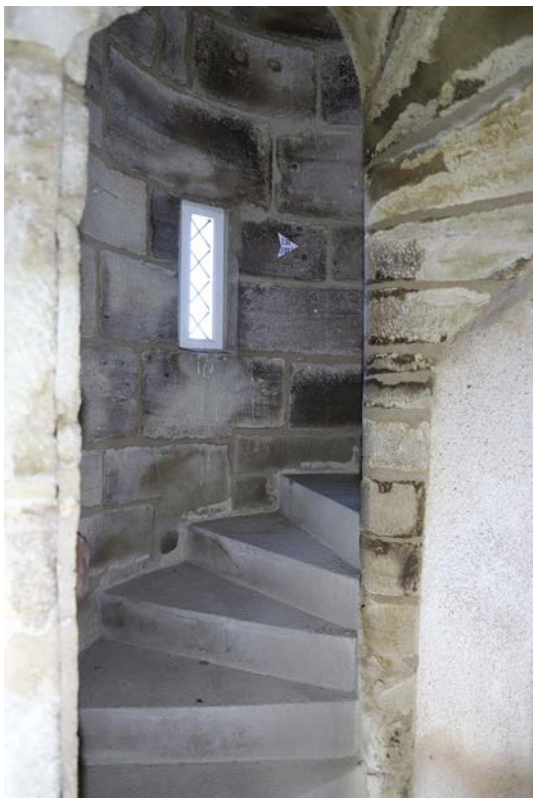
Fig. 42. Escalier en vis installé dans une tourelle en encorbellement, permettant d'accéder au deuxième étage et au niveau de comble de la tour
