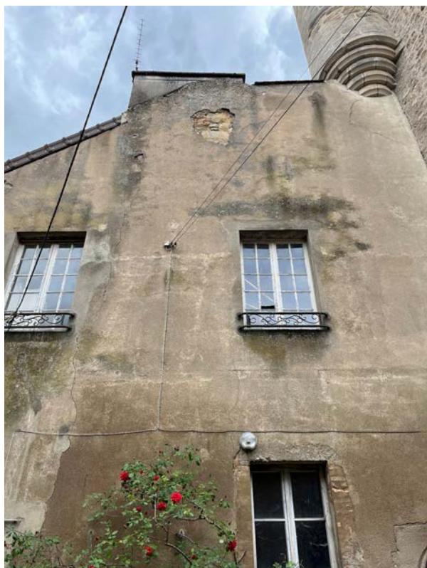
Fig. 2. Vue du mur pignon nord-ouest UM 1 depuis la cour du 30 Petite rue Marchaux . © Cliché A. Capparos
