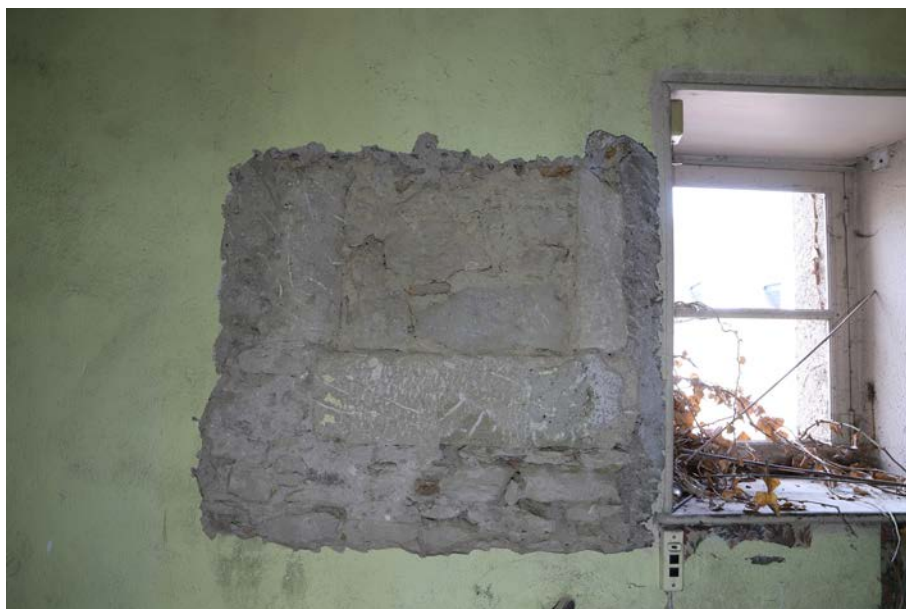
Fig. 24. Ancienne ouverture bouchée (OUV 22), repérée dans le sondage 18, au premier étage du logis.
