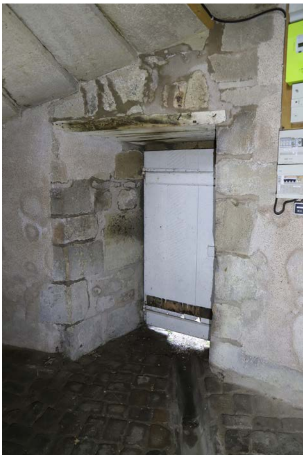
Fig. 32. Porte d'accès au rez-de-chaussée de la tour Marchaux (OUV 16).
