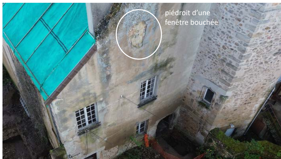
Fig. 50. Vue d'un piédroit d'une ancienne baie bouchée au sommet du mur pignon UM 1.
