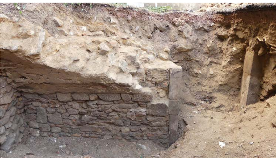
Fig. 72. Piédroits d'une ancienne porte, qui perçait le mur nord-ouest de la cave.
