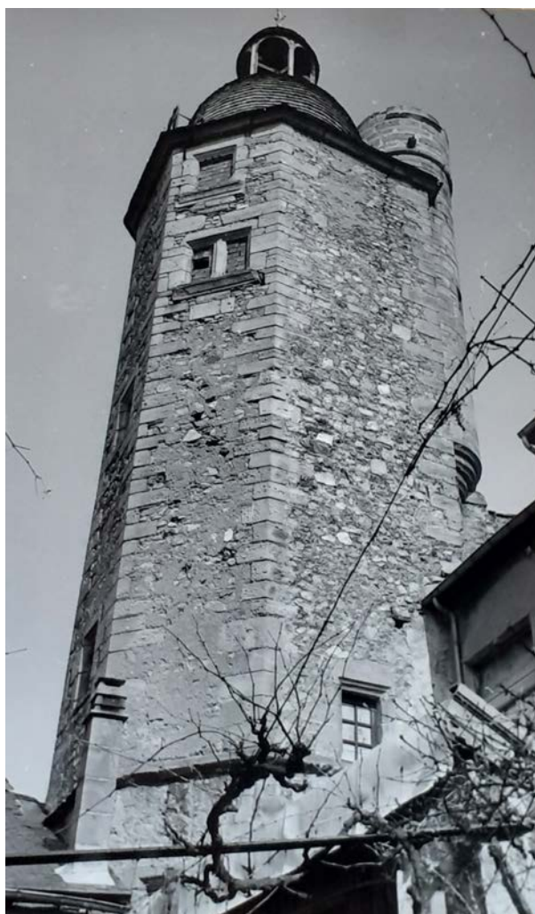
Fig. 113. Photographie de la tour Marchaux conservée à la Médiathèque du Patrimoine et de la Photographie à Charenton-le-Pont (J/84/71/3002).
