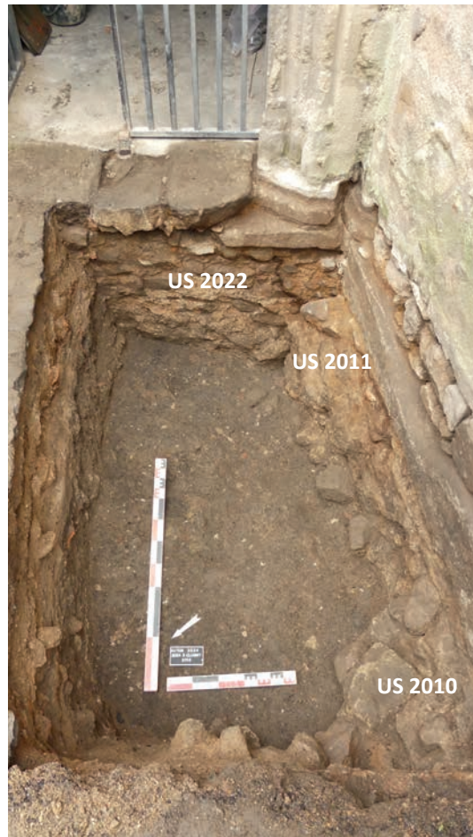
Fig. 65. Massif de fondation (US 2022) du logis de l'hôtel de Clugny . © Cliché A. Belot
