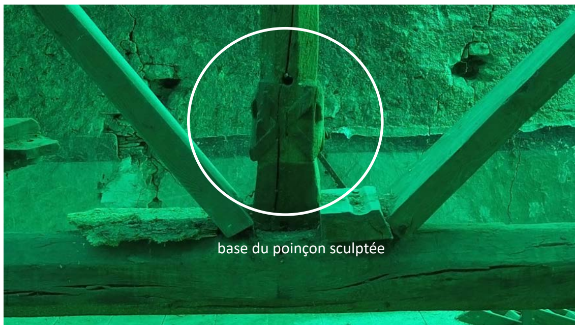
Fig. 43. Base du poinçon de la ferme principale de la charpente, sculptée en forme de croix de saint André .
