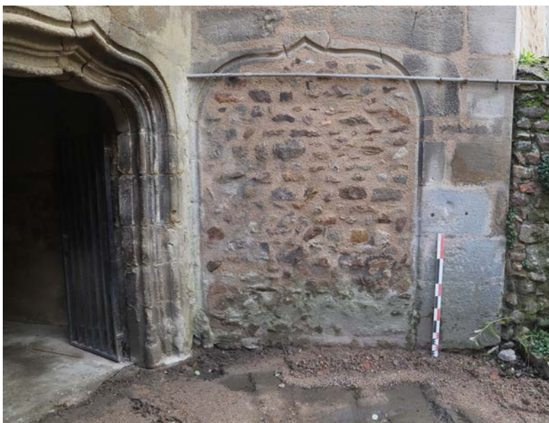
Fig. 35. Vue de la porte bouchée OUV 17 depuis la cour du 30 Petite rue Marchaux.
