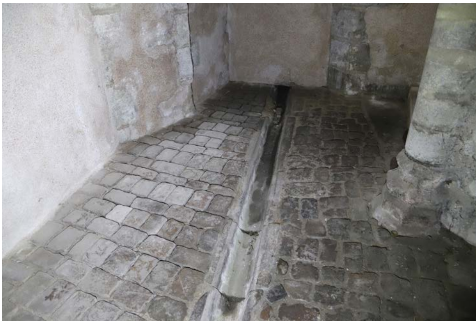
Fig. 31. Sol pavé muni d'une rigole, au rez-de-chaussée de la tour Marchaux.
