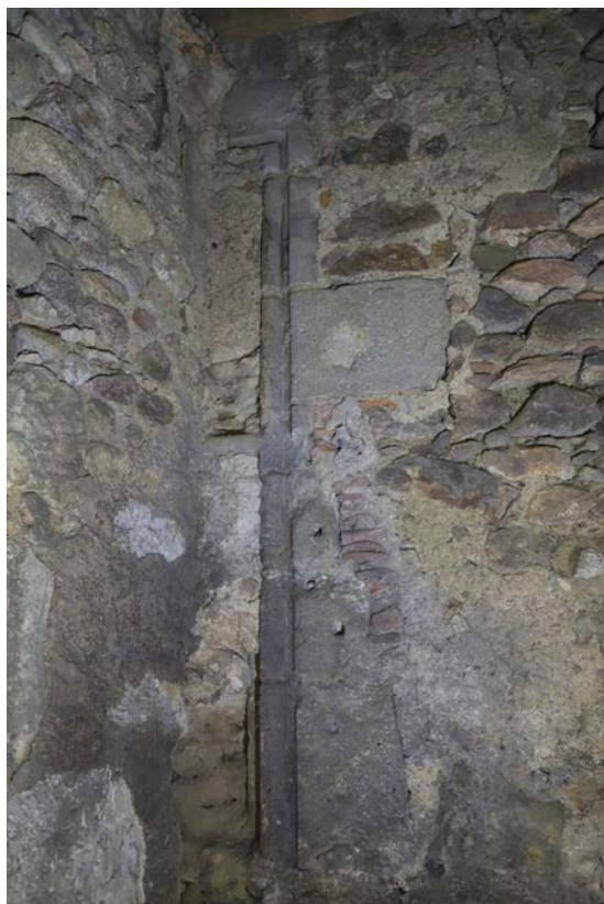
Fig. 20. Vue de la fenêtre bouchée OUV 8 depuis l'espace 12.
