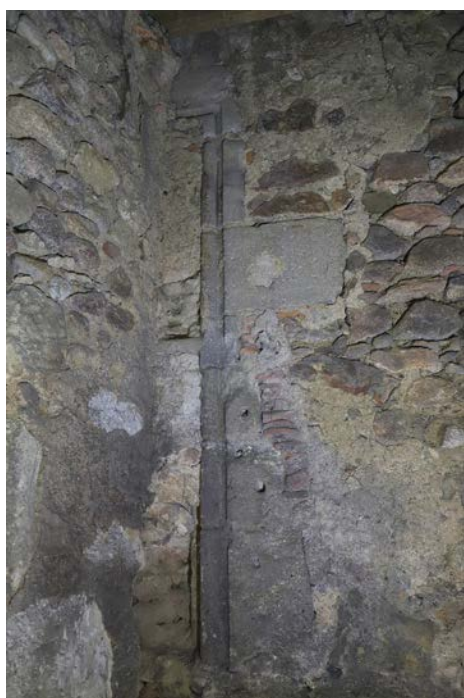
Fig. 13. Vue de la fenêtre bouchée OUV 8 depuis l'espace 12.
