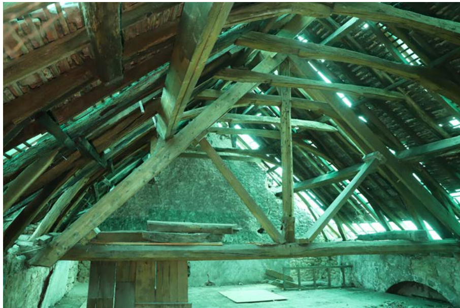
Fig. 42. Charpente de comble du logis. (La teinte verte des photographies prises dans les combles provient de la bache installée sur le toit) © Cliché A. Belot
