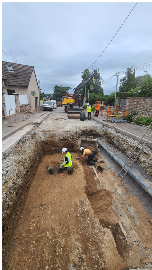
Fig. 4. Nettoyage du sol de cailloutis sur lequel les travaux de terrassement se sont arrêtés.
