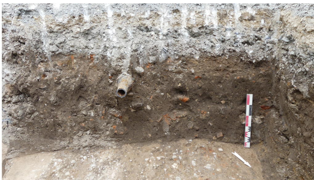
Fig. 17. Détail montrant le léger bombement de la chaussée 01. Cliché A. Belot.
