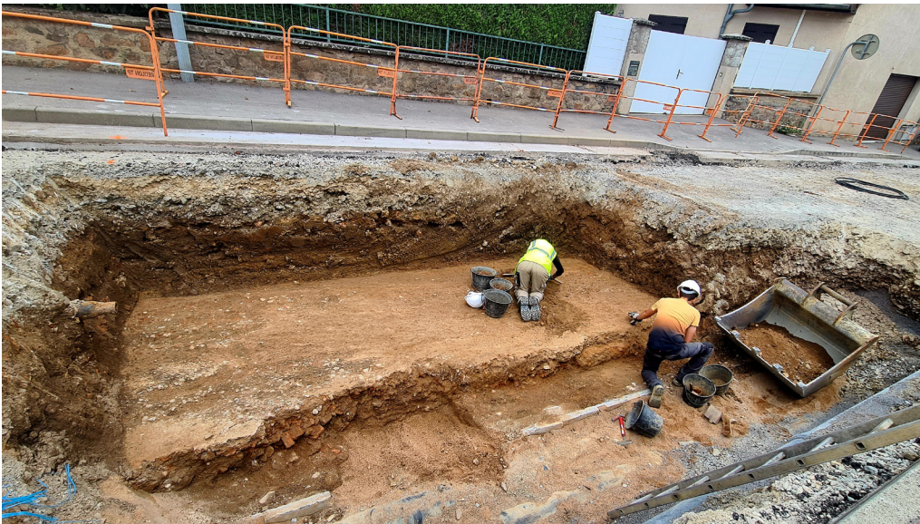
Fig. 18. Vue générale de la chaussée 01, qui suit parfaitement le pendage de la chaussée actuelle.
