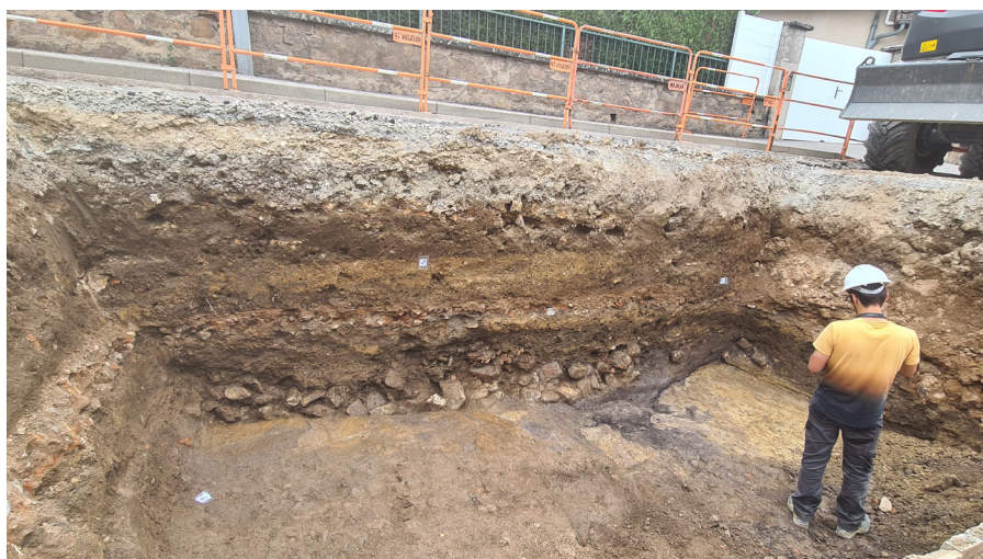
Fig. 5. Terrassement mené jusqu'au fond de fouille souhaité : acquisition photogrammétrique après nettoyage en plan et nettoyage des trois coupes stratigraphiques pertinentes.
