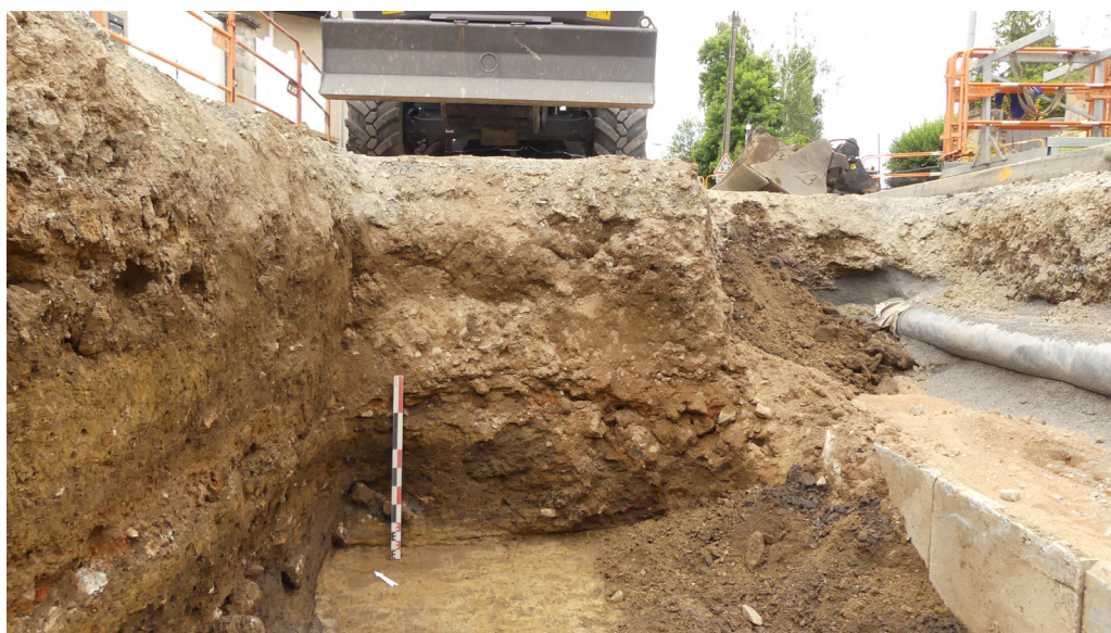
Fig. 13. Apparition du toit du substrat argileux jaune au fond de la tranchée. Cliché Y. Labaune.
