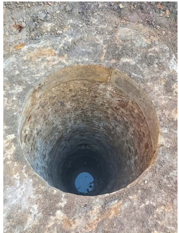
Fig. 38. Photographie du puits dégagé au moment du rebouchage des tranchées.
