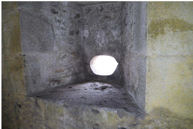
Fig. 73. Vue de l'ébrasement intérieur de la canonnière CAN 2.
