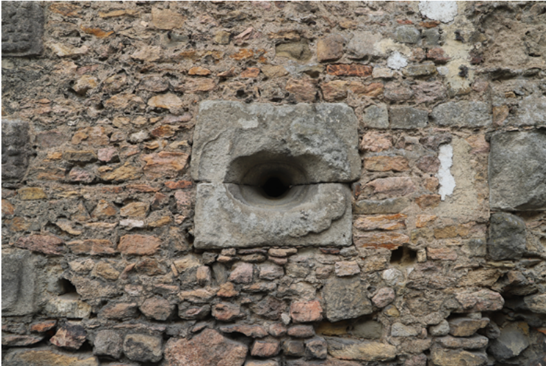
Fig. 29. Vue de la canonnière CAN 1 sur le parement extérieur de l'UM 1. © Cliché A. Belot
