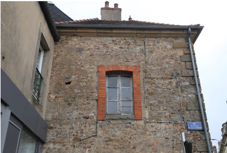
Fig. 20. Vue de la fenêtre OUV 6 sur l'UM 2.
