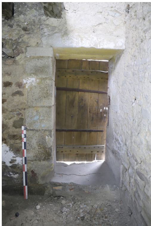
Fig. 50. Vue de la porte OUV 7 depuis l'intérieur. © Cliché A. Belot
