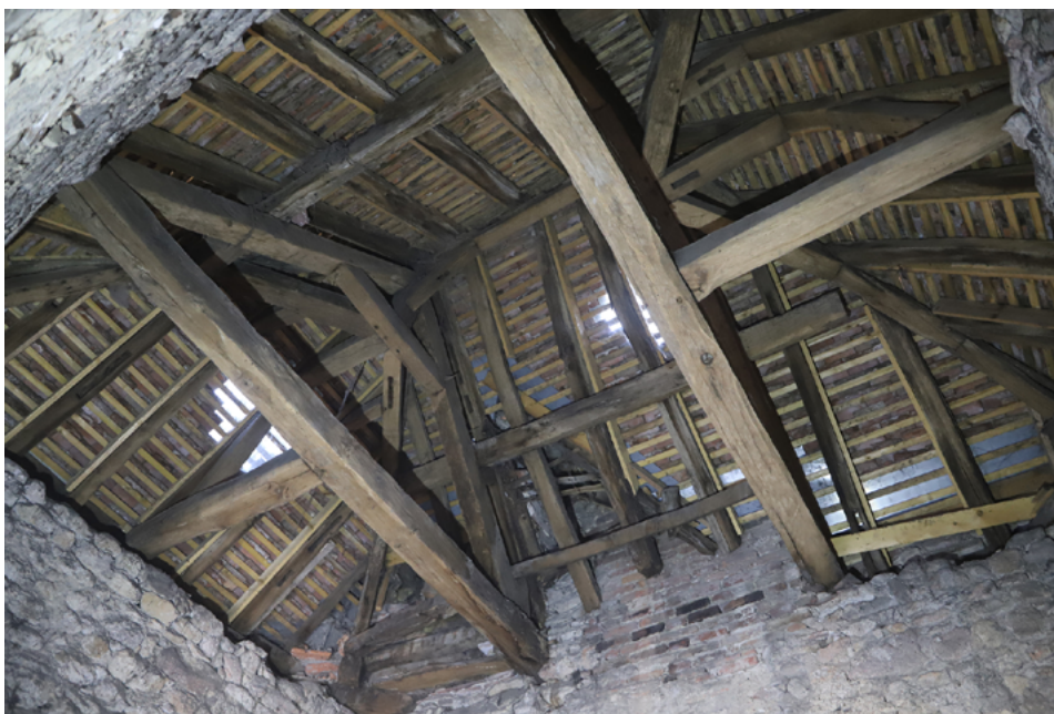
Fig. 38. Vue de la charpente de comble du pavillon nord-est.
