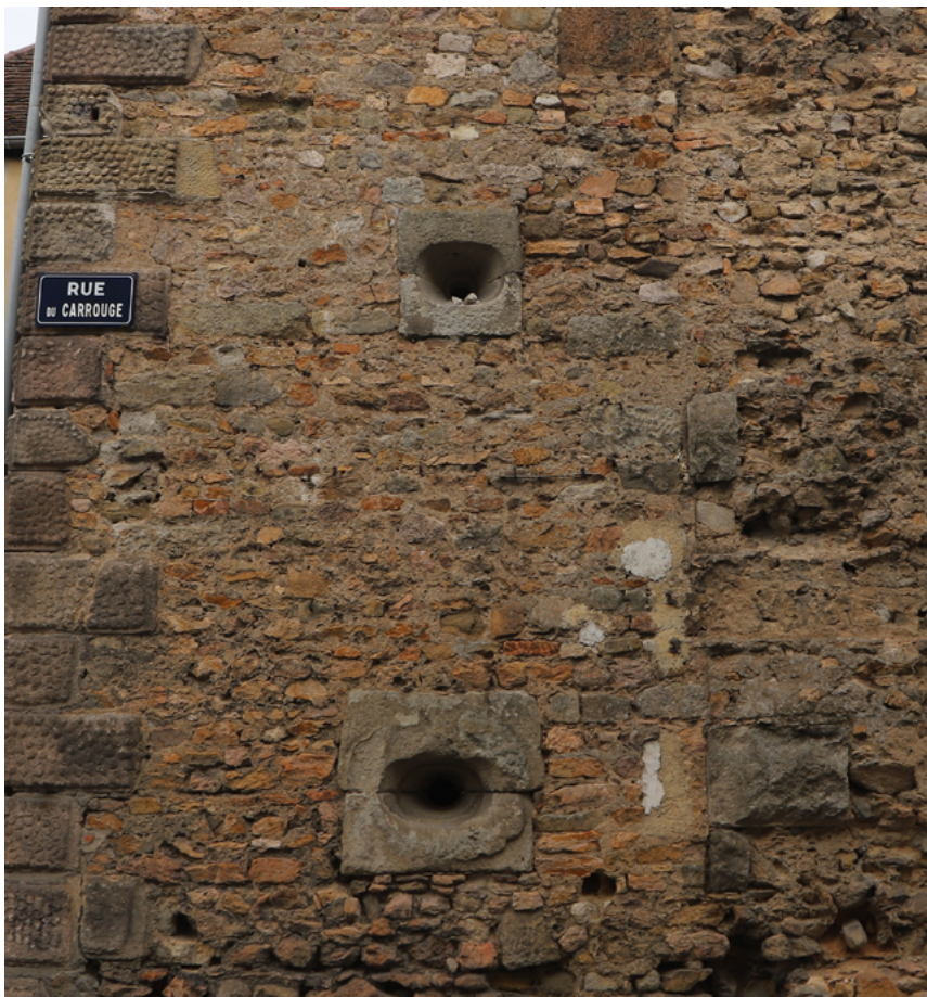
Fig. 11. Vue des deux canonnières (CAN 1 et CAN 4) de l'UM 1 depuis l'extérieur. © Cliché A. Belot
