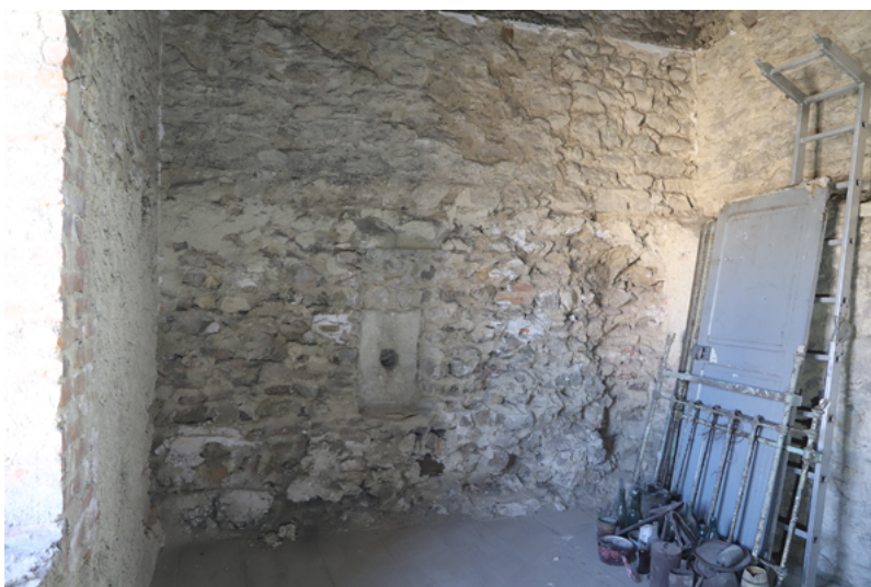
Fig. 37. Vue de la partie est du premier étage du pavillon (ESP 2).
