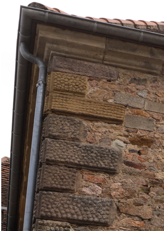
Fig. 18. Blocs de nature différente sur les dernières assises de la chaîne d'angle à bossages.
