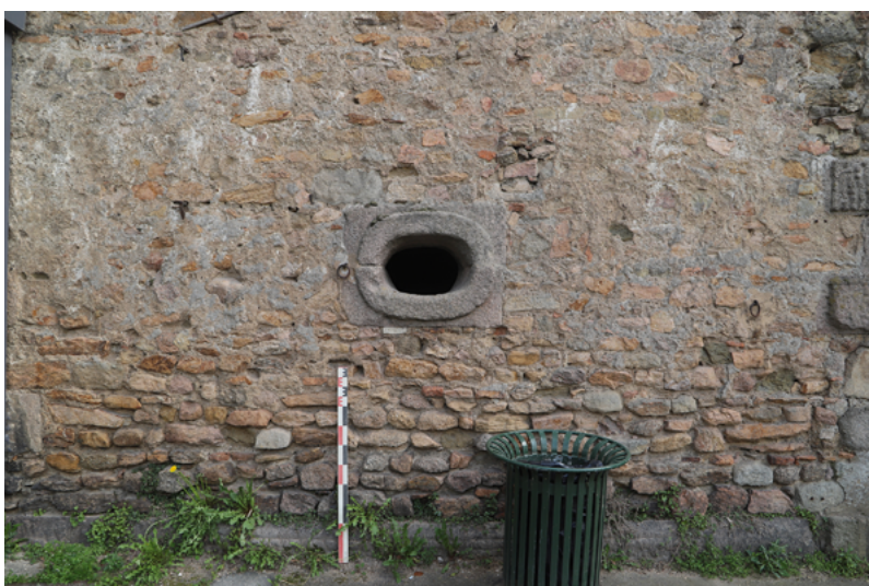
Fig. 32. Vue de la canonnière CAN 2 sur le parement extérieur de l'UM .
