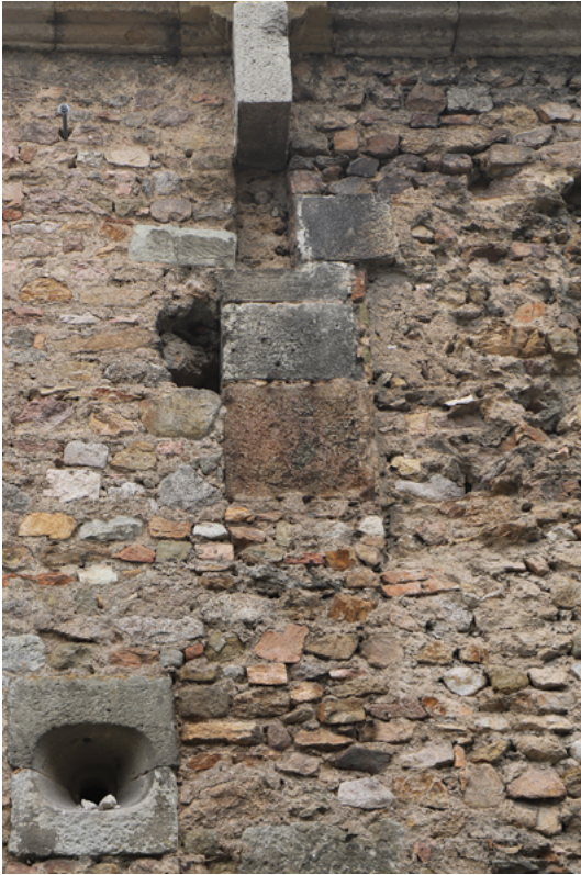
Fig. 15. Blocs de pierre de taille visibles en partie haute de l'UM 1.
