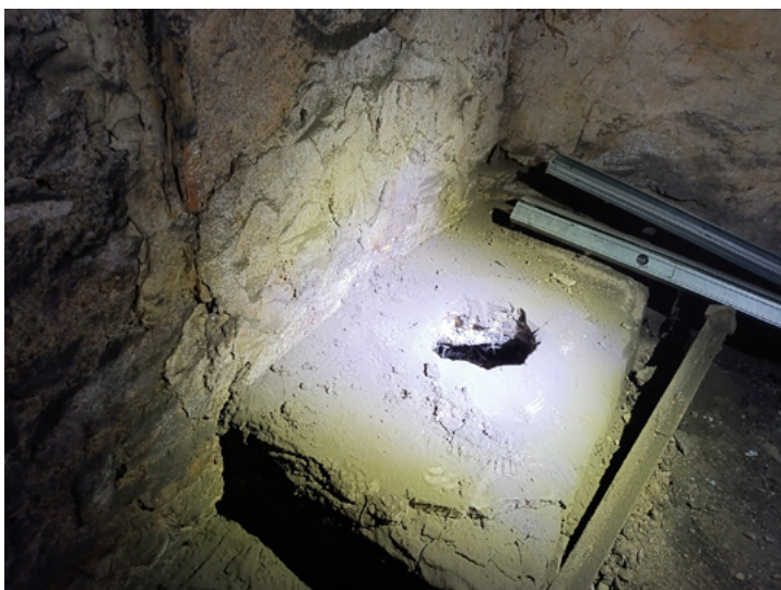
Fig. 25. Vue de l'aménagement qui bouchait la cavité CAV 8, avant son démontage au cours des travaux. © Cliché A. Belot
