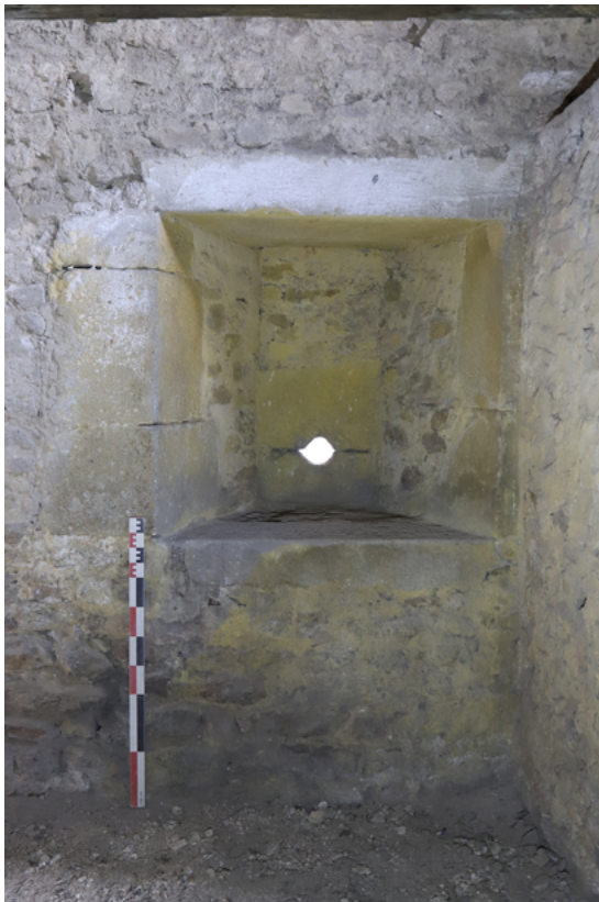
Fig. 27. Vue de la canonnière CAN 1 depuis l'intérieur. © Cliché A. Belot
