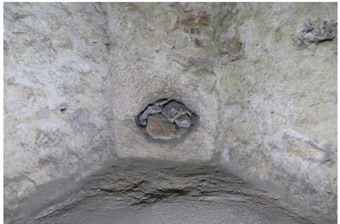
Fig. 35. Bouchage de l'orifice de tir de la canonnière CAN 3.
