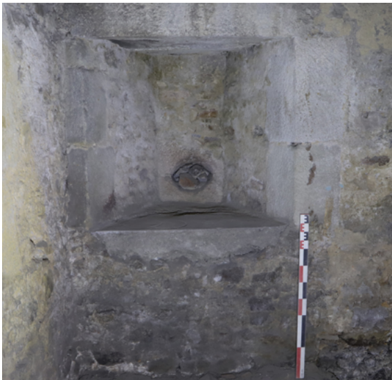
Fig. 34. Vue de la canonnière CAN 3 depuis l'intérieur.
