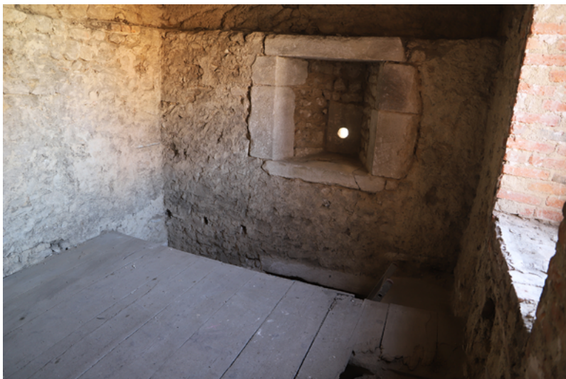
Fig. 36. Vue de la trémie du plancher depuis le premier étage (ESP 2).
