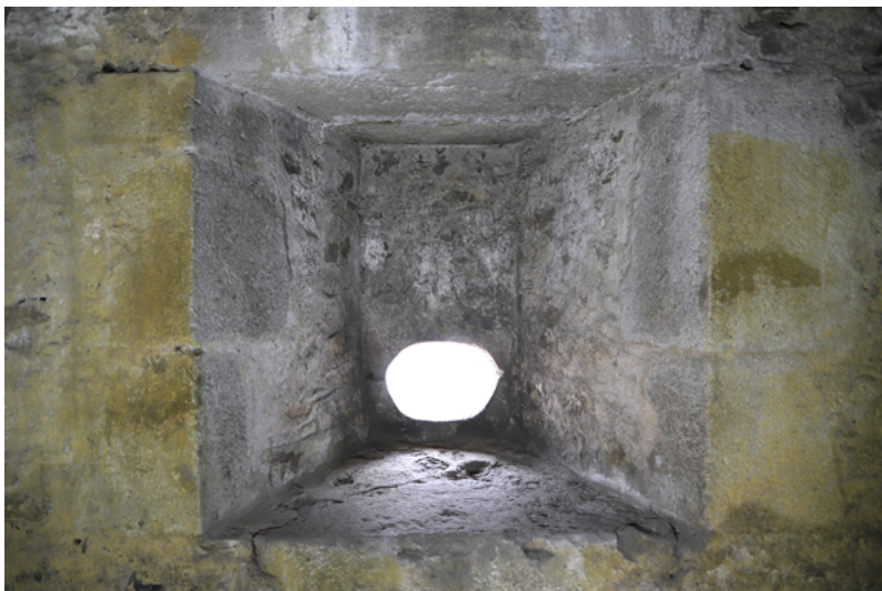
Fig. 31. Vue de la canonnière CAN 2 depuis l'intérieur.
