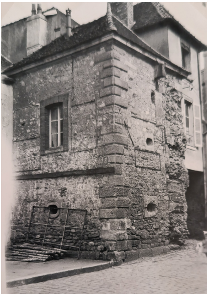
Fig. 75. « Restes d'un des avant-corps de l'ancienne porte du Carrouge XVI e s. (état en mars 1947) ».
