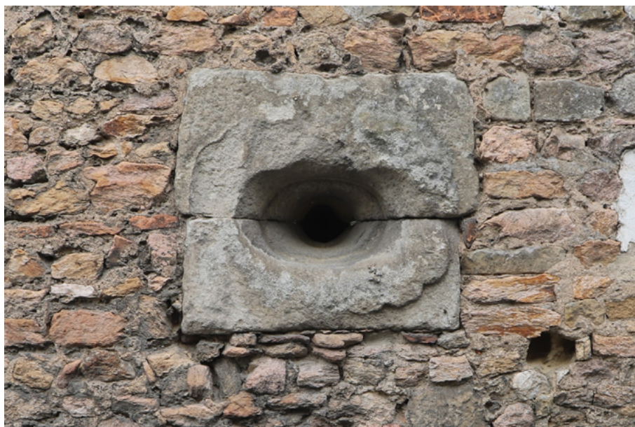
Fig. 51. Vue de l'évasement en façade de la canonnière CAN 1. © Cliché A. Belot
