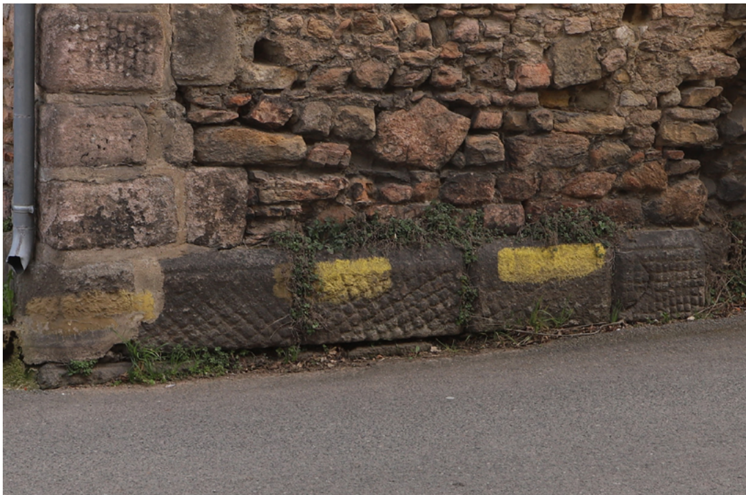
Fig. 12. Vue de l'assise de soubassement de l'UM 1. © Cliché A. Belot
