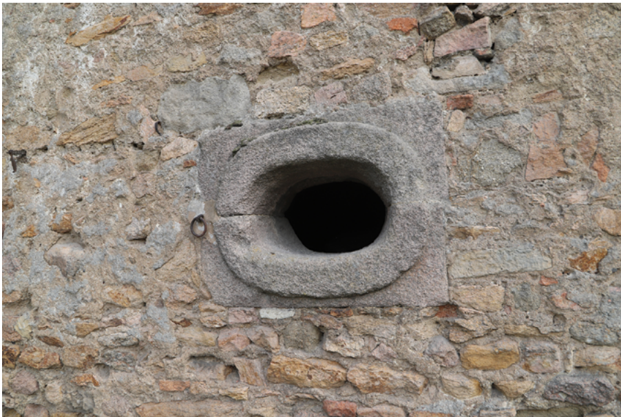
Fig. 52. Vue de la canonnière CAN 2 depuis l'extérieur.
