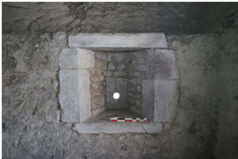
Fig. 40. Vue de la canonnière CAN 4 depuis l'intérieur. © Cliché A. Belot
