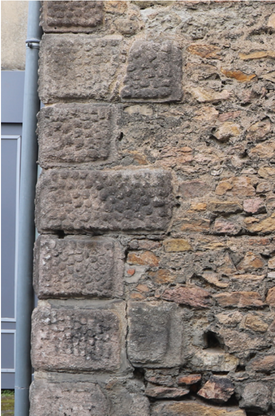
Fig. 13. Vue de la chaîne d'angle à bossages des UM 1 et 2. © Cliché A. Belot
