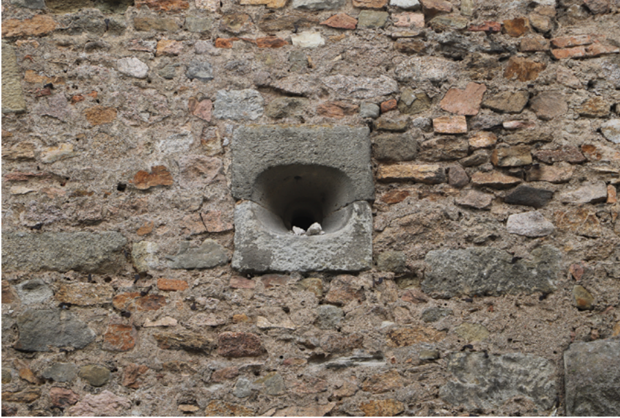
Fig. 55. Vue de l'évasement en façade de la canonnière CAN 4. © Cliché A. Belot
