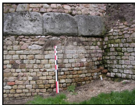
Figure 28 : Base de la tour T15 et du tronçon C22 à Autun.
