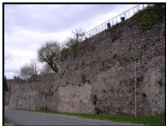
Photographie 100 : tronçon C26 (mire 5 m)
