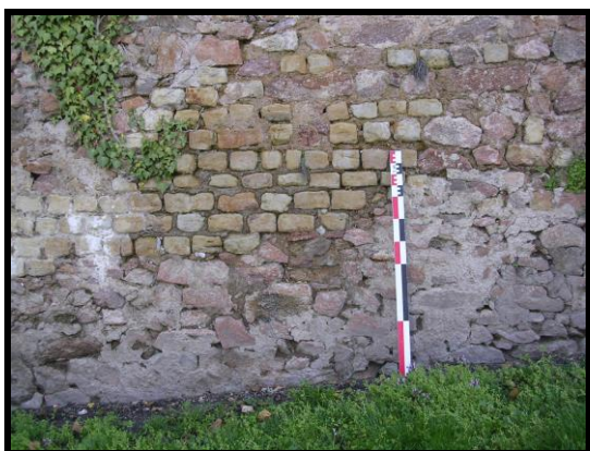
Photographie 111 : tronçon C28, détail des moellons du parement (mire 1 m)
