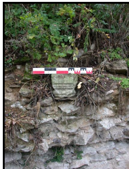
Photographie 8 : tronçon C4, détail de la colonnette prise dans la maçonnerie (mire 0,50 m)
