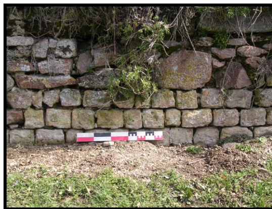
Photographie 70 : tronçon C20, détail des moellons du parement (mire 0,50 m)
