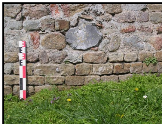
Photographie 88 : tour T16, détail des moellons du parement à la base de la face sud (mire 0,50 m)
