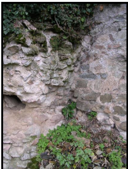
Photographie 144 : tour T26, face nord-est, jonction avec le tronçon C38
