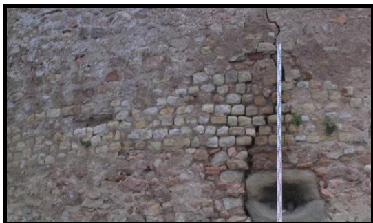
Photographie 107 : tour T19, détail des moellons du parement sur la face ouest (mire 5 m)
