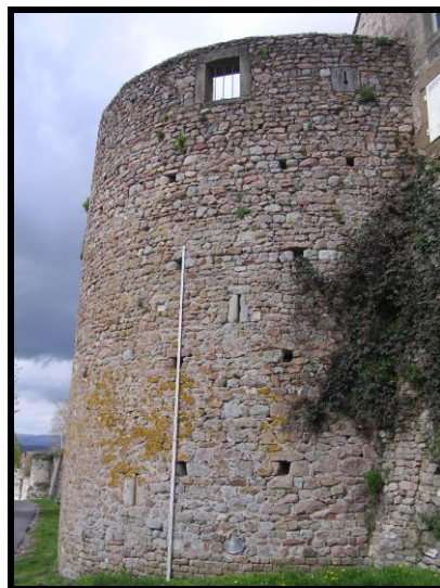
Photographie 86 : tour T16, face sud (mire 5 m)
