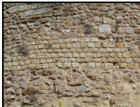
Photographie 68 : tour T12, détail des moellons du parement sur la face sud
