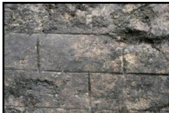
Photographie 128 : trçon C32, face interne de la courtine dans le sondage 108, détail de l'enduit recouvrant les moellons, lissé puis jointoyé au fer pour imiter le petit appareil (Fouille du Nouvel hôpital, cliché : Afan)
