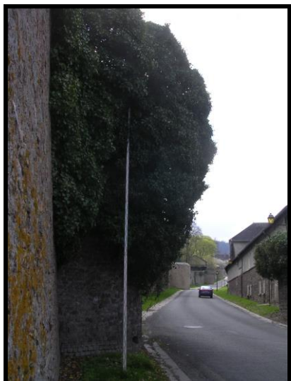
Photographie 121 : tour T22, face nord (mire 5 m)
