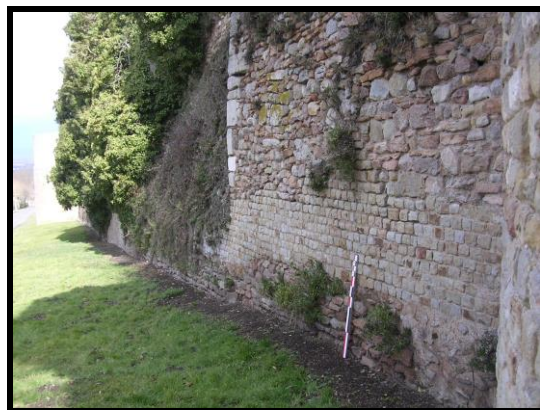
Photographie 74 : tronçon C21, une plaque de moellons du parement est conservée (partie claire au-dessus de la mire, mire 1 m)
