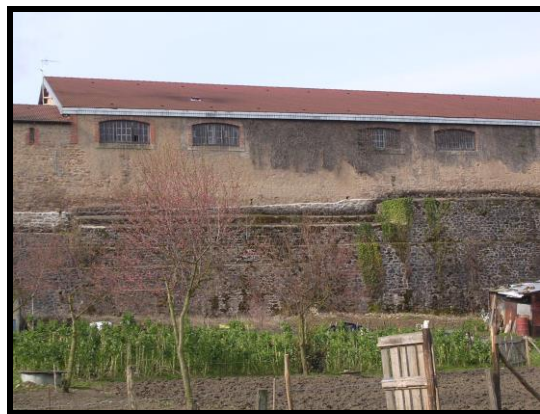
Photographie 151 : tronçon C41, partie sud-est
