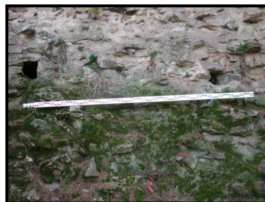
Photographie 6 : tronçon C3, détail des trous de boulin (mire 2 m)
