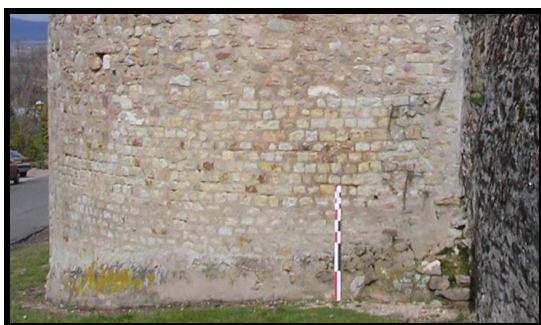
Photographie 77 : tour T14, face sud, détail des moellons du parement (mire 1 m)
