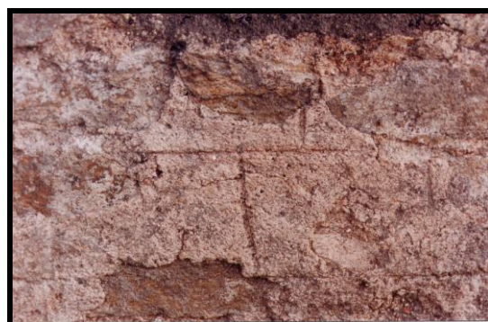
Photographie 34 : tronçon C10, détail du parement interne : les moellons sont entièrement recouverts d'un enduit de tuileau, lissé puis jointoyé au fer pour imiter le petit appareil (cliché : service archéologique de la Ville d'Autun)
