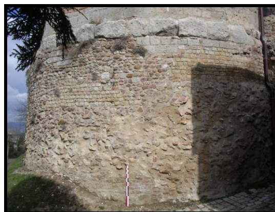
Photographie 66 : tour T12, base de la face est (mire 1 m)
