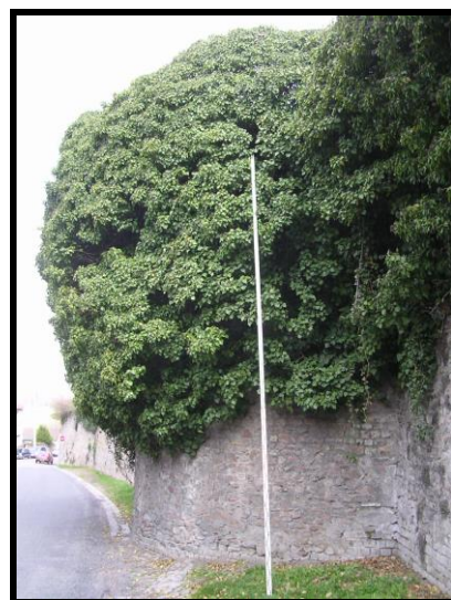
Photographie 120 : tour T22, face sud (mire 5 m)
