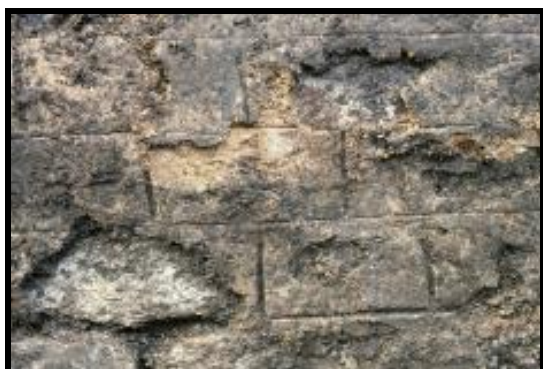
Photographie 129 : trçon C32, face interne de la courtine dans le sondage 108, détail de l'enduit recouvrant les moellons portant des traces de réfection (Fouille du Nouvel hôpital, cliché : Afan)
