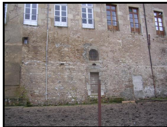
Photographie 58 : tronçon C17 : le couvent des Bénédictines est construit à l'aplomb de l'enceinte
