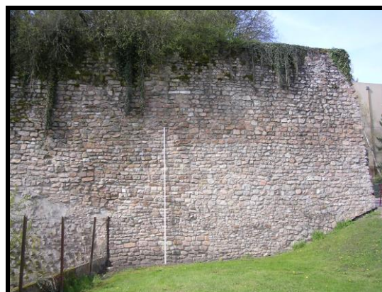
Photographie 161 : tronçon C46 (mire 5 m)
