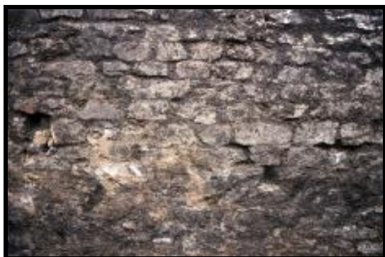
Photographie 127 : trçon C32, face interne de la courtine dans le sondage 107, détail des moellons du parement interne et des trous de boulins (Fouille du Nouvel hôpital, cliché : Afan)
