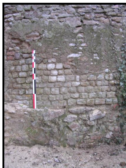
Photographie 42 : tour T6, moellons du parement (mire 1 m)
