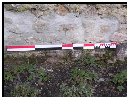
Photographie 64 : tronçon C19, détail de la rangée de moellons conservée à la base du mur (visible sous la mire) chez M. et Mme Ménager (mire 1 m)
