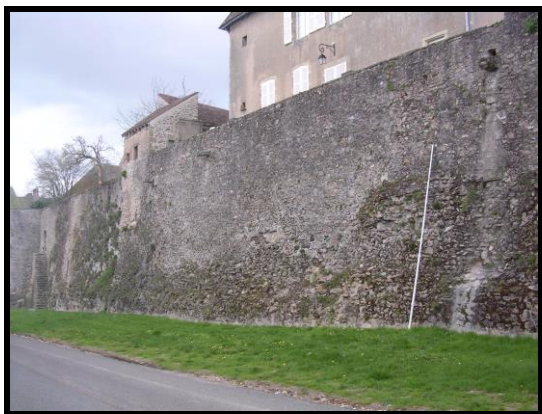
Photographie 89 : tronçon C24 (mire 5 m)
