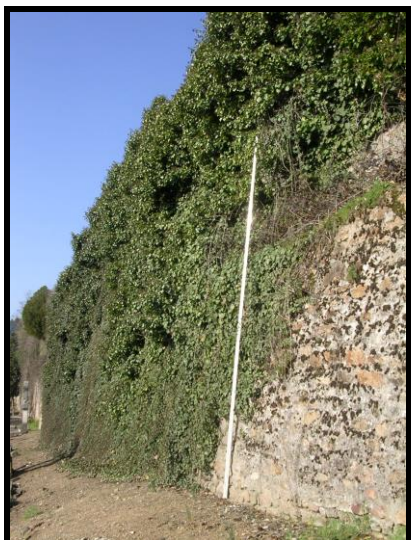
Photographie 37 : tronçon C11 (mire 4 m)
