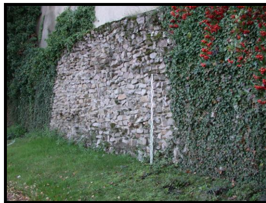
Photographie 2 : tronçon C2 (mire 2 m)
