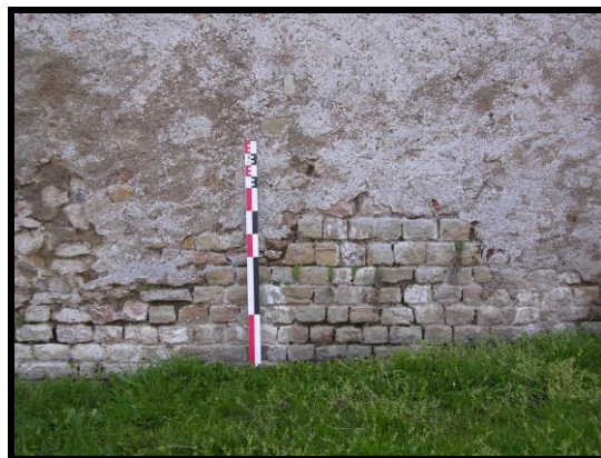
Photographie 110 : tronçon C28, détail des moellons du parement (mire 1 m)
