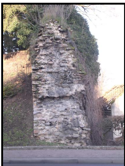
Photographie 160 : tronçon C45 : épaisseur du mur là où il est coupé pour l'avenue de la République
