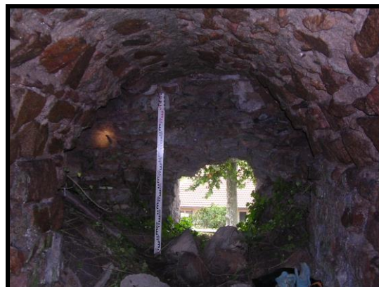
Photographie 92 : Trou du Diable, vu depuis l'intérieur du conduit (mire 1 m)
