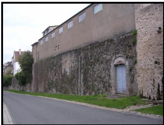
Photographie 117 : tronçon C30 (mire 5 m)
