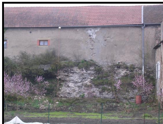
Photographie 136 : tronçon C36, le blocage romain est visible sous les bâtiments
