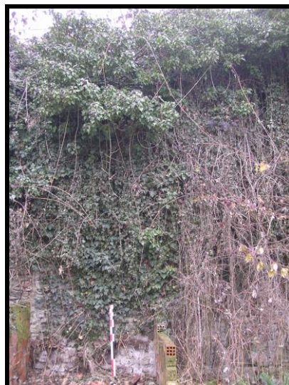
Photographie 44 : tronçon C13 (mire 1 m)
