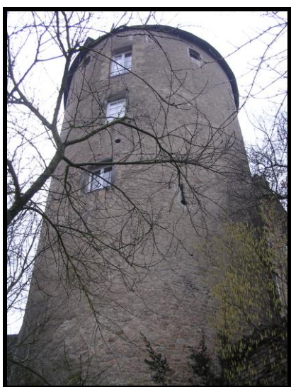
Photographie 51 : tour T8, le toit, conique, ne se voit pas sur le cliché
