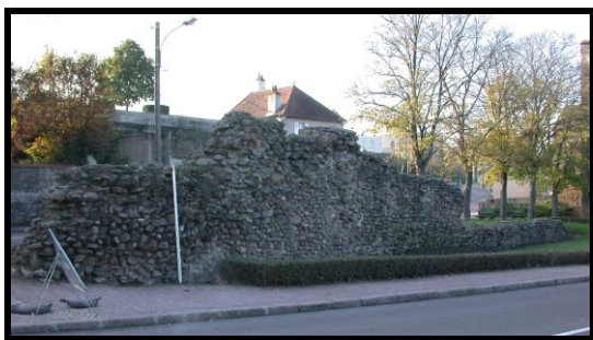
Photographie 1 : tronçon C1 (mire 2 m)
