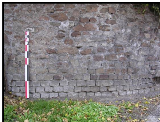
Photographie 122 : tour T22, détail des moellons du parement sur la face nord (mire 1 m)
