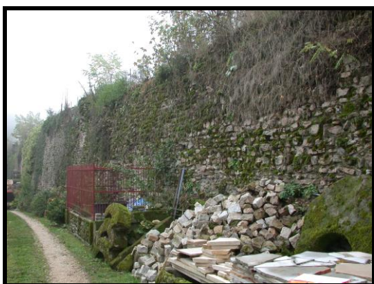
Photographie 11 : tronçon C5, chez M. et Mme Hueber
