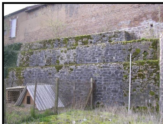
Photographie 153 : tronçon C42 (mire 3 m)
