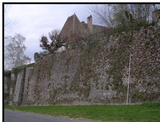
Photographie 96 : tronçon C25 (mire 5 m)
