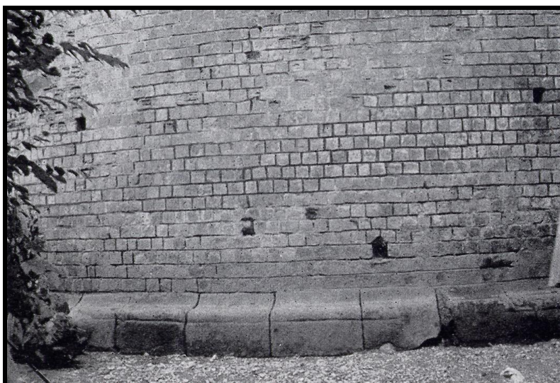
Figure 10 : Détail de la base en arkose grise, aujourd'hui recouverte, de la tour de flanquement de la Porte St-André, d'après Duval et Quoniam, 1963, p. 169.
