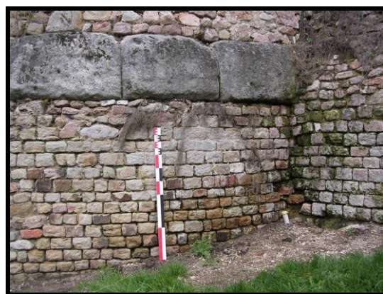
Photographie 82 : tour T15, face sud, détail des moellons du parement et des blocs de grand appareil (mire 1 m)
