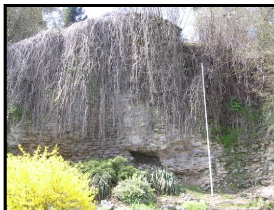
Photographie 165 : tronçon C47, chez M. Cormier (mire 5 m)
