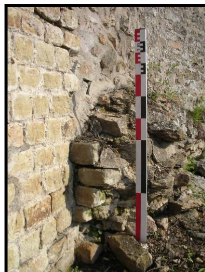
Photographie 36 : tour T5, détail des quelques moellons du parement conservés à la jonction du tronçon C11 (mire 1 m)
