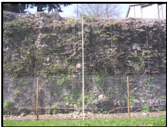
Photographie 156 : tronçon C44 (mire 5 m)
