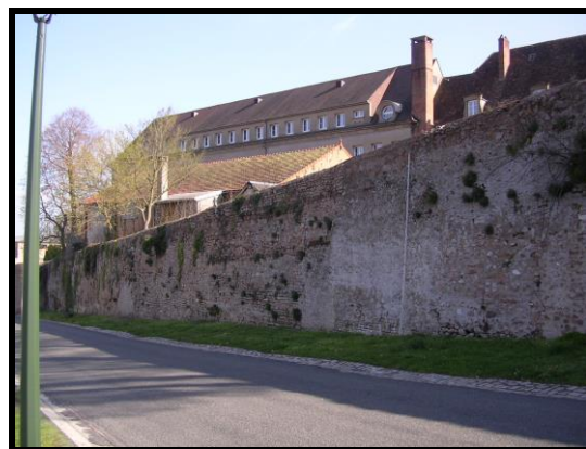
Photographie 108 : tronçon C28 (mire 5 m)
