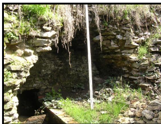
Photographie 132 : trçon C34, source ou sortie d'égout (mire 3 m)
