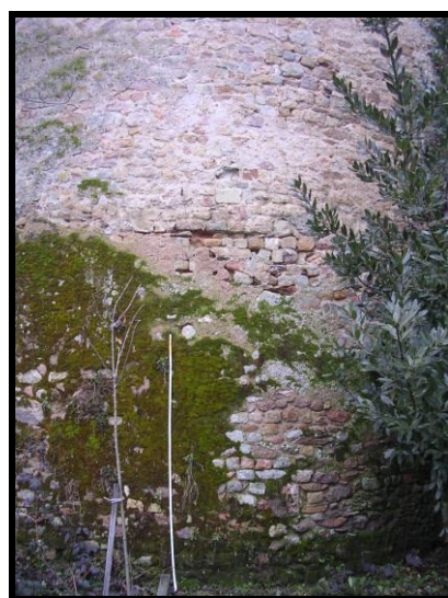
Photographie 52 : tour T8, face est, détail de la base. Quelques moellons sont visibles au-dessus de la mire
