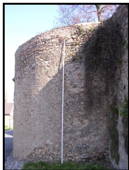
Photographie 112 : tour T20, face sud (mire 5 m)
