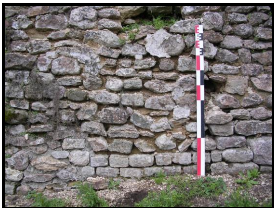
Photographie 85 : tronçon C23, détail des moellons du parement (mire 1 m)
