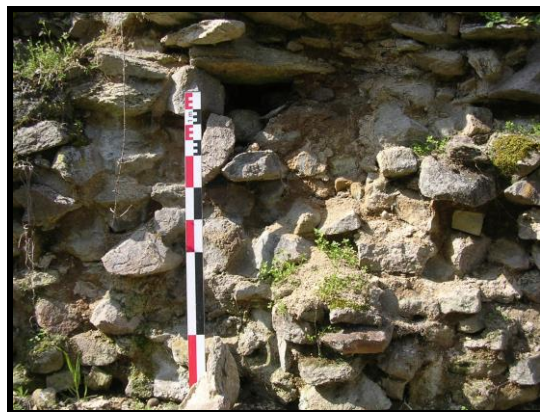
Photographie 157 : tronçon C44, détail du trou de boulin (mire 1 m)
