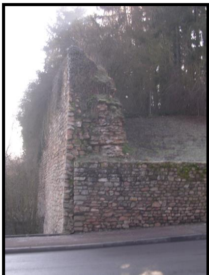
Photographie 162 : tronçon C46 : épaisseur du mur là où il est coupé pour l'avenue de la République
