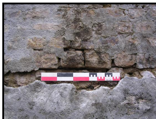
Photographie 40 : tronçon C12, détail des moellons du parement (mire 0,50 m)
