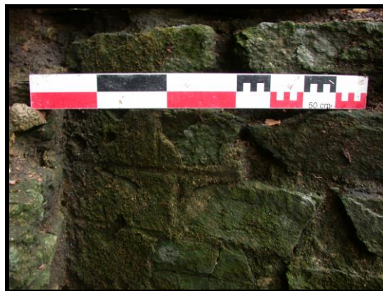
Photographie 20 : trçon C6, détail de l'enduit et du traitement des joints sur le parement, au niveau de l'angle rentrant (mire 0,50 m)
