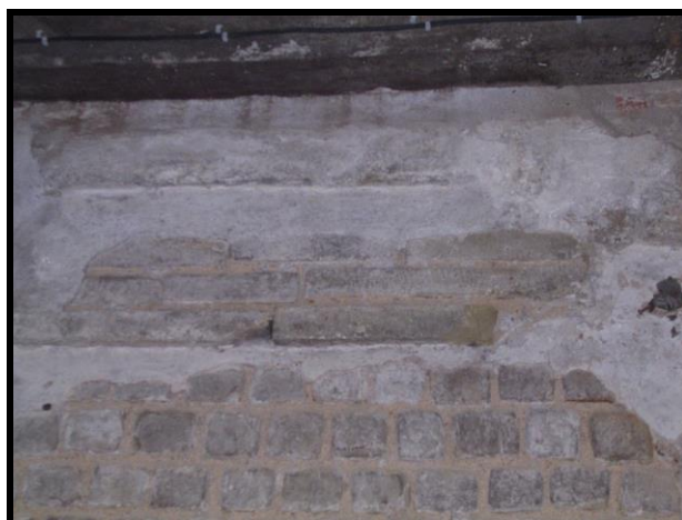
Figure 16 : Porte St-Andoche, face nord-est de la tour de flanquement sud. Détail des trois rangées de briques visibles au-dessus des moellons.
