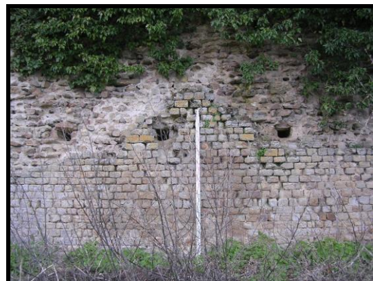
Photographie 147 : tronçon C38, détail des trous de boulin et des moellons du parement (mire 2 m)
