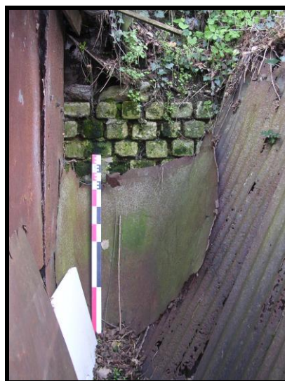
Photographie 138 : tronçon C36, détail des moellons du parement (mire 1 m)
