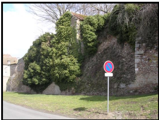
Photographie 73 : tronçon C21, vue d'ensemble
