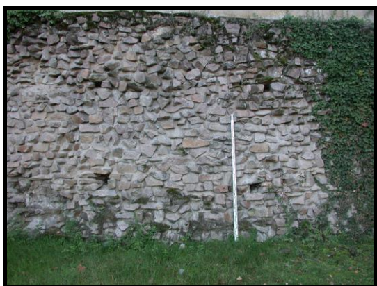
Photographie 3 : tronçon C2, détail des trous de boulin (mire 2 m)
