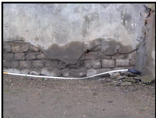
Photographie 61 : tour T10, moellons du parement visibles à la base de la tour (mire 1,40 m)
