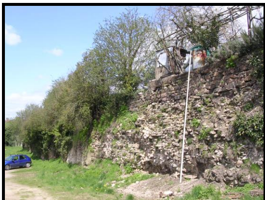
Photographie 133 : tronçon C35 (mire 5 m)
