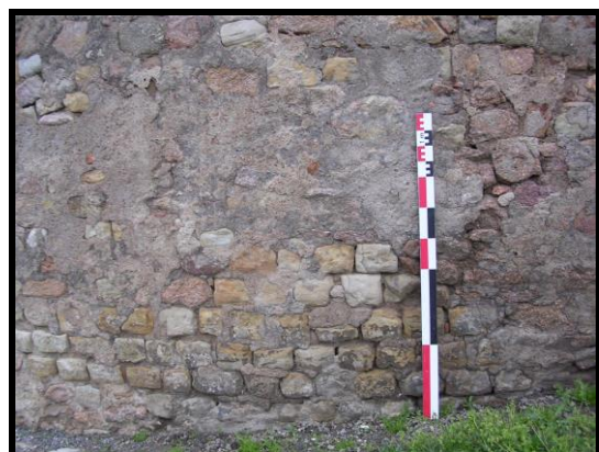
Photographie 106 : tour T19, détail des moellons du parement sur la face sud (mire 1 m)
