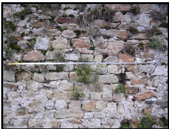
Photographie 47 : tronçon C14, détail des moellons du parement conservés (mire 1,50 m)
