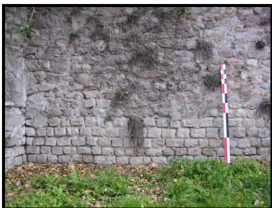
Photographie 119 : tronçon C30, détail des moellons du parement (mire 1 m)
