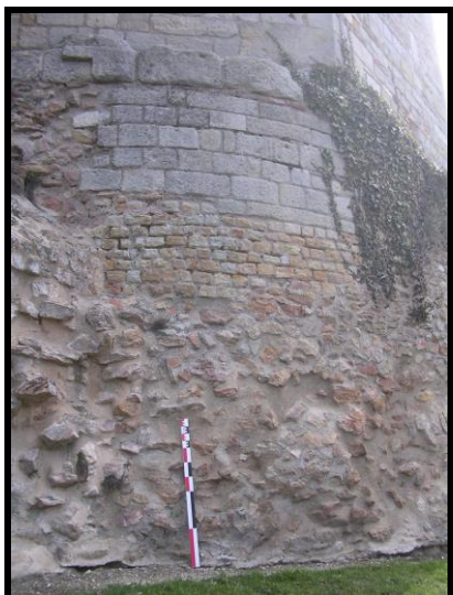
Photographie 67 : tour T12, base de la face nord-ouest (mire 1 m)
