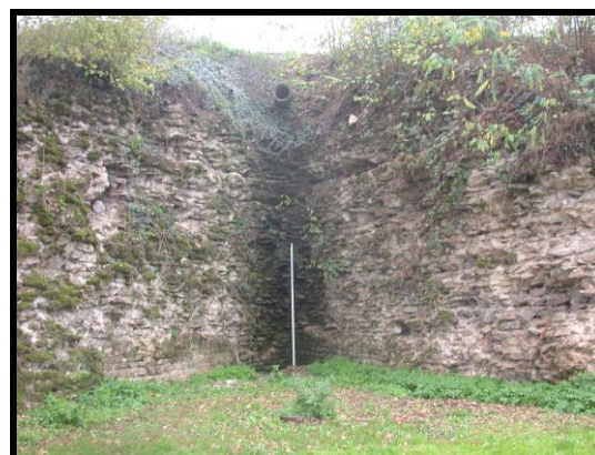
Photographie 16 : tronçon C6 (mire 3 m)
