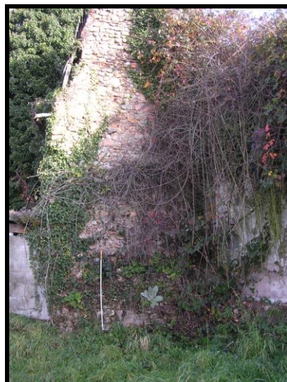
Photographie 134 : tour T24, face sud (mire 1 m)
