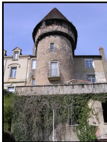
Photographie 56 : tour T9, partie supérieure avec toit conique du Moyen Âge (mire 5 m)
