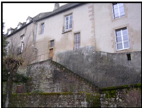
Photographie 57 : tronçon C17 : les bâtiments en place sont construits à l'aplomb de l'enceinte
