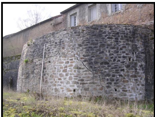
Photographie 152 : tour T27, face nord-ouest (mire 3 m)
