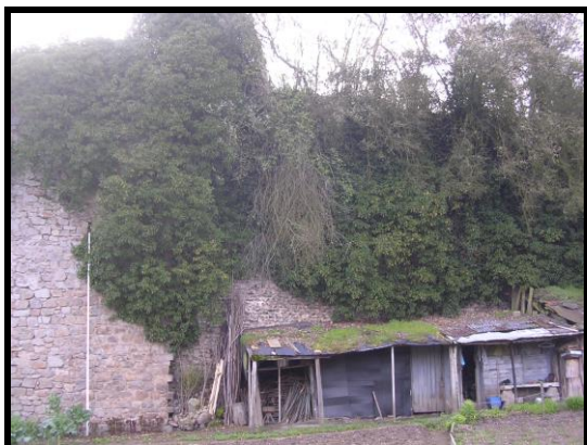
Photographie 148 : tronçon C39 (mire 5 m)
