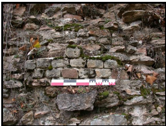
Photographie 25 : tronçon C8, détail des moellons du parement (mire 0,50 m)
