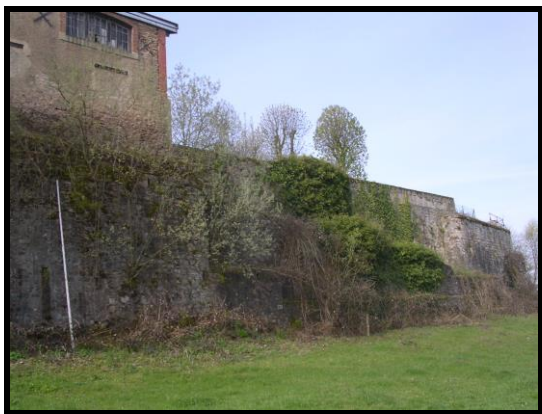
Photographie 150 : tronçon C41, partie nord-ouest (mire 5 m)
