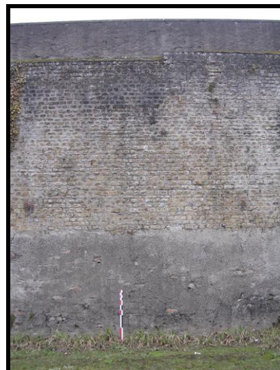
Photographie 38 : tronçon C12 (mire 1 m)
