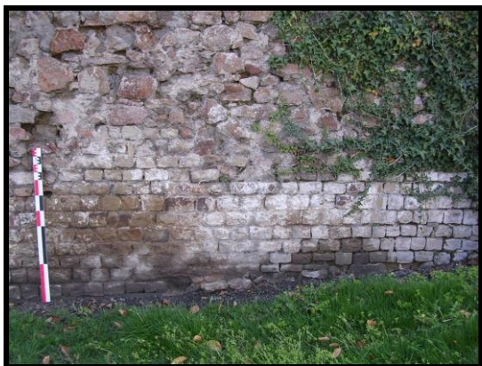
Photographie 109 : tronçon C28, détail des moellons du parement (mire 1 m)
