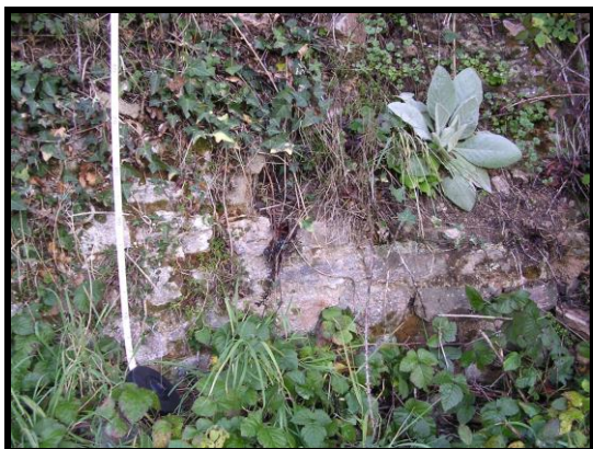
Photographie 135 : tour T24, face sud détail de la base (mire 1 m)
