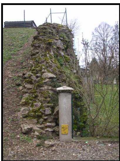
Photographie 158 : tronçon C44, épaisseur du mur vu depuis le chemin St Martin
