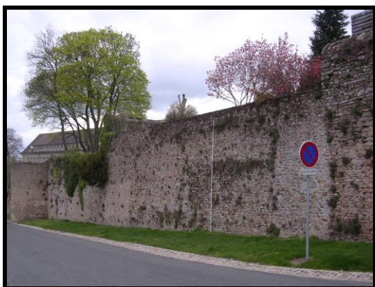
Photographie 101 : tronçon C27 (mire 5 m)
