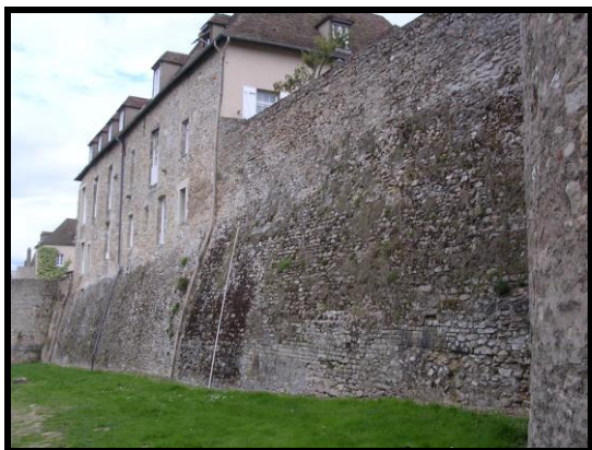
Photographie 79 : tronçon C22 (mire 5 m)
