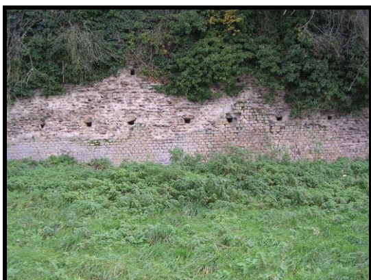
Photographie 146 : tronçon C38, trous de boulin et moellons du parement
