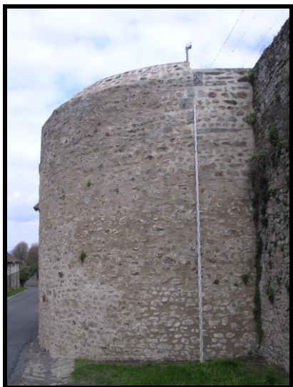
Photographie 115 : tour T21, face sud (mire 5 m)
