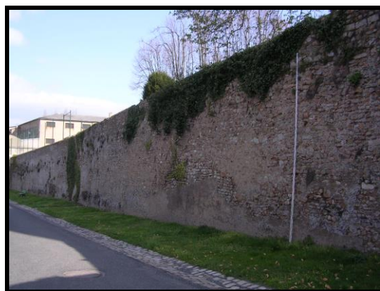
Photographie 114 : tronçon C29 (mire 5 m)
