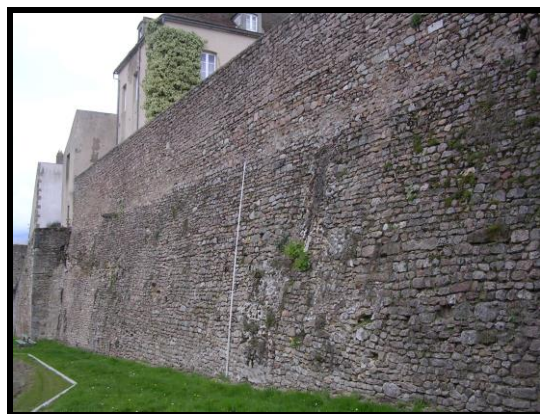
Photographie 84 : tronçon C23 (mire 5 m)
