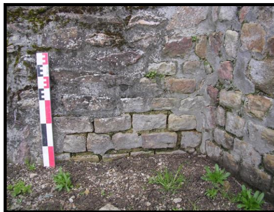
Photographie 90 : tronçon C24, détail des moellons du parement à la jonction avec la tour T16 (mire 0,50 m)
