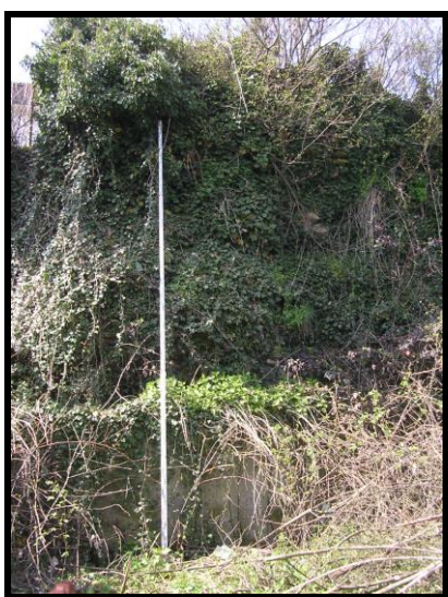
Photographie 154 : tronçon C43 (mire 5 m)
