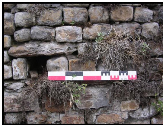
Photographie 50 : tronçon C15, détail des moellons du parement et trou de boulin (mire 0,50 m)
