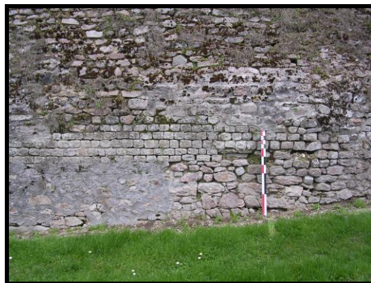
Photographie 80 : tronçon C22, détail des moellons du parement (mire 1 m)
