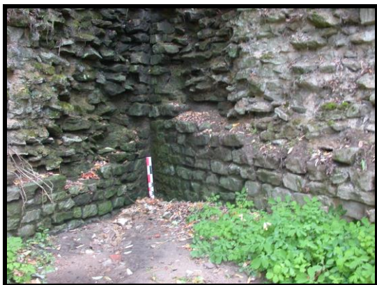
Photographie 19 : trçon C6, détail des moellons du parement dans l'angle rentrant (mire 0,50 m)
