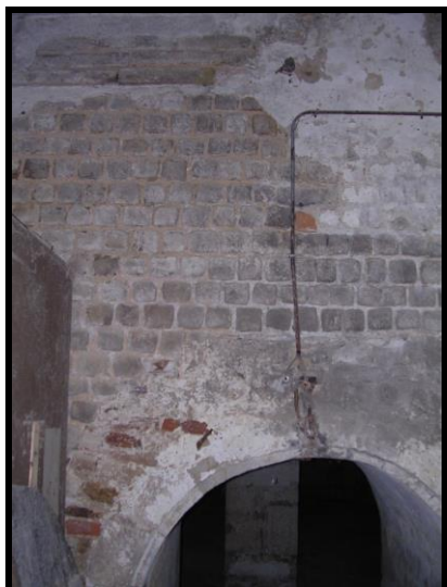
Figure 15 : Porte St-Andoche, détail du parement de la face nord-est de la tour de flanquement sud. Trois rangées de briques sont visibles au-dessus des moellons.
