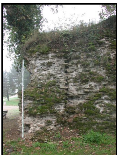
Photographie 17 : tronçon C6, face sud (mire 3 m)
