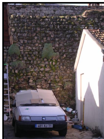
Photographie 169 : tronçon C48, au n° 5 de la route d'Arnay
