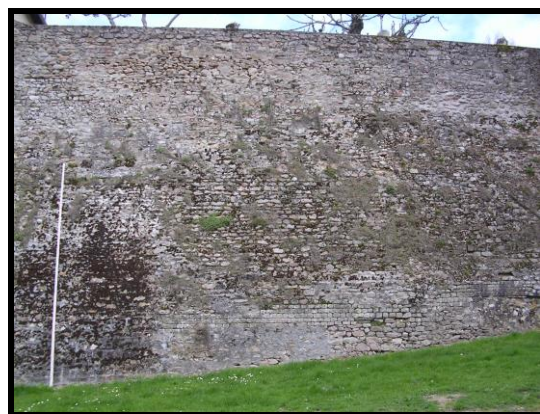
Photographie 78 : tronçon C22 (mire 5 m)
