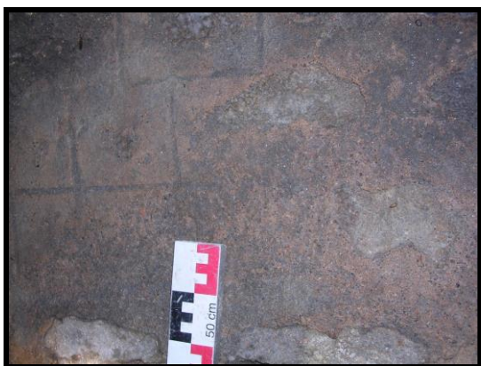
Photographie 93 : Trou du Diable, détail de l'enduit recouvrant le parement intra-muros et du traitement des joints
