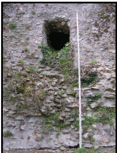
Photographie 91 : Trou du Diable, ouverture côté boulevard Mac Mahon (mire 4 m)
