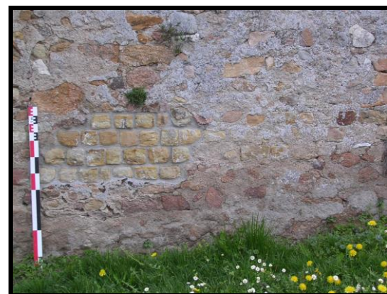
Photographie 102 : tronçon C27, détail des moellons du parement (mire 1 m)
