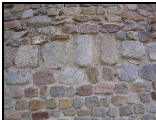
Photographie 72 : tour T13, détail des moellons du parement et des rangées de blocs de petit et moyen appareils
