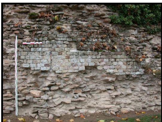
Photographie 23 : trçon C8, détail des moellons du parement (mires 2 m et 0,50 m)
