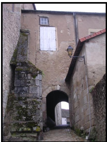
Photographie 59 : tronçon C17, poterne médiévale dite Porte du Breuil
