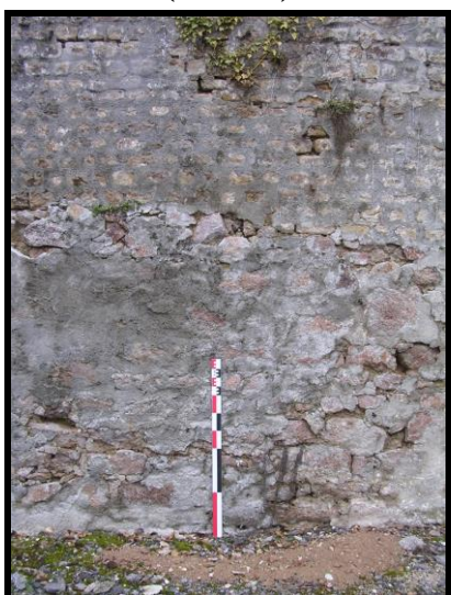
Photographie 39 : tronçon C12, détail de la base du mur (mire 1 m)
