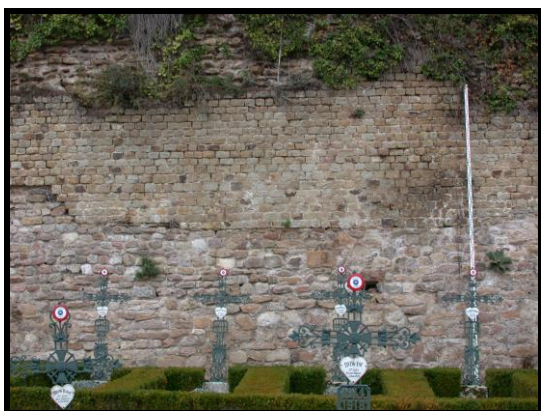
Photographie 27 : tronçon C9, vue d'ensemble avec moellons du parement (mire 4 m)
