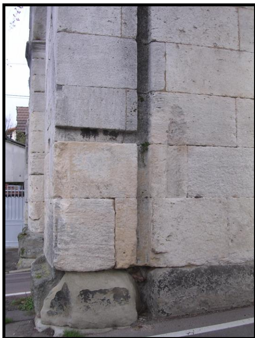
Figure 23 : Porte d'Arroux, détail de la rainure permettant le passage de la herse, grande baie occidentale.
