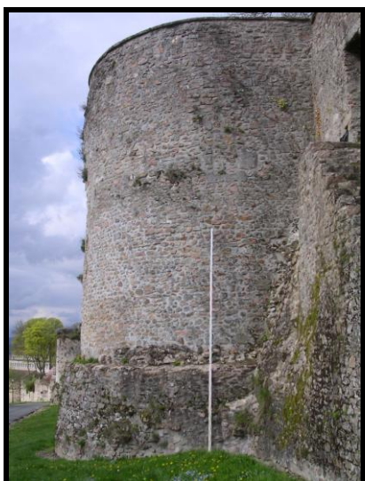
Photographie 95 : tour T17, face sud (mire 5 m)
