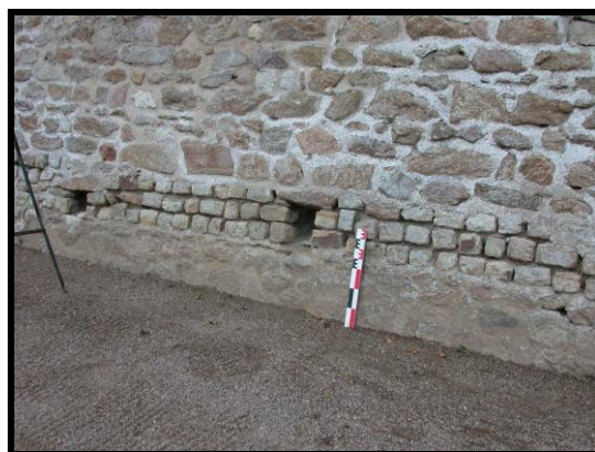
Photographie 28 : tronçon C9, détail de la base du mur avec trous de boulin et moellons du parement (mire 0,50 m)
