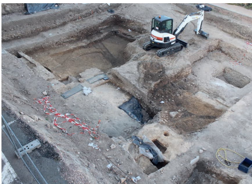
III. 2 – Vue de l'emprise en cours de fouille, avec utilisation de la minipelle mécanique.
