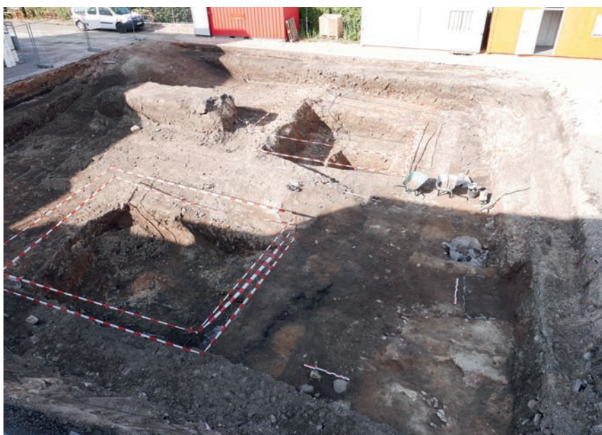
III. 1 – Vue de l'emprise après décapage, avec mise en sécurité des deux sondages profonds réalisés lors du diagnostic.
