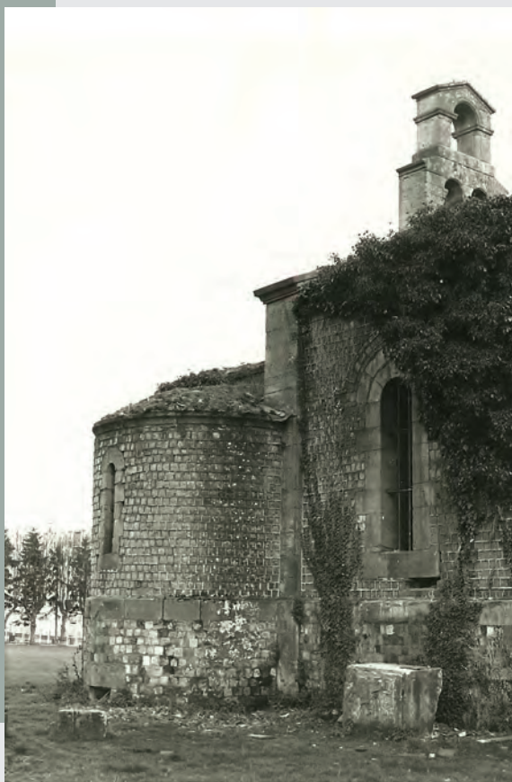
Fig. 5 La chapelle néo romane en 1976 peu de temps avant sa démolition partielle pour cause de délabrement. Il n'en reste actuellement que la façade du parvis. Cliché Chr. Sapin.
