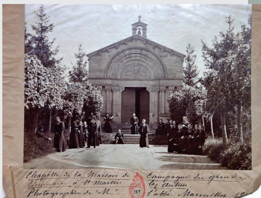
Fig. 4 Chapelle néo romane édifée en 1854 à l'emplacement approximatif du chevet de l'église abbatiale Saint-Martin. Cliché pris à la fin du XIX e s. lorsqu'elle servait de résidence d'été aux élèves du grand séminaire d'Autun. Archives de la Société Eduenne.
