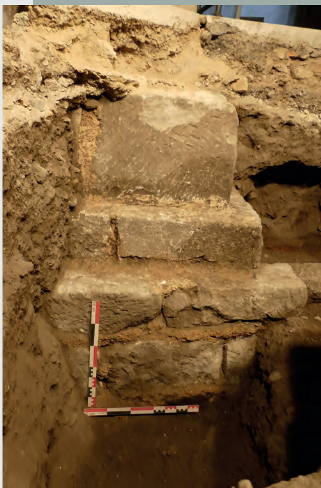
Fig. 4 Massif de fondation d'époque romane d'une des piles séparant la nef du collatéral, composé d'un assemblage de blocs de grès quadrangulaires de grandes tailles, en partie des remplois d'époque romaine. Le profil de ces massifs adopte généralement plusieurs ressauts de fondation successifs. On note l'absence de murs de chaînage. Cliché Y. Labaune.
