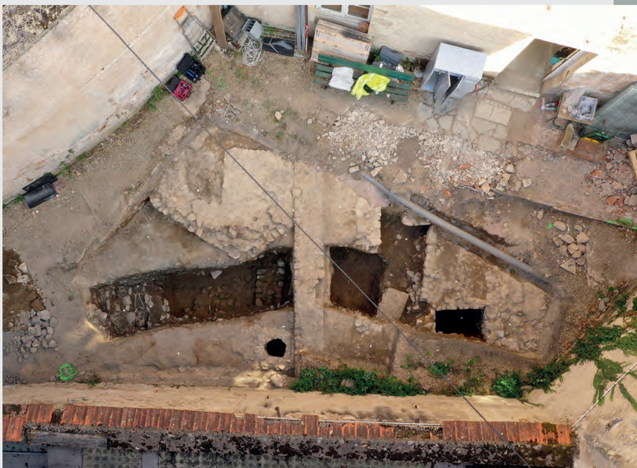
Fig. 19 L'un des sondages ouvert à l'emplacement de la grande maison canoniale du XV e s. détruite au XIX e s. préalablement à la construction de la prison circulaire. En haut à gauche du cliché on observe les fondations d'une tour d'escalier de plan hexagonal (qui ressemblait à la tour de l'hôtel Rolin) (cliché agence Com'air, Chalon-sur-Saône).
