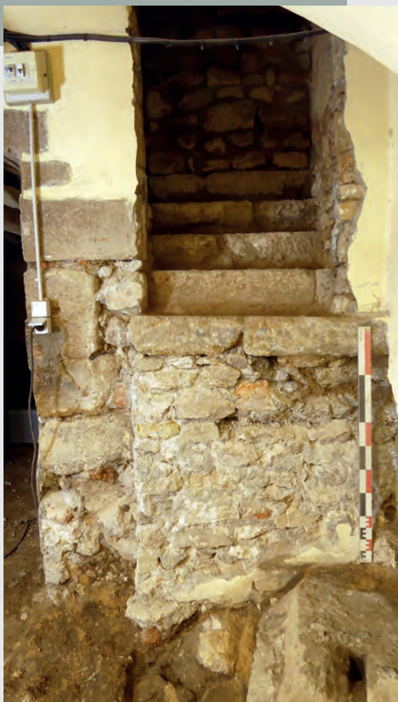
Fig. 10 Escalier d'accès à l'intérieur du « Donjon » découvert après décaissage (cliché C. Couderc).
