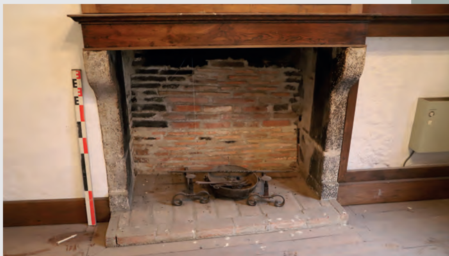
Fig. 5 Cheminée du premier étage (Cliché C. Couderc)
