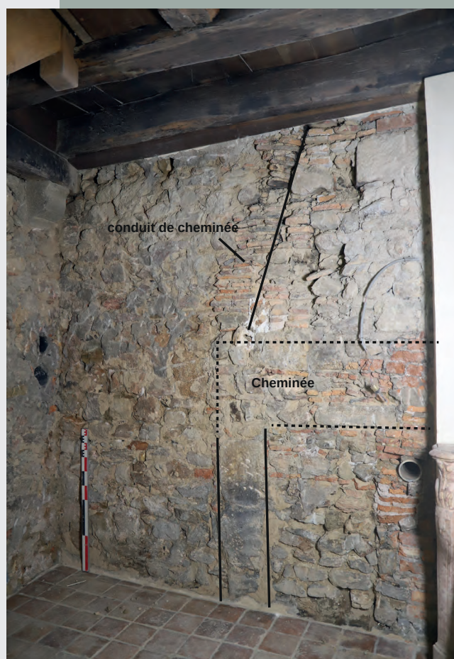
Fig. 7 Localisation de la cheminée appartenant très certainement à la phase d'occupation du rez-de-chaussée par une forge (Cliché C. Couderc)
