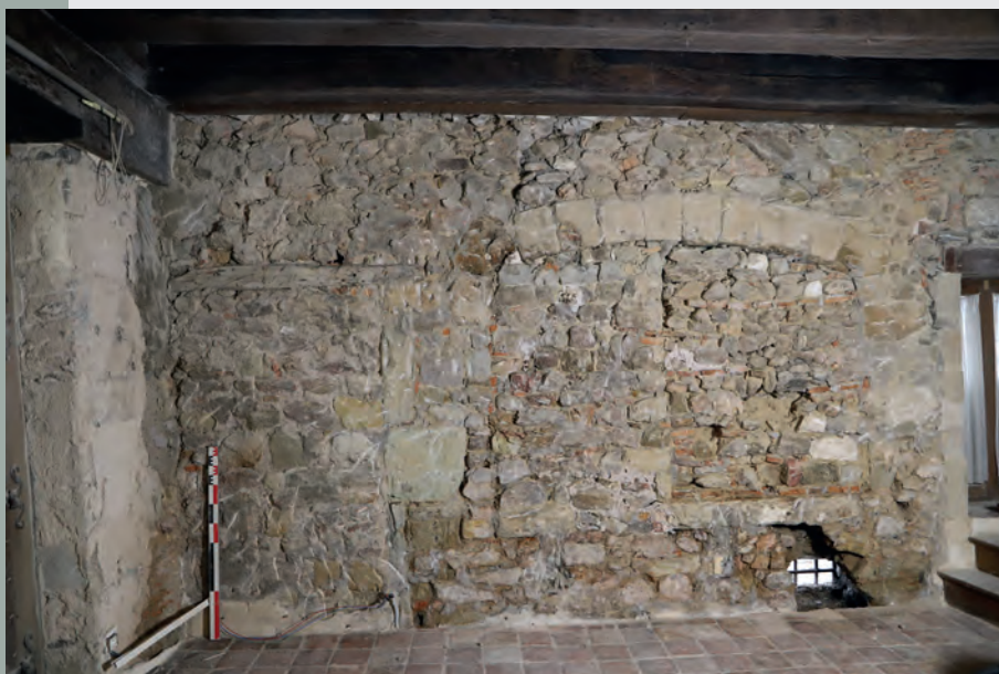
Fig. 3 Vue générale du mur sud présentant une arcade centrale ainsi qu'une porte bouchée (Cliché C. Couderc)
