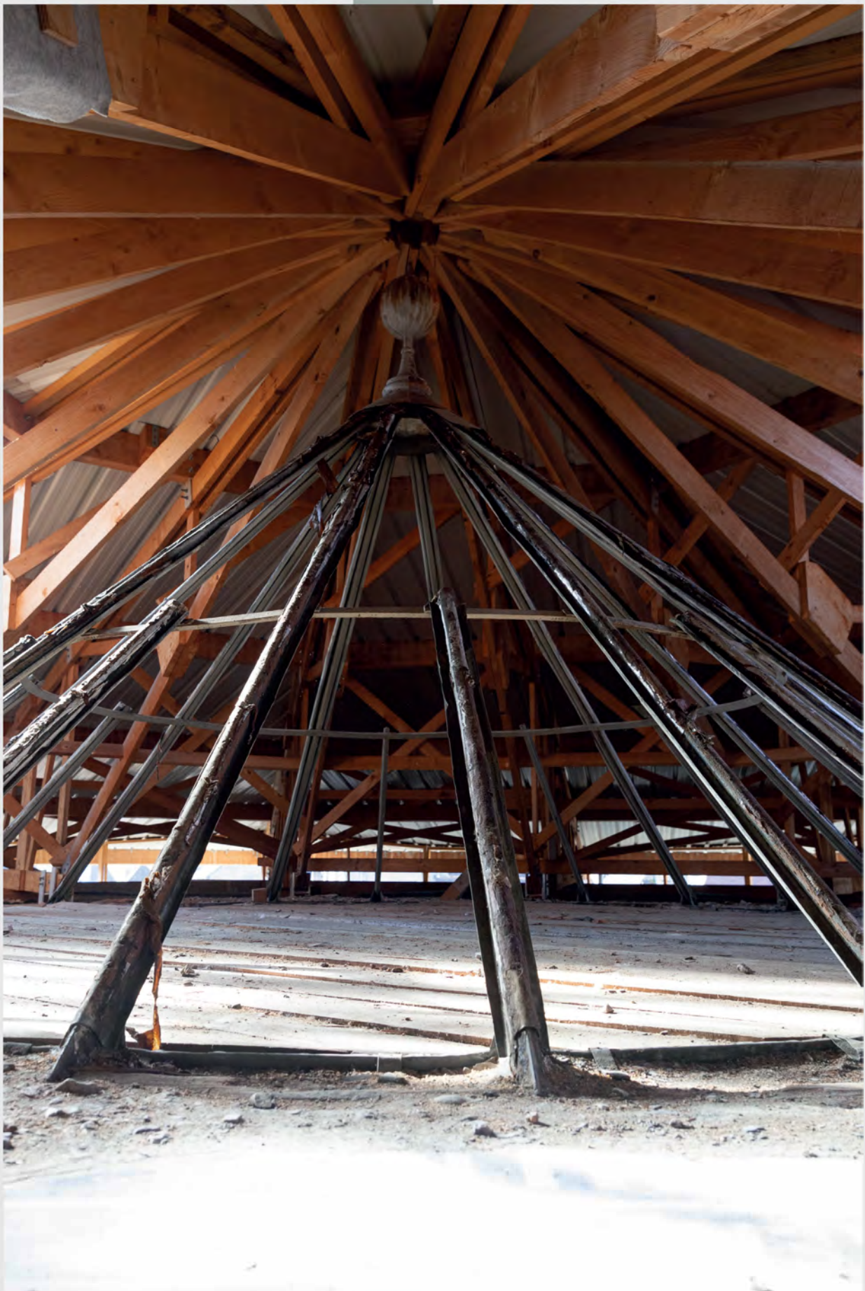
Vue de la structure de la verrière qui surmontait la prison panoptique. (Cliché A. Cazin)
