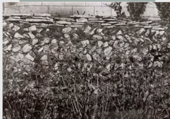
Fig. 5. Exemple de parement témoignant de la disposition interne du blocage. (Cliché : Archives du musée Denon, cote 013/90-2)
