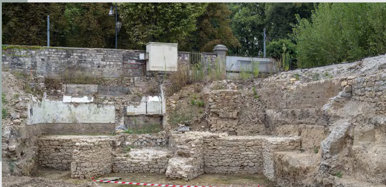
Fig. 3. Saint-Jacques, vue générale du parement interne et des redents du rempart Vauban (fin XVII e s.). (Cliché N. Waltefaugle)
