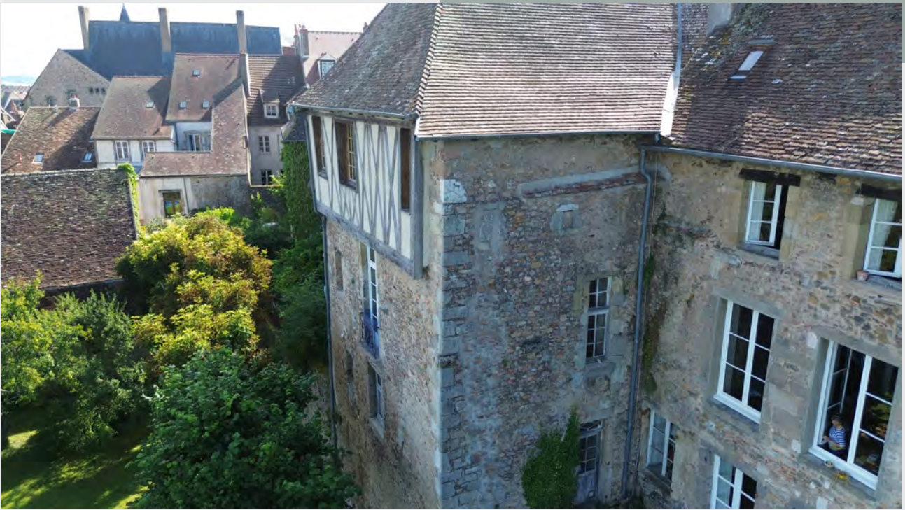
Fig. 9. Vue des vestiges d'une imposante tour de flanquement conservée au nord de l'impasse de la Maîtrise. (Cliché A. Belot)
