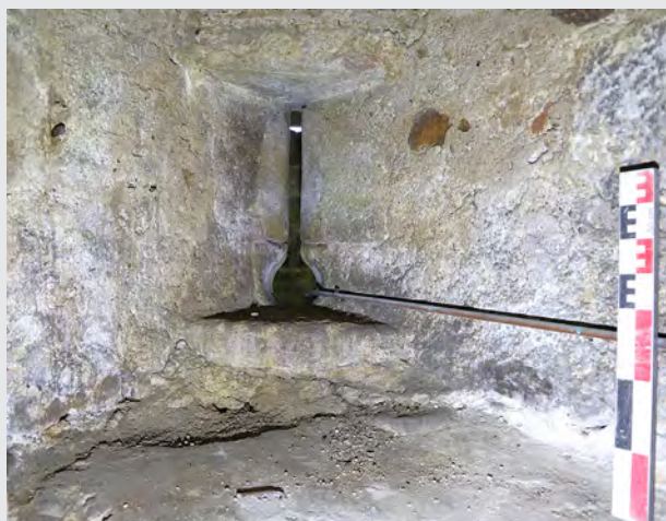
Fig. 11 et 12. Exemples d'archères-canonniers conservées dans les maisons autour de l'impasse de la Maîtrise. (Clichés A. Belot)
